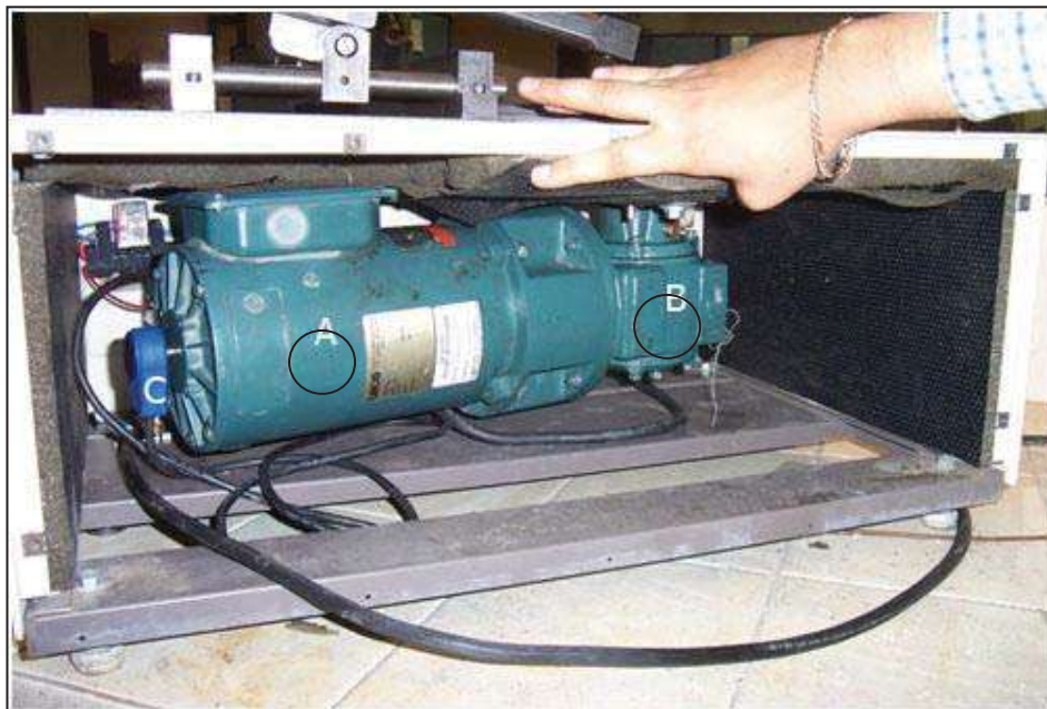
Figura 3.17 Motor eléctrico (A) acoplado al reductor de velocidad (B) y al sensor de velocidad (C).
