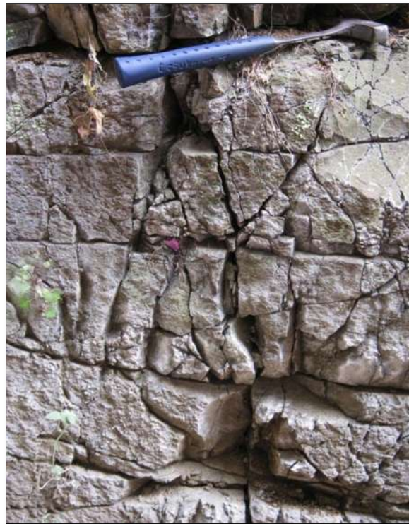
Figura 45.- Detalle del fracturamiento en la Andesita (Estación And-4).
