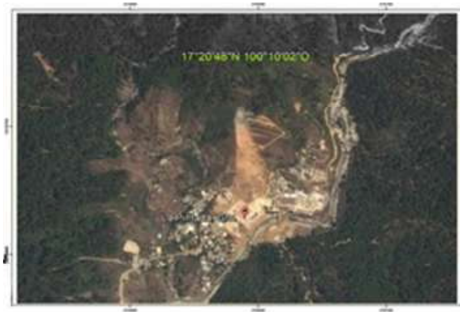
Figura. 18.1 Localización del deslizamiento de La Pintada Gro.
