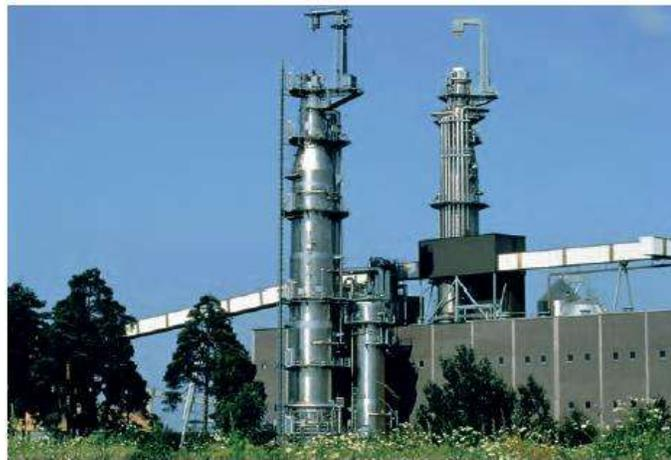
**Figura 2.2** Torre de impregnación u digestión continua de pulpa de sulfato, en EN-1.4462(2205) [14].
