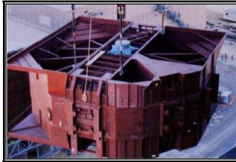
Figura 1-8. Precalentador de aire Tri-sector.
