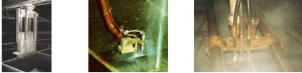
Figura 3-2. Dispositivos para el lavado con agua de un precalentador de aire.
