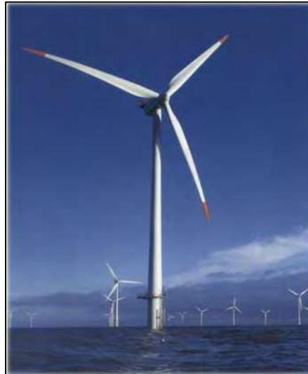
Figura 1.4. Aerogenerador moderno de tipo hélice de eje horizontal (fuente: <http://www.dforcesolar.com/energia-solar/turbinas-de-viento/>).
