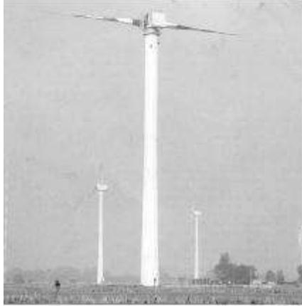
**Figura 1.2.** Turbina AEOLUS II con generador de eje vertical.
