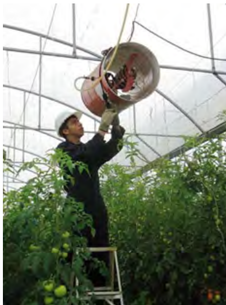
Figura C.7: Calefacción de invernaderos mediante calentadores de aire por combustión [75].
