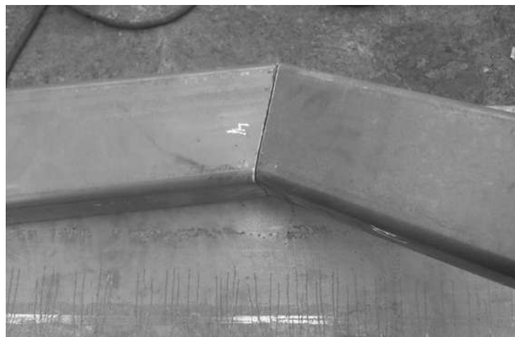
Figura 5. 10. Acoplamiento de las dos primeras partes del primer larguero.
