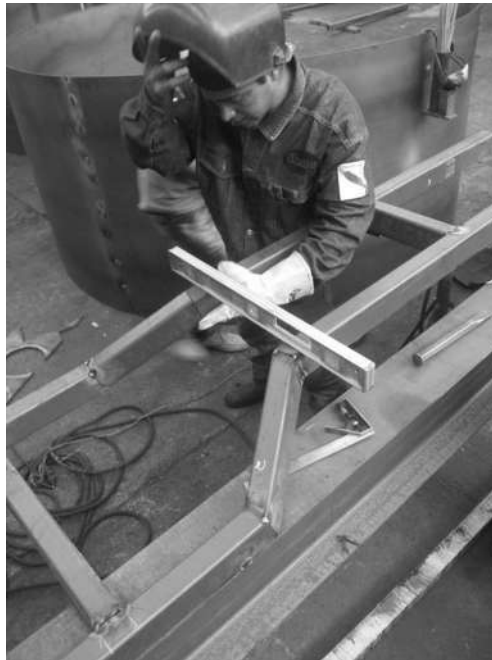
Figura 5. 14. Colocación y nivelación de la última parte del segundo larguero.
