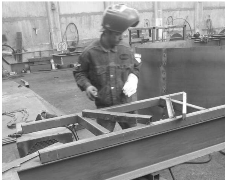
Figura 5. 13. Unión y nivelación del segundo larguero.
