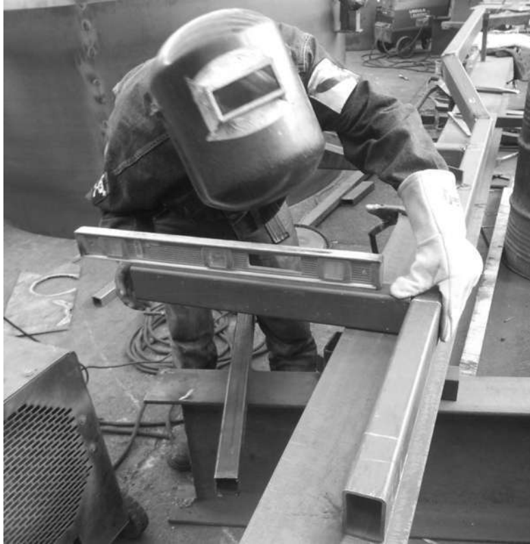
Figura 5. 12. Colocación y nivelación del travesaño trasero.
