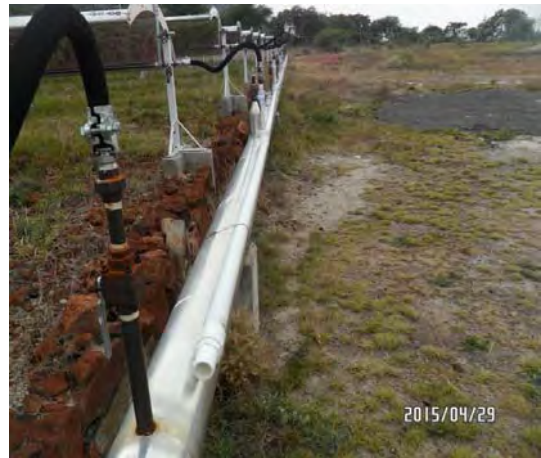
Figura 44. Conexión para manguera a la entrada y salida de los colectores parabólicos
