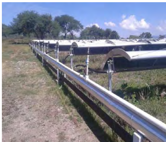
Figura 46. Cabezal de entrada a los colectores parabólicos
