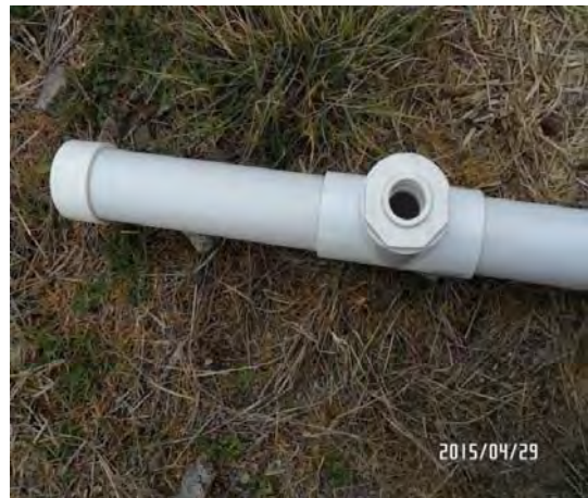
Figura 42. Conexión de accesorios al final del cabezal de entrada
