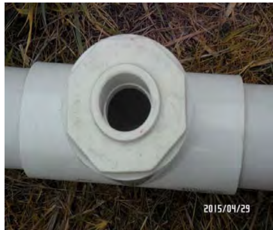
Figura 41. Conexión de reducciones para derivación a la línea de colectores parabólicos
