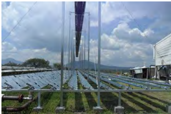
Figura 35. Campo de concentradores fresnel lineales
