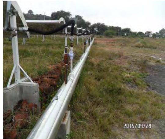
Figura 47. Cabezal de salida los colectores parabólicos
