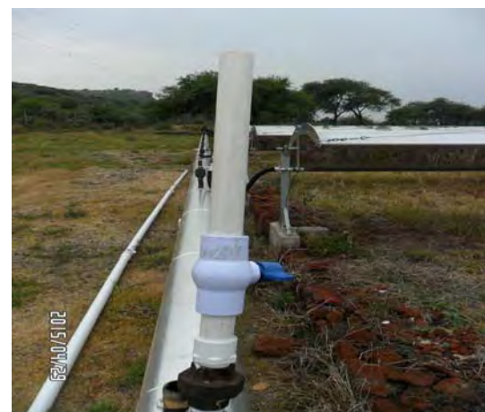
Figura 43. Conexión de válvula de corte a una línea de colectores parabólicos
