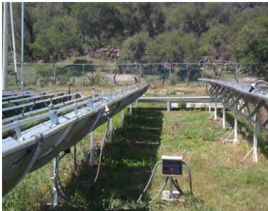
Figura 52. Control para el movimiento de los colectores solares
