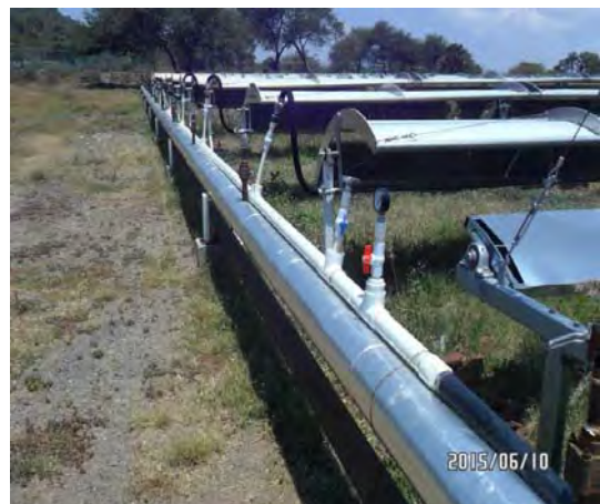
Figura 46. Cabezal de entrada a los colectores parabólicos
