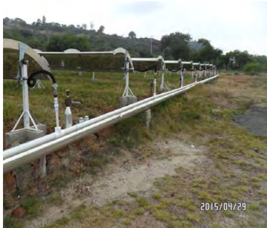
Figura 47. Cabezal de salida los colectores parabólicos
