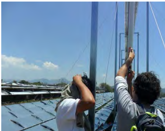
Figura 54. Conexiones del medidor de flujo en línea del colector fresnel
