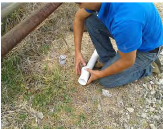
Figura 40. Conexión de T para derivación a la línea de colectores parabólicos
