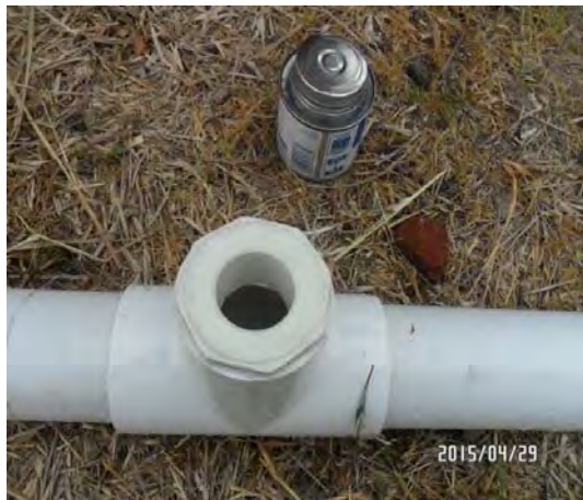
Figura 41. Conexión de reducciones para derivación a la línea de colectores parabólicos
