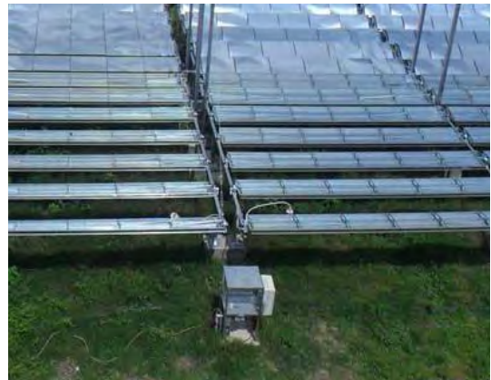
Figura 52. Control para el movimiento de los colectores solares
