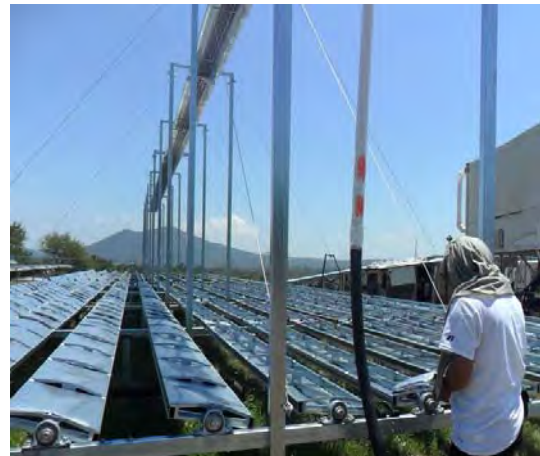
Figura 48. Conexión a la entrada de colectores fresnel
