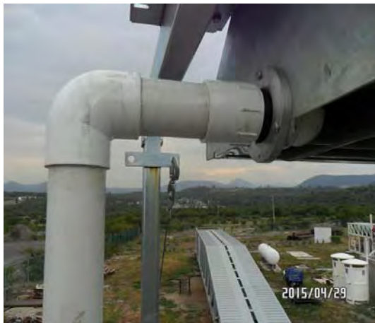
Figura 49. Conexiones a la salida de los colectores fresnel
