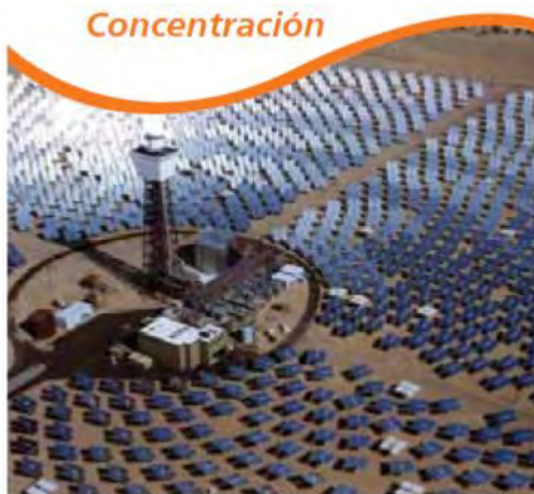
Figura 9. Concentradores con torre de concentración
