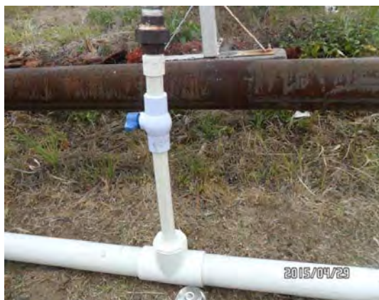
Figura 45. Conexión del ramal a la entrada y salida de los colectores parabólicos
