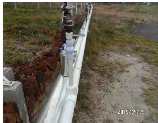
Figura 45. Conexión del ramal a la entrada y salida de los colectores parabólicos
