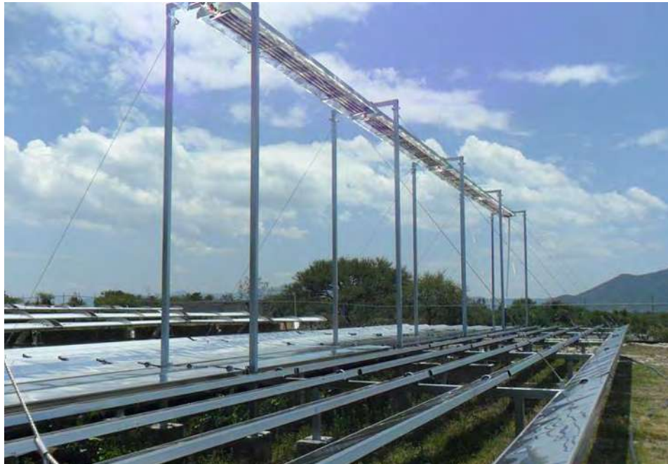
Figura 11. Concentradores fresnel lineal
