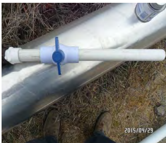
Figura 43. Conexión de válvula de corte a una línea de colectores parabólicos
