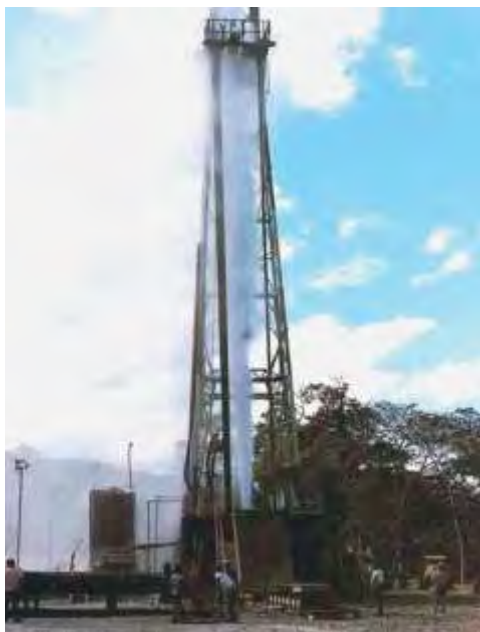
Figura 1.7. Plataforma de perforación [9].
