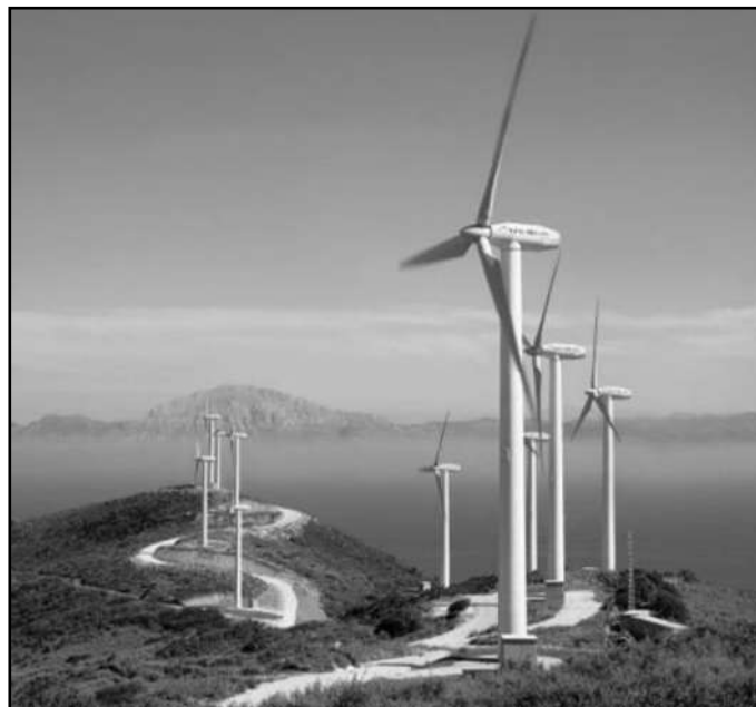
Figura 10. Parque eólico de 600 kW, turbinas eólicas de 43 m de diámetro, Tarifa, España [24].
