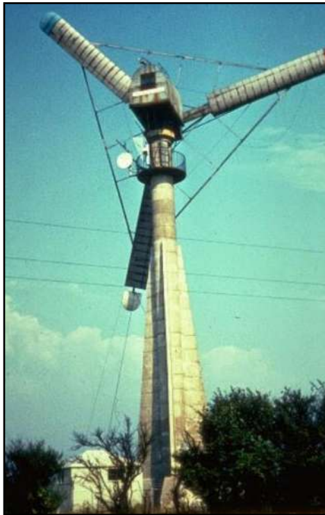
Figura 9. Aerogenerador Gedser (200 kW, 24 m) [21].
