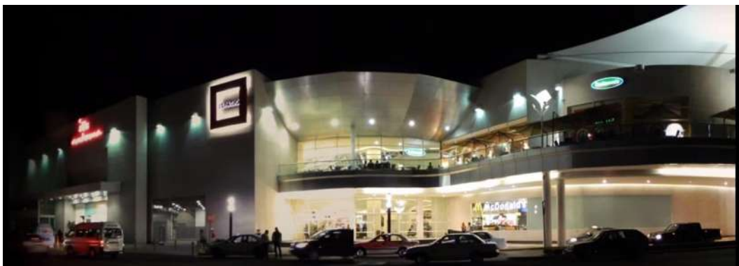
Figura 3.2. Vista parcial del centro comercial (4ta etapa).
