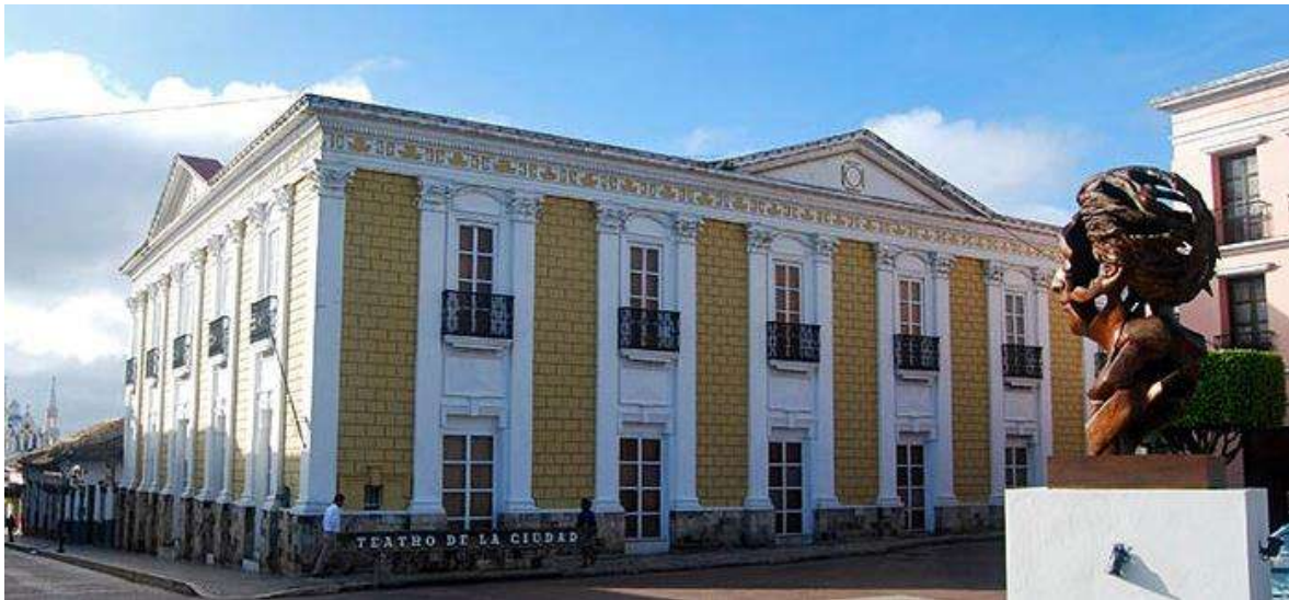
Figura 71: Estado actual del Teatro “Junchavín” Comitán, Chiapas. Fuente: Propia, 2021.
