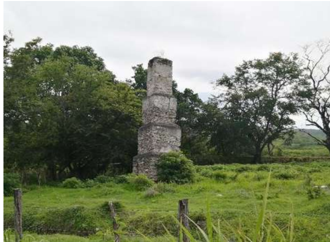
Figura 62: Vestigios de la chimenea, Hacienda San Pedro, Comitán, Chiapas.
