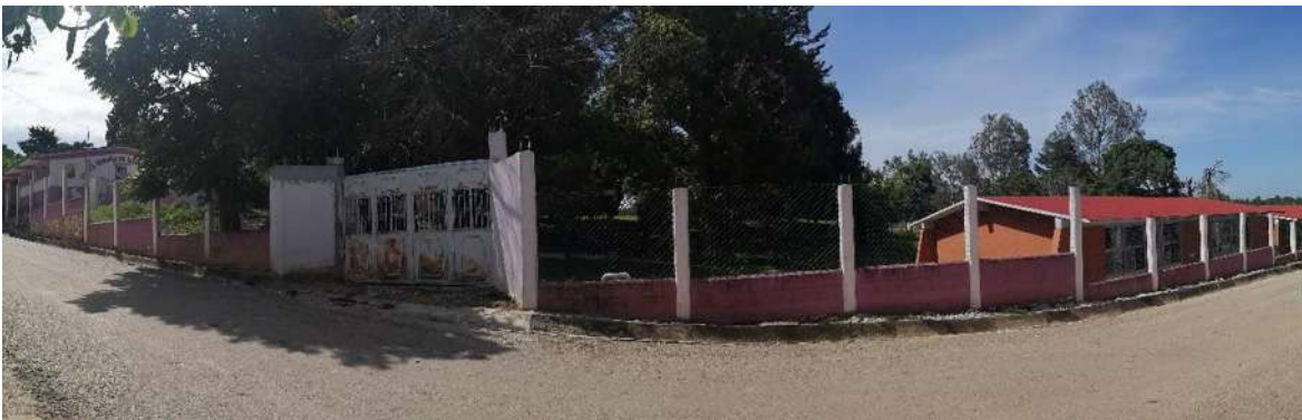
Figura 60: Escuela Primaria Estatal del Ejido Francisco Sarabia, dentro de este predio es donde se encuentran los vestigios de cimentación de la Hacienda El Puente, Comitán.
