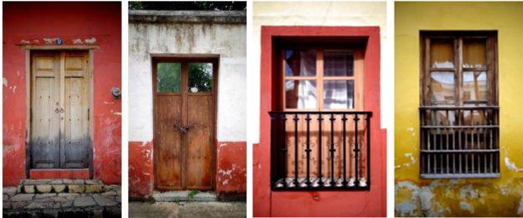
Figura 65: Tipología de puertas y ventanas de viviendas construidas a finales del siglo XIX, Comitán, Chiapas.
