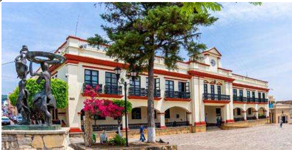
Figura 70: Estado actual del Palacio Municipal de Comitán, Chiapas. Fuente: Propia, 2021.
