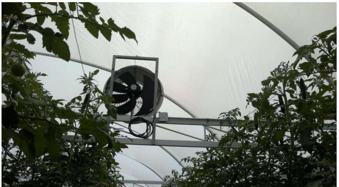
*Figura 41, ventilador para regular la temperatura dentro del invernadero fotos: Dinorah Quesada, 2013).*
