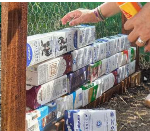
Continuación de hiladas de bricks
