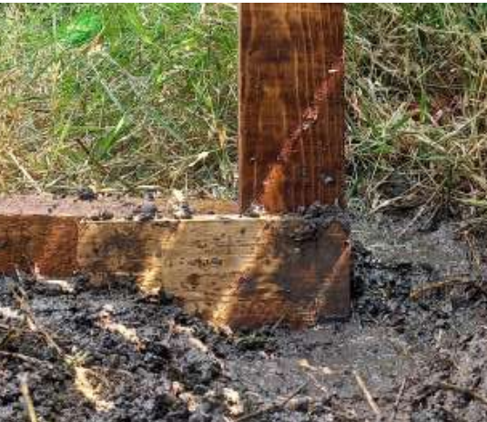
Poste ahogado y apisonado
