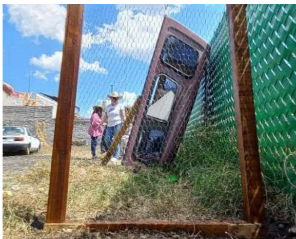
Montaje de marco con malla
