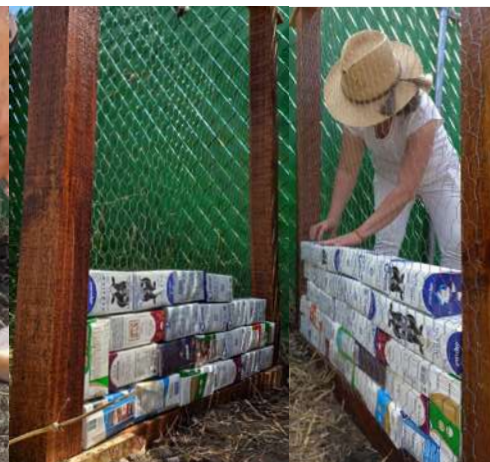
Continuación de hiladas de bricks
