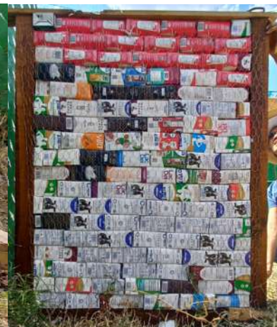
Muro nucleo de bricks
