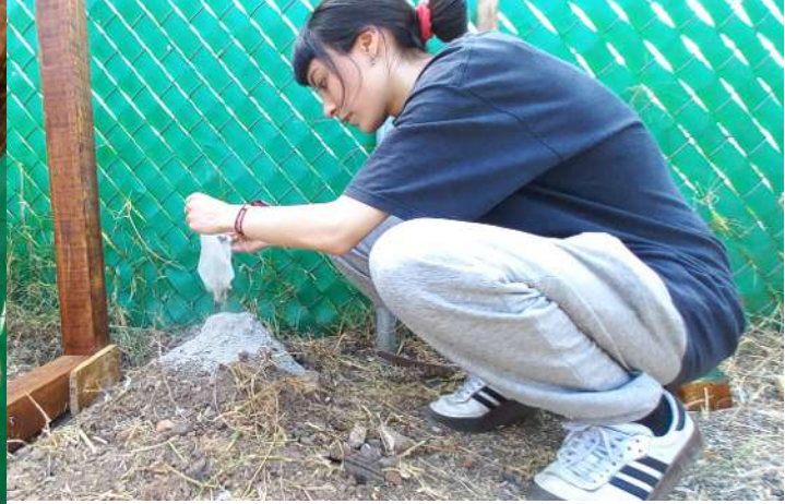
preparación de mezcla de mortero y tierra del lugar
