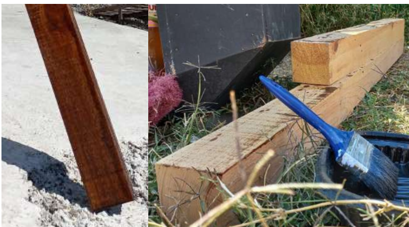
Aceitado y secado de polines
