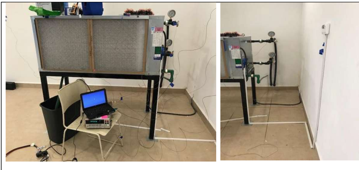
Figura 41. Computadora para el almacenamiento de datos de temperatura de los sensores y termostato.
