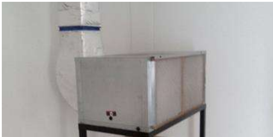
Figura 11. Bomba de calor instalada SmartSource de Daikin tipo horizontal.
