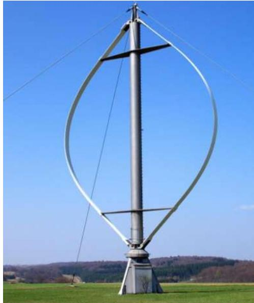
**Figura 2.7** Aerogenerador de Eje Vertical tipo Darrieus [19].
