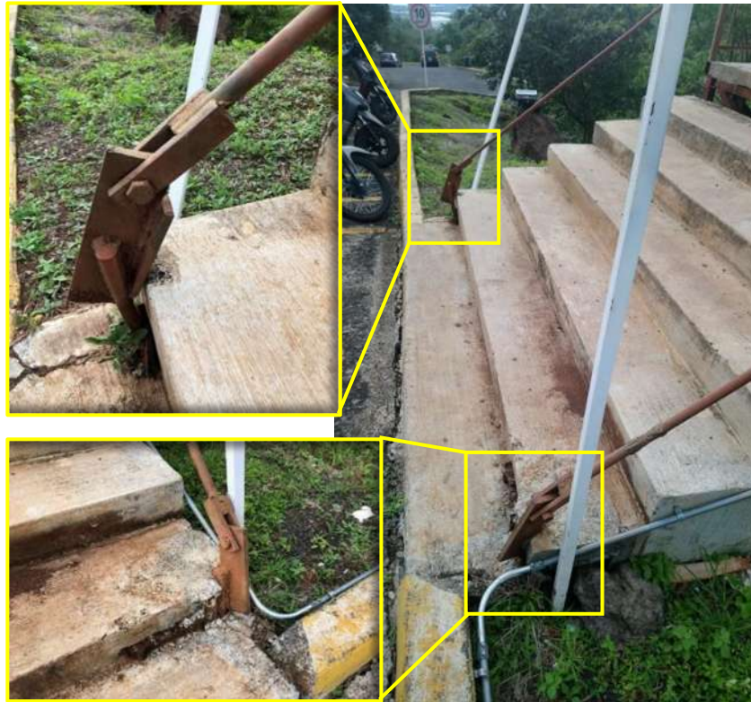
Figura 6.7 Detalle de anclaje en escaleras
