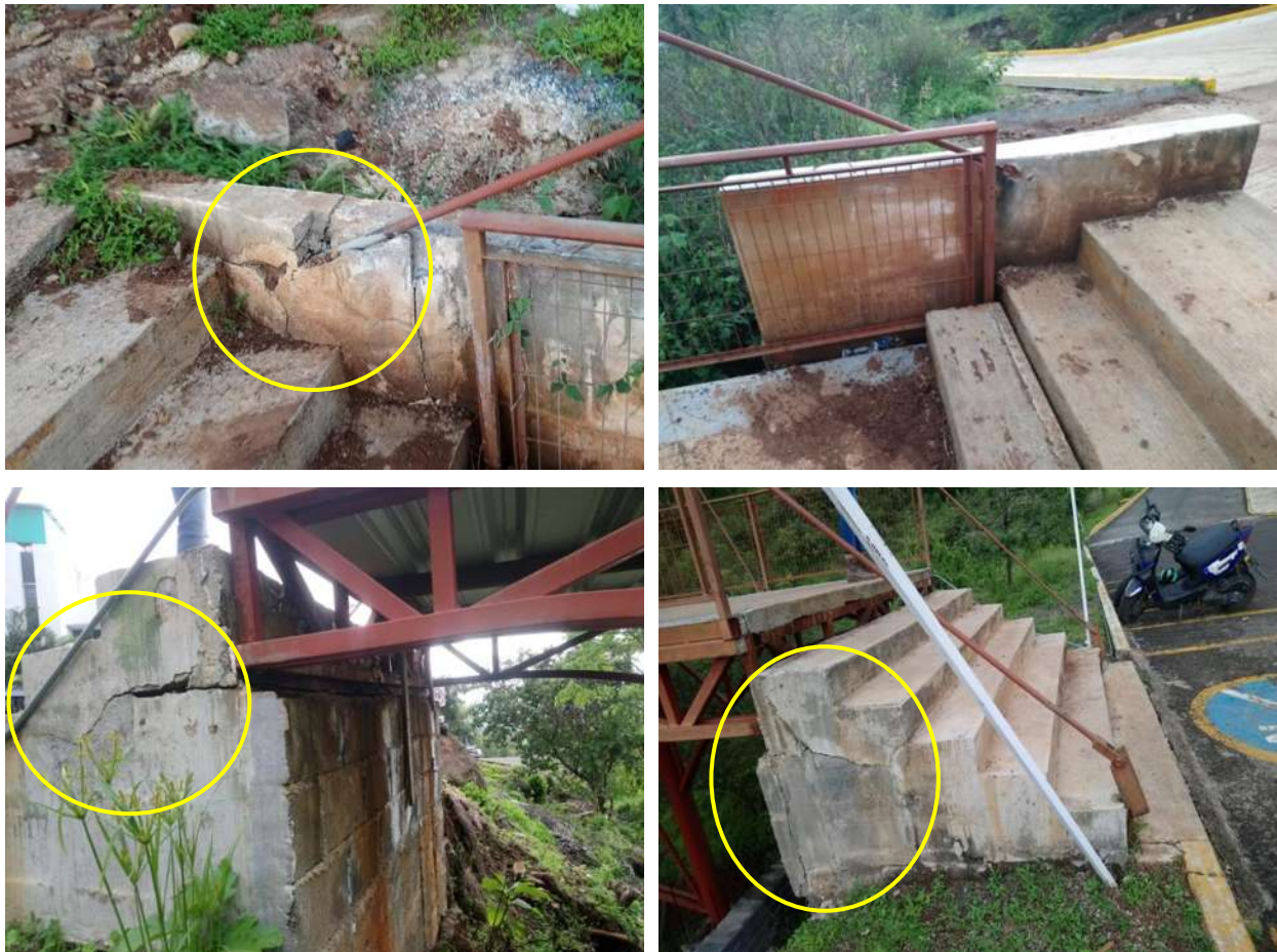
Figura 6.6 Detalle en escaleras
