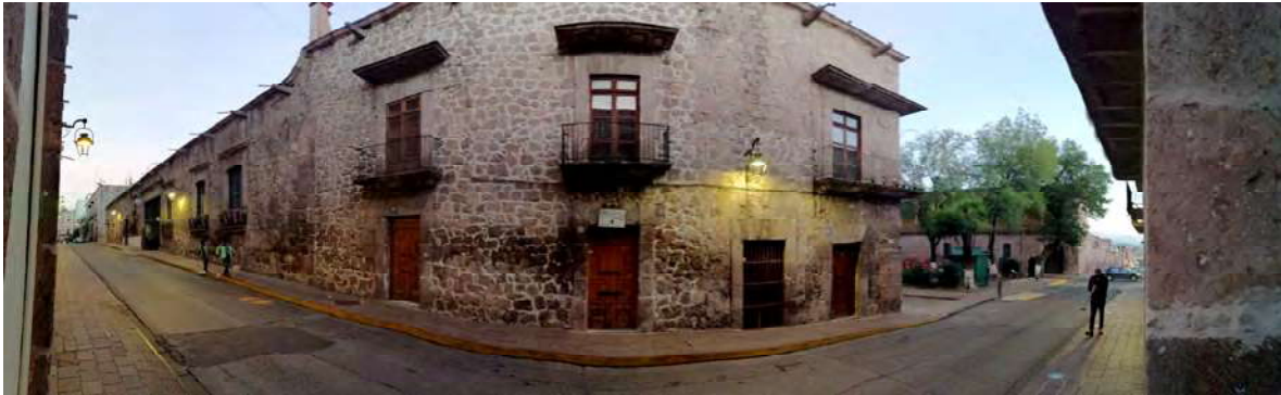
FIGURA 41. Vanos, jambas y platabandas sencillas de cantera, repisa bajo el balcón volada puertas de acceso y marcos de ventanas y contraventanas de madera. Fuente: Fotografías tomadas por RGM & METR septiembre 2021.
