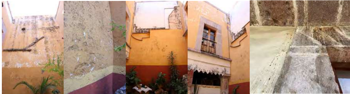
Fig. 154 Efectos de agentes abióticos y antrópicos por intemperismo en los patios interiores. En la fachada principal se puede observar efectos de organismos superiores como palomas que con sus excrementos han manchado algunos elementos de la fachada. Fuente: Fotografía tomada por RGM & METR 2021
