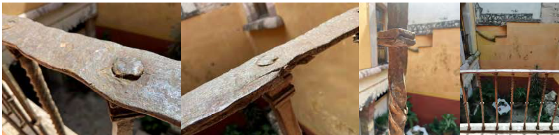
Fig. 125 Registro fotográfico a detalles del barandal de herrería de forja original del siglo XVIII. Fotografía: RGM & METR
