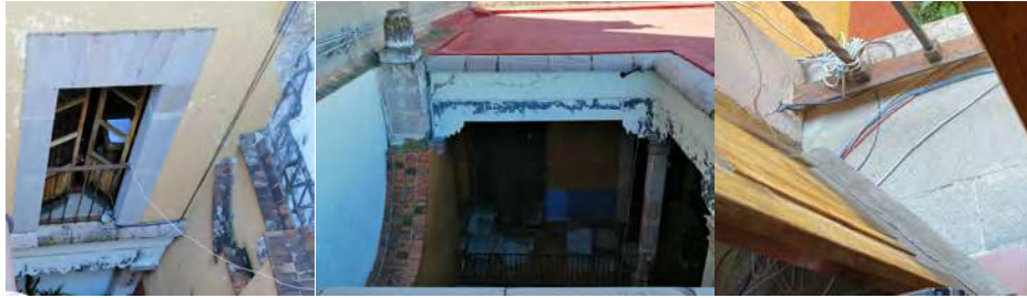
Fig. 121 Cables de telecomunicaciones e internet que se han colocado desde la azotea al interior de los espacios que lo requieren. Fotografía: METR
