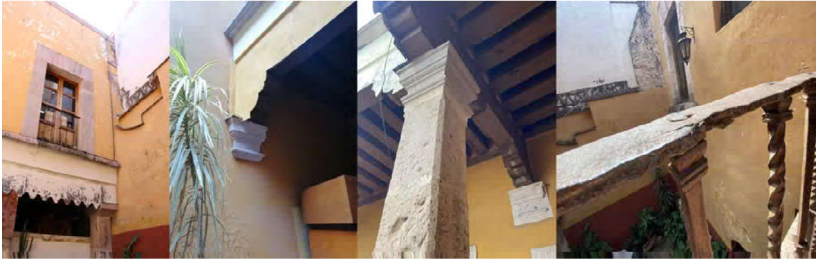
FIGURA 70. De izquierda a derecha vista hacia la planta alta de la CAMEM desde el segundo patio, debajo de esas pilares se encuentra un lavadero monolítico original. Vista de zapata empotrada en muro la que soporta una gualdra estructura en el primer patio. Pilar en primer patio, planta alta. Herrería de forja original, ahora colocada en el segundo patio. Fuente: Imágenes tomadas por METR septiembre 2020.
