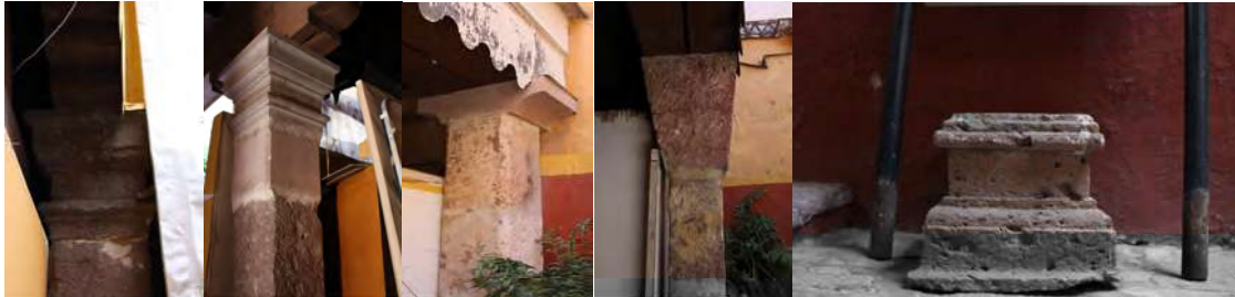
Fig.111 Registro fotográfico de apoyos aislados CAMEM. Fotografía: METR
