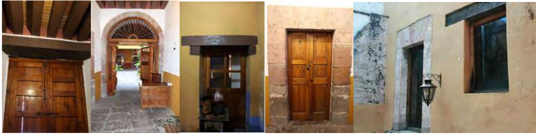
Fig.113 Registro fotográfico de puertas, vanos y cerramientos. fotografía: METR
