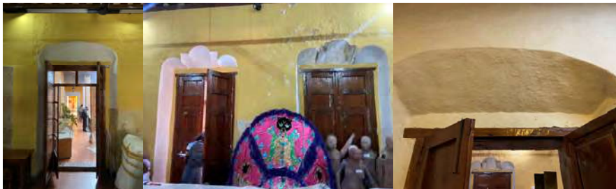
Fig. 115 Registro fotográfico capialzados simples y mixtilíneos Fotografía: METR
