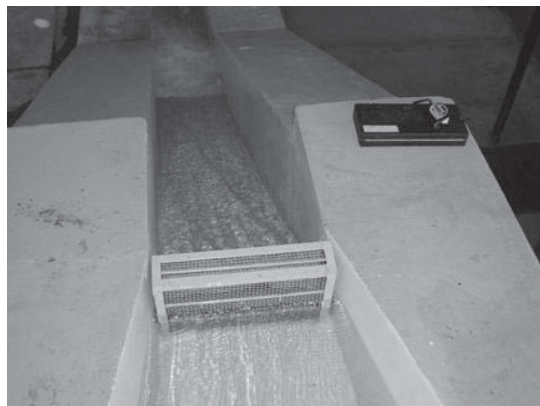
Vista panorámica de la Caída después de La Compuerta Amil.
