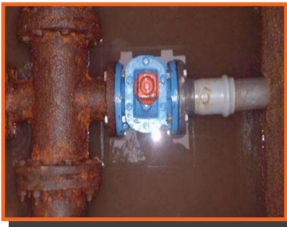
Colocación de nuevas válvulas necesarias para el aislamiento de un Distrito Hidrométrico, cuando así se requiere
