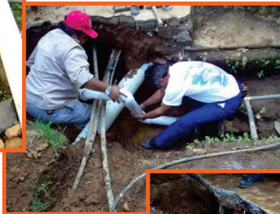
Colocación de la tubería para la instalación del macro medidor de 3" de diámetro después de la válvula de seccionamiento del tanque
