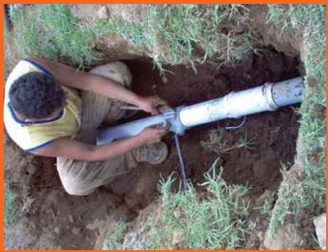
REPARACION DE FUGA EN RED
