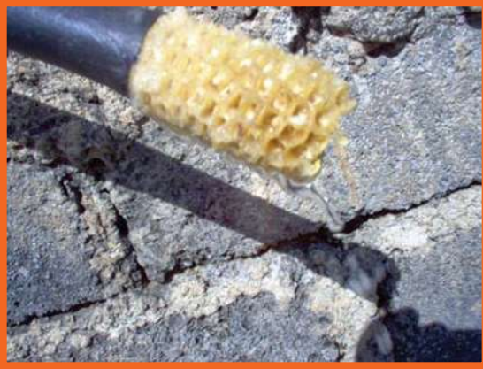
Taponamiento en toma domiciliaria para cerrar relativamente el suministro de agua hacia la vivienda
