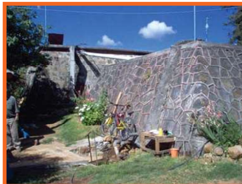
TANQUES DEL “CALVARIO”
