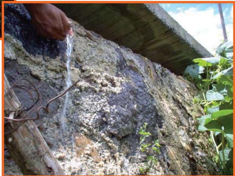
Fugas apreciables en las paredes del los tanques generales del “Calvario”, principales surtidores de agua potable a la infraestructura de distribución de agua potable del Distrito Hidrométrico Itzi-Huriata-
