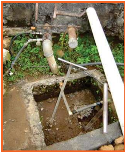
Salida del tanque chico antes de cualquier trabajo para la colocación del macro medidor
