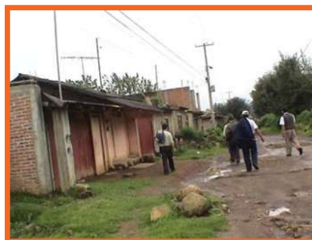
Calle Camino Real colonia las Palmas, donde cambia de diámetro la línea principal de 6" a 4" de diámetro
