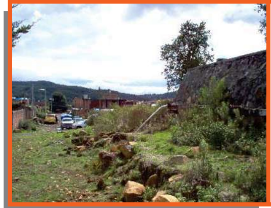
Tanque sin uso en la Colonia Eréndira III. Vista 2
