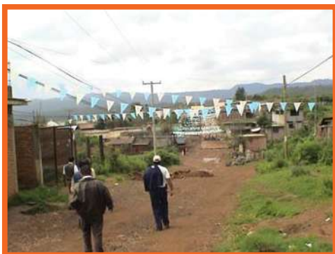
Calle San Valentín, al fondo se observan avances en pavimentación a base de empedrado. Calle donde se sitúa la línea principal de 6" de diámetro
