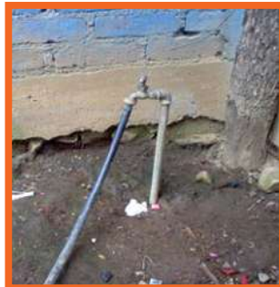
Tipo de tomas domiciliaria de agua potable que predomina en la zona del Distrito Hidrométrico.
