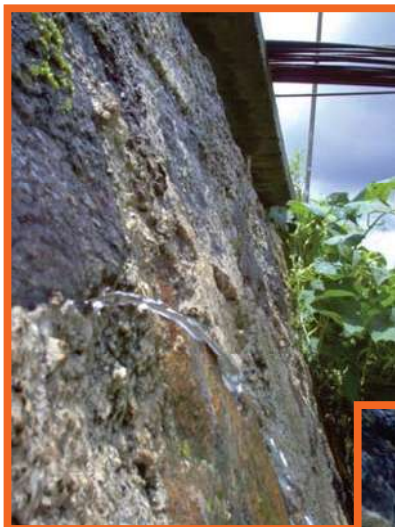
Fugas apreciables en las paredes del los tanques generales del “Calvario”, principales surtidores de agua potable a la infraestructura de distribución de agua potable del Distrito Hidrométrico Itzi-Huriata-
