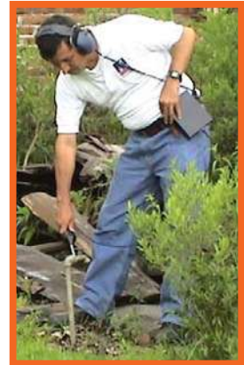
Detección de fugas en tomas domiciliarias con GEÓFONO
