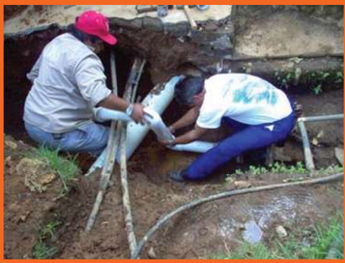
INSTALACIÓN DE MACRO MEDIDORES
