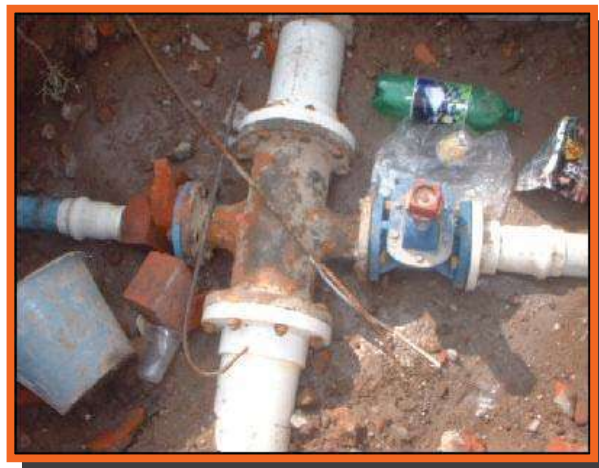
Colocación de nuevas válvulas necesarias para el aislamiento de un Distrito Hidrométrico, cuando así se requiere
