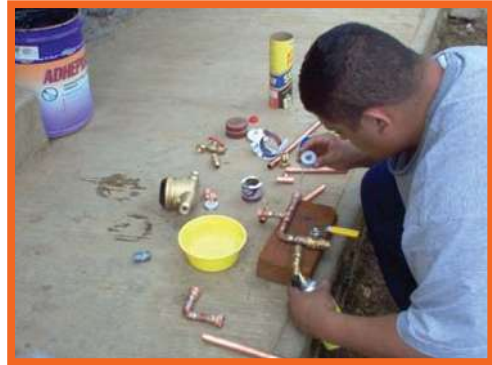
INSTALACION DE MICROMEDIDORES
