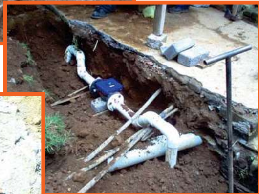
Conformación de la instalación del macro medidor de 3" de diámetro. Se observa la correcta colocación del macro medidor (ahogamiento del macro medidor)
