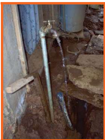
Tipo de tomas domiciliaria de agua potable que predomina en la zona del Distrito Hidrométrico.
