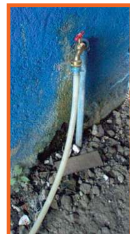
Tipo de tomas domiciliaria de agua potable que predomina en la zona del Distrito Hidrométrico.
