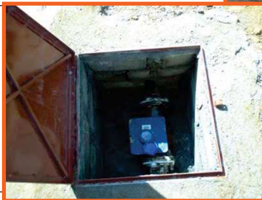
La instalación del macro medidor culminó con la protección de este mediante un registro donde se aloja el aparato. Y de fácil manejo para la toma de lecturas
