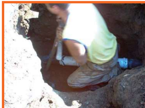
REPARACION DE FUGA EN RED
