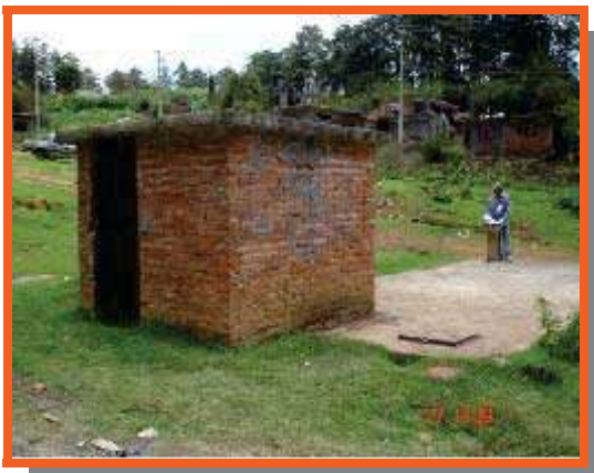
Rebombero hacia el tanque del Fraccionamiento los Fresnos
