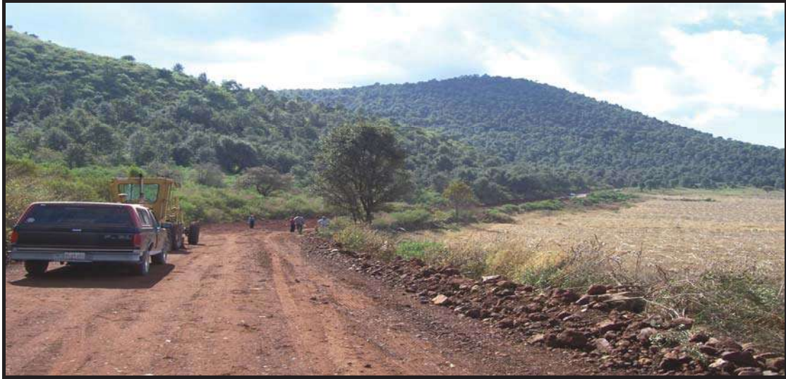
Foto 15.- Vista del camino en y base nivelada.
