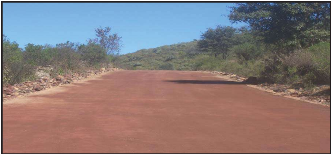
Foto 17 .- Tendido de base con 20 cms de espesor.
