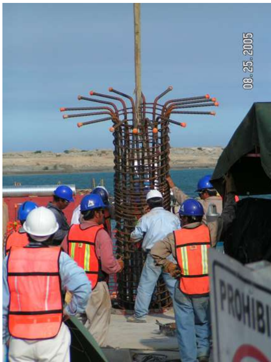
Colocación de armado de acero en la parte superior de los pilotes para su posterior llenado con concreto.
