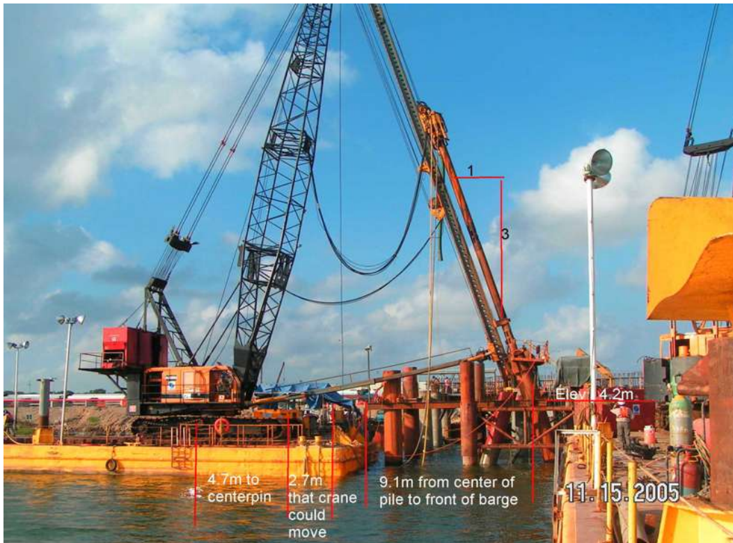
Perforación para pilotes inclinados con la perforadora BERMINGHAMMER.
