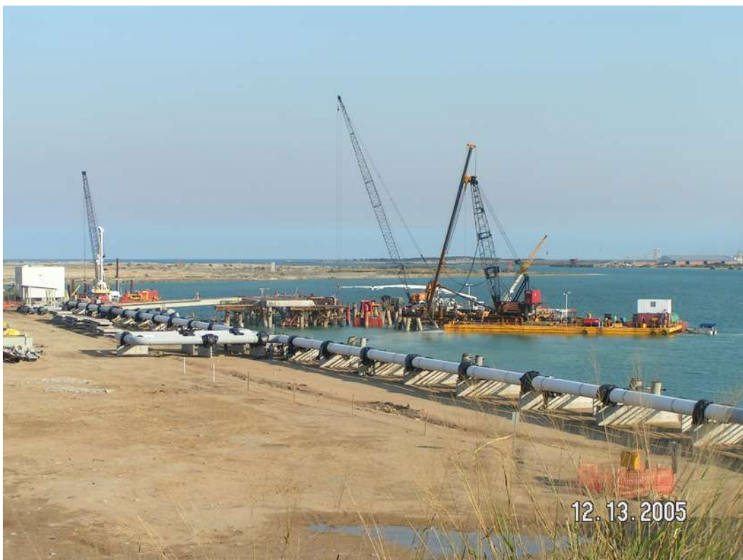
Perforación para pilotes inclinados con la perforadora BERMINGHAMMER.
