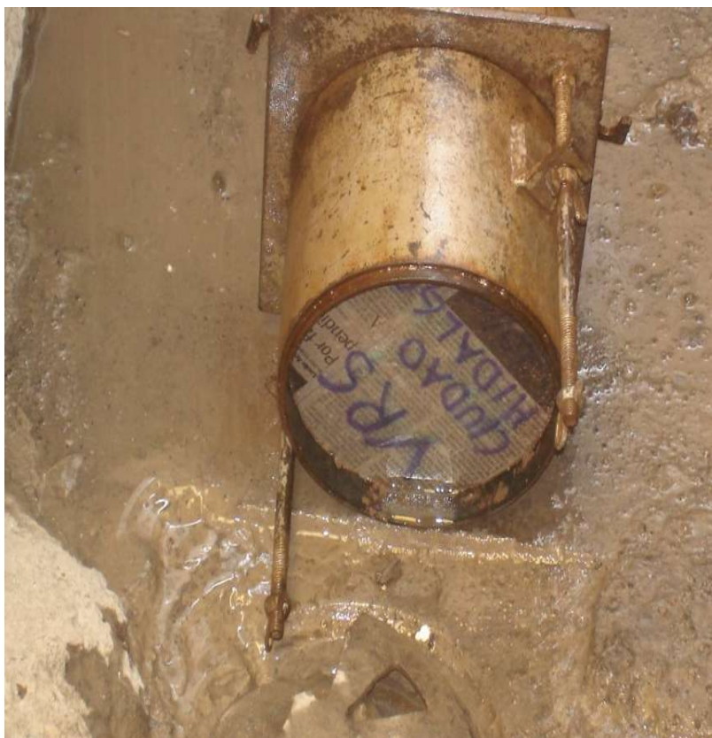
Figura no. 16 material en reposo para expulsar el agua sobrante
