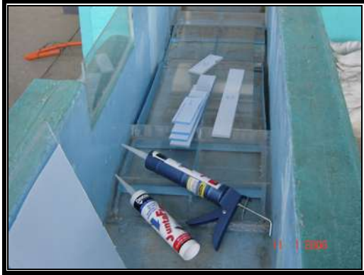
Figura 15. Instalación de la plantilla del aforador Parshall
