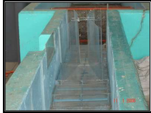
Figura 16. Colocación del resto de los componentes del aforador.
