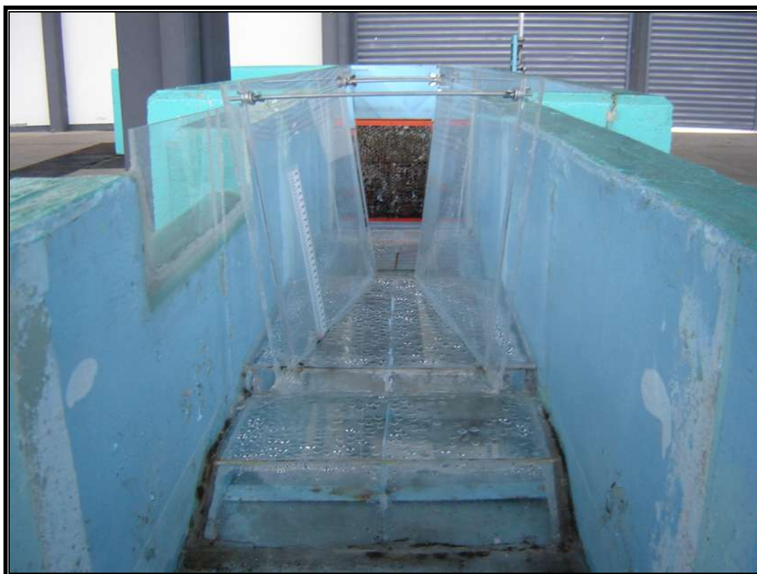
Figura 35. Alteración significativa en la verticalidad de las paredes
