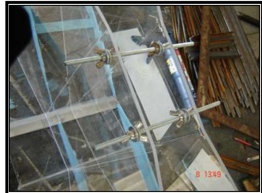
Figura 12. Se colocaron unos dispositivos de refuerzo en el tope de las paredes, los cuales nos permitieron darle mayor rigidez a las paredes del aforador.
