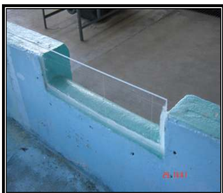
Figura 14. Vertedor de demasías modificado
