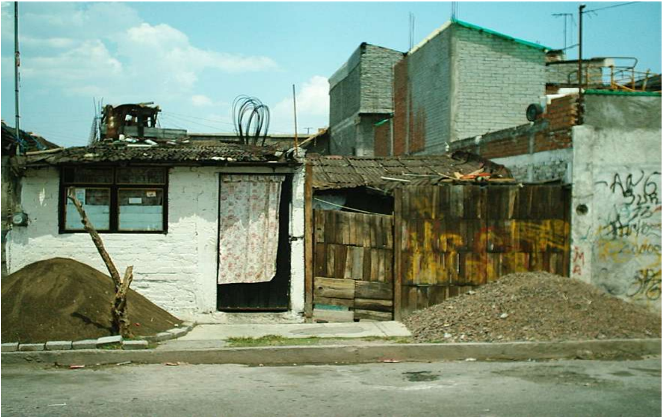
Estas Viviendas las consideramos como si fueran de Asentamiento Inicial (tipo 2) la diferencia es que estas se encuentran ubicadas en un lote con todos los servicios y dentro de la mancha urbana de la Cd. (Fraccionamiento Eduardo Ruiz Morelia Mich.)
