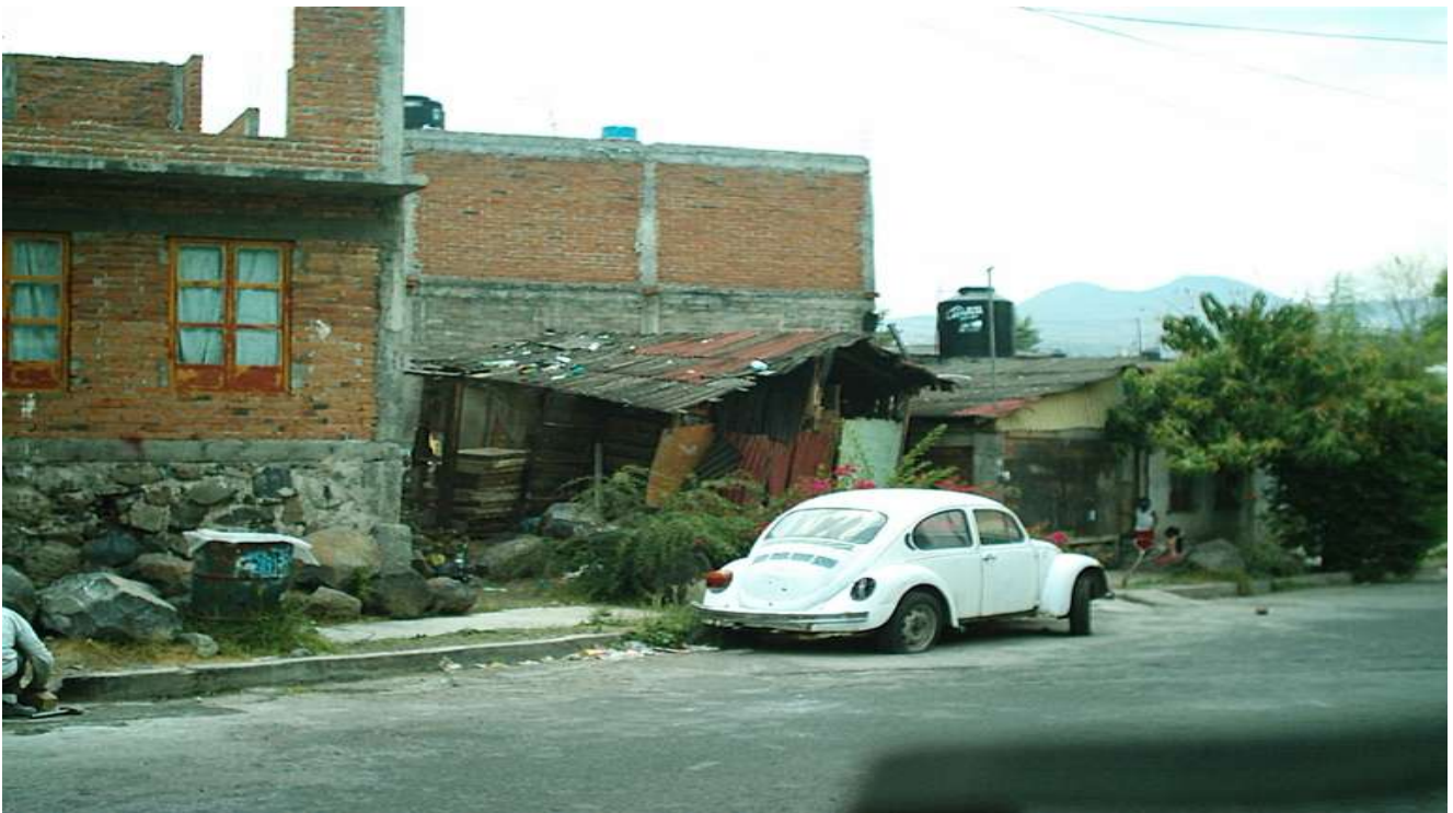
Vivienda Precaria a pesar de que esta ubicada en un fraccionamiento (Eduardo Ruiz, Morelia Mich) con 19 años de creación, la vivienda es la misma pero con diferencia de tiempo de fotografía seis meses.
