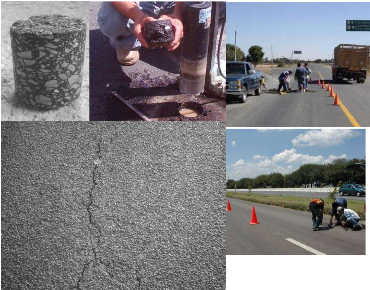
Agrietamiento superficial por fatiga en la capa asfáltica
