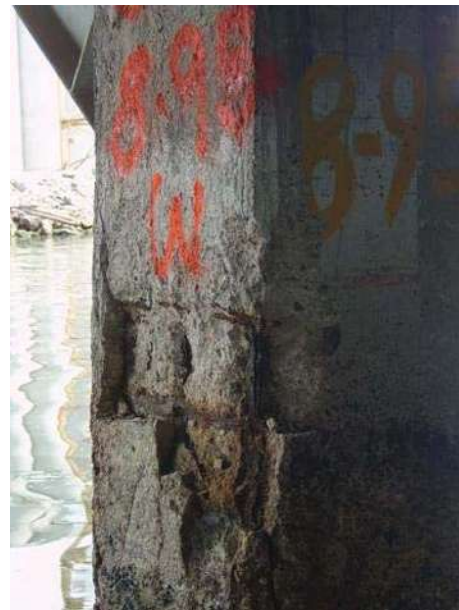
Fig. III.12 Representación de daños en el pilote No. 8-95, del Módulo X.
