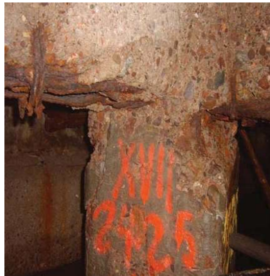
Fig. III.18 Representación de daños en el pilote No. 24-25, del Módulo XVII.
