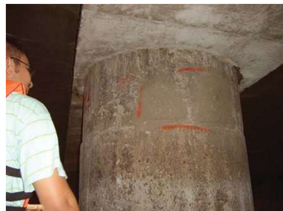
Fig. III.2 Representación de una reparación.
