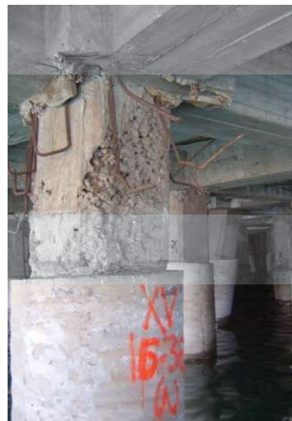
Fig. III.16 Representación de daños en el pilote No. 16-36, del Módulo XV.
