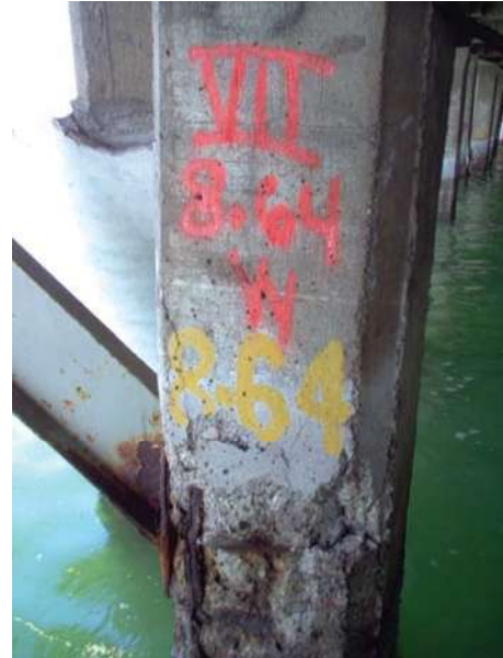
Fig. III.11 Representación de daños en el pilote No. 8-64, del Módulo VII.
