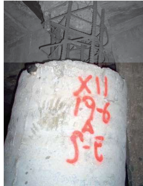
Fig. III.15 Representación de daños en el pilote No. 19-6A, del Módulo XII.
