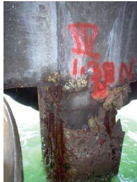
Fig. III.9 Representación de daños en el pilote No. 10-16, del Módulo II.
