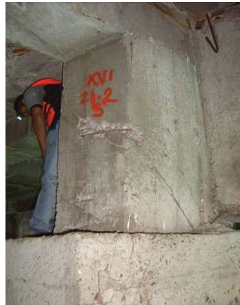
Fig. III.17 Representación de daños en el pilote No. 21-2, del Módulo XVI.
