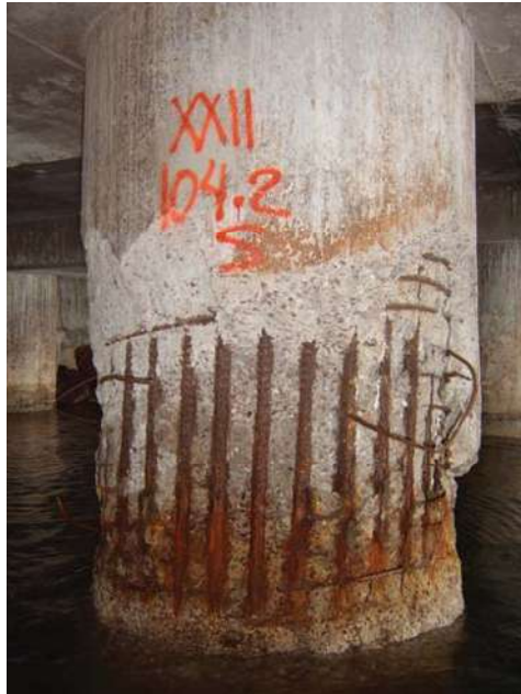
Figura II.5. Importancia del recubrimiento como protección del acero.
