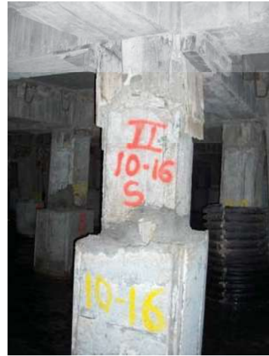
Fig. III.9 Representación de daños en el pilote No. 10-16, del Módulo II.
