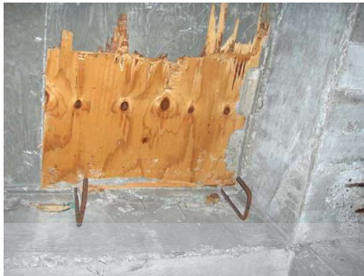
Fig. III.24 Representación de daños en LOSA II_5-16,5-17,6-17,6-16, del Módulo II.
