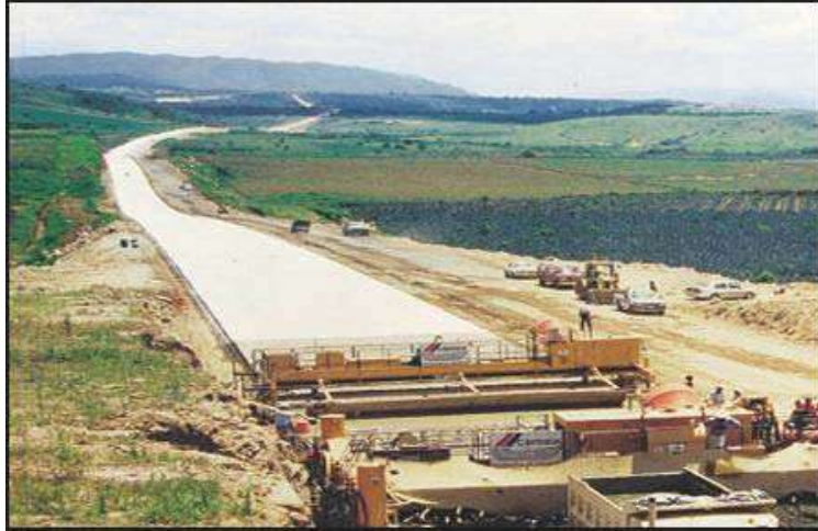
FIGURA 2. Autopista de concreto hidráulico.
