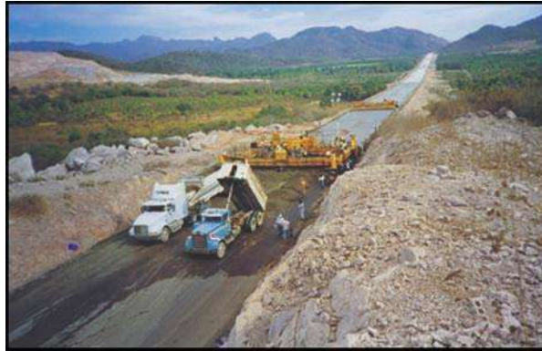
FIGURA 1. Pavimentadora de cimbra deslizante.
