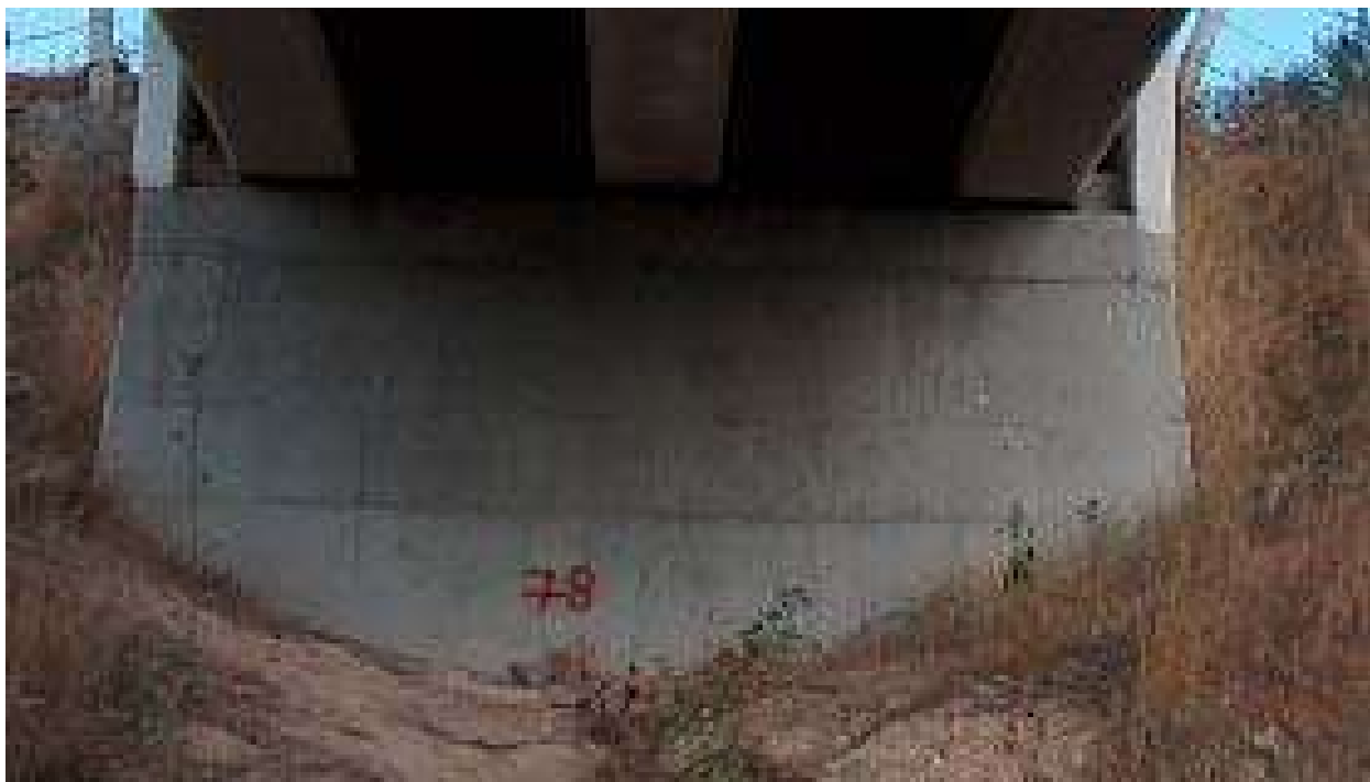
Figura 3.13 Estribo lateral de concreto.
