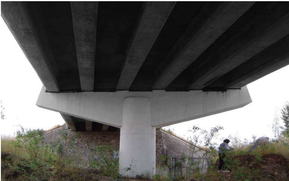
Figura 3.4 Sección de la pila intermedia del puente.
