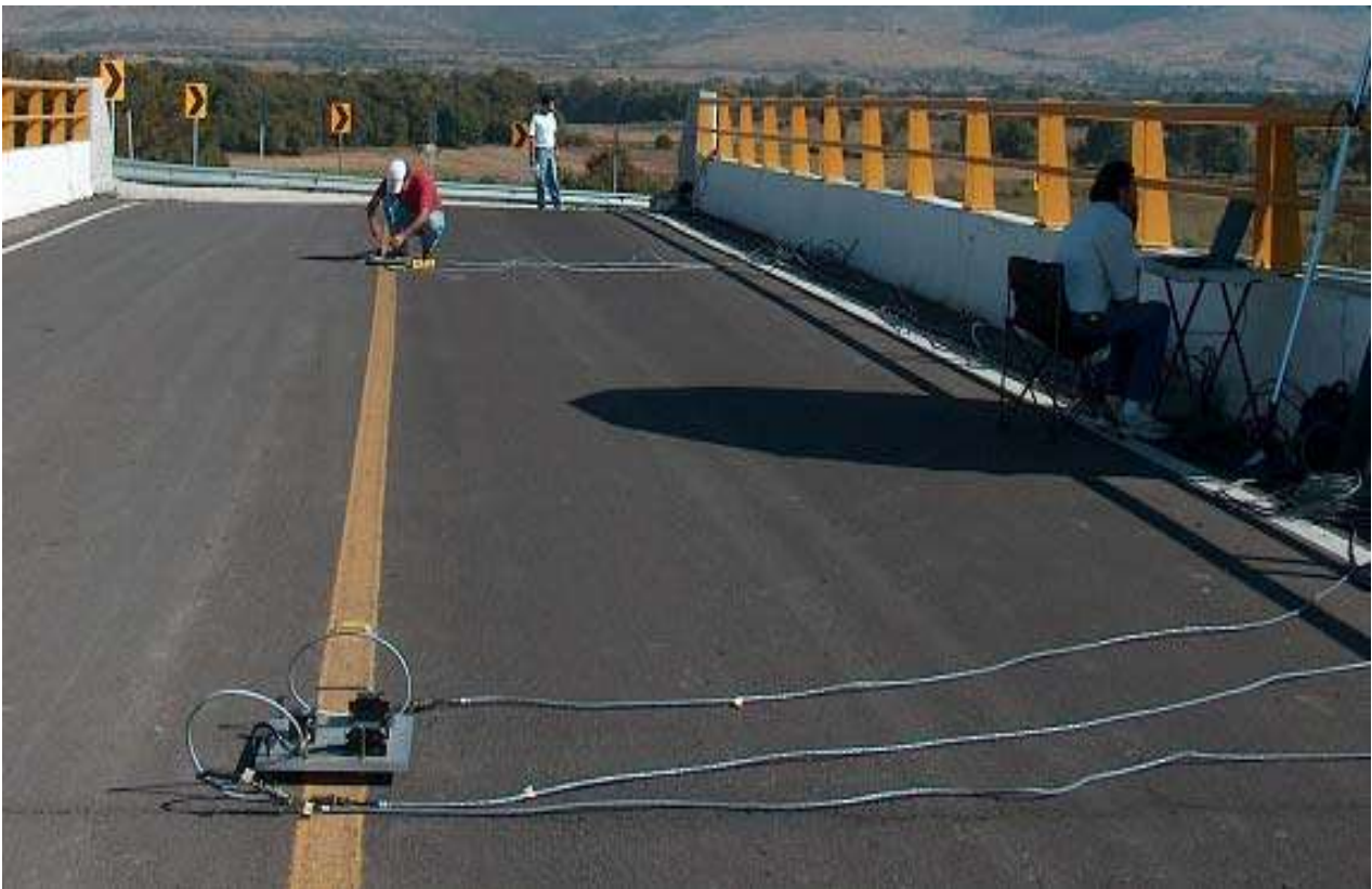
Figura 3.16 Colocación de los aparatos
