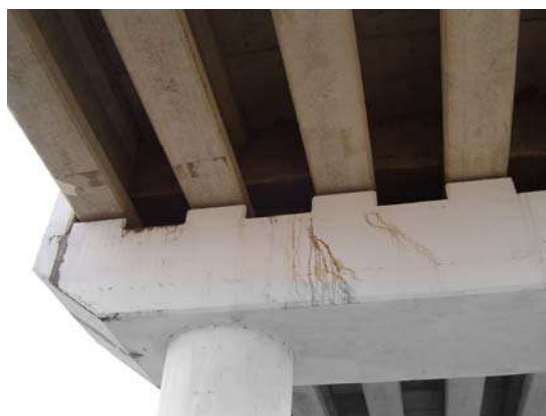
Figura 3.15 Cabezal en la parte central del puente.
