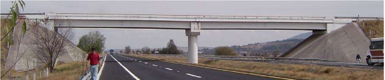
Figura 3.9 Perfil del puente
