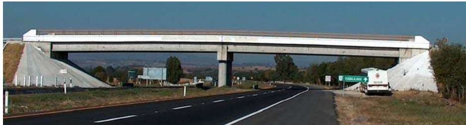
Figura 3.1 Perfil del puente
