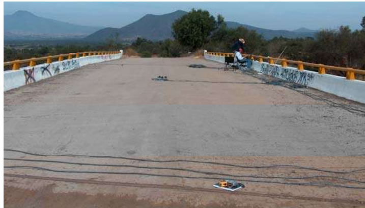
Figura 3.22 Sensores sobre la calzada
