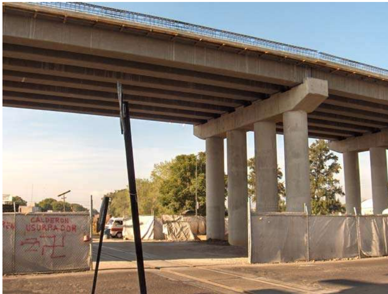
Figura 2.13 Paso Inferior de Ferrocarril
