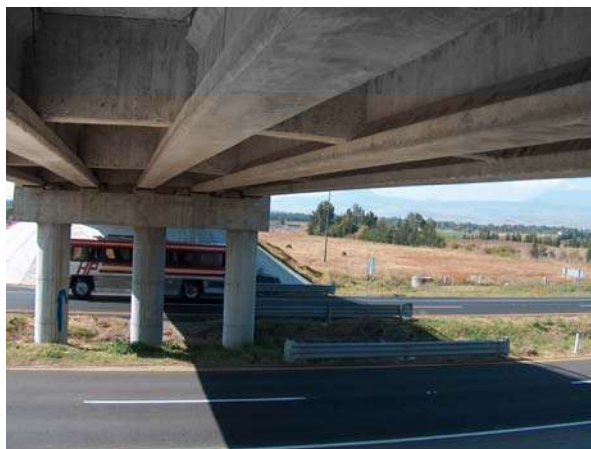
Figura 3.7 Vigas “T” apoyadas sobre cabalzal
