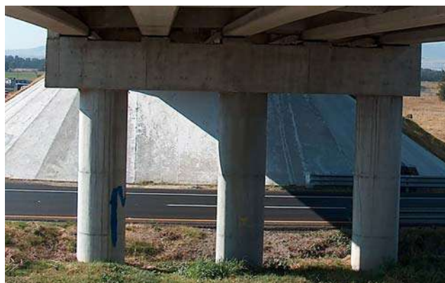
Figura 3.5 Apoyos intermedios del puente.
