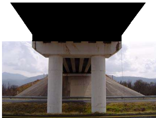
Figura 3.13 Apoyos intermedios con los que cuenta el puente.
