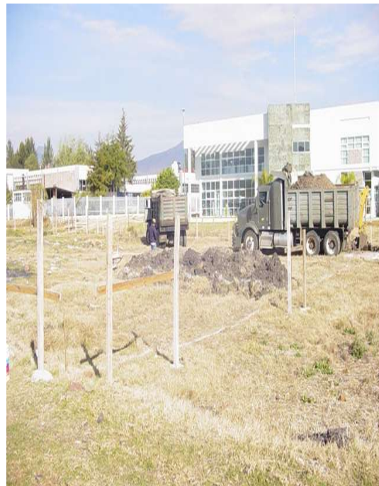
Trazo y nivelación del terreno
