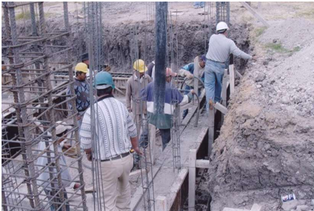
Vibrado del concreto
