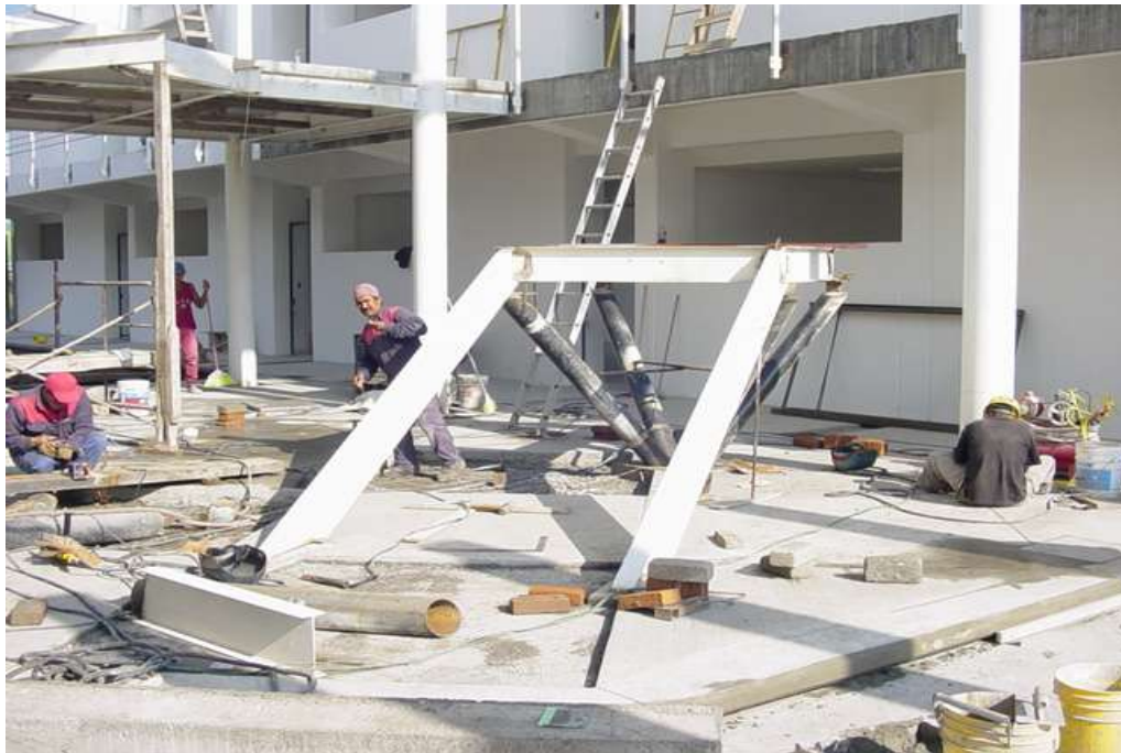
Armado de escalera
