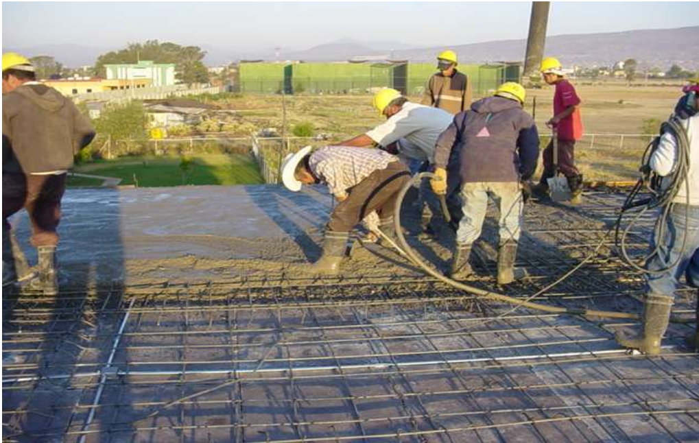
Colado de losa de entrepiso
