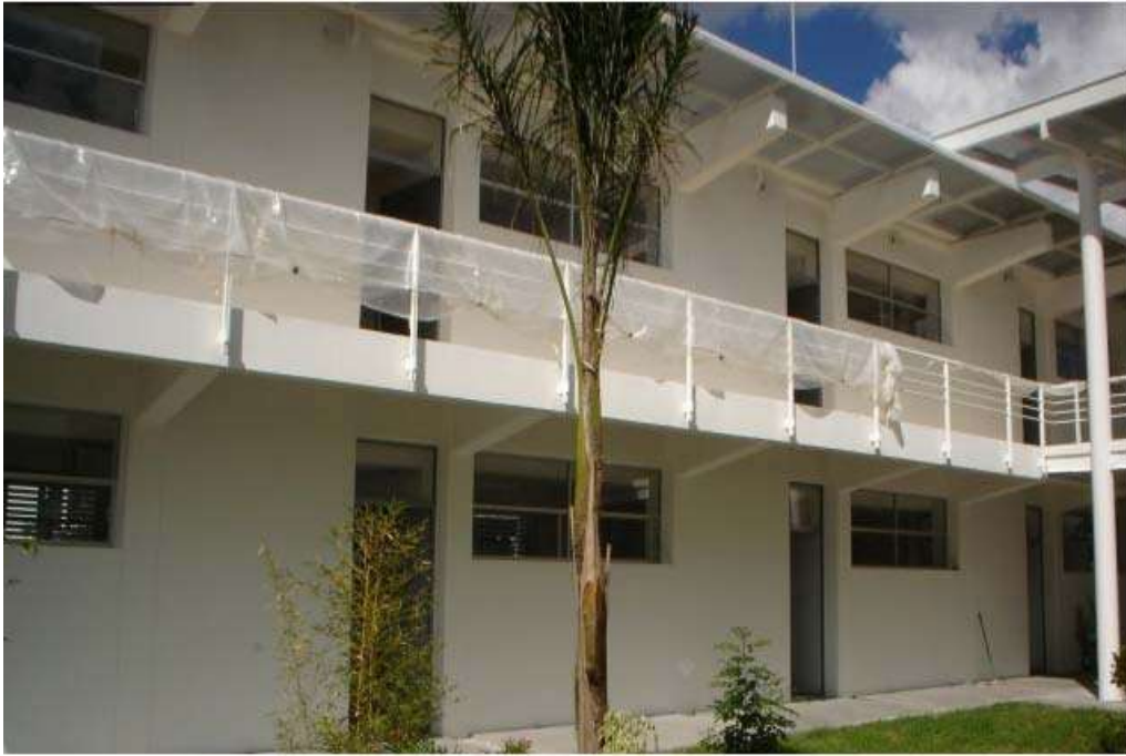
Limpieza del interior del edificio
