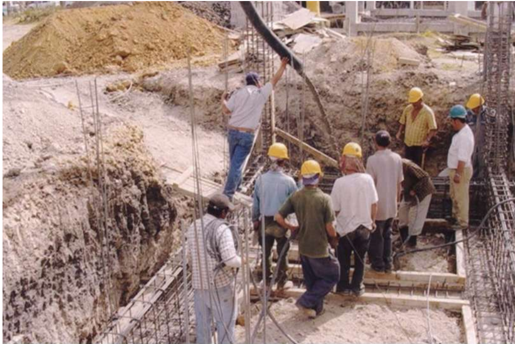
Colado de zapatas
