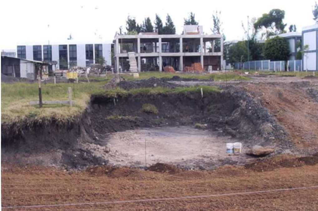
Relleno del terreno con material para mejorar el terreno
