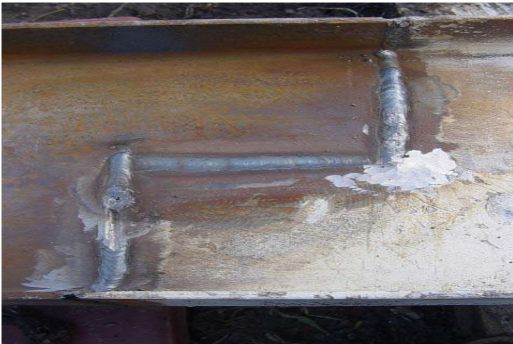
Soldadura de un elemento
