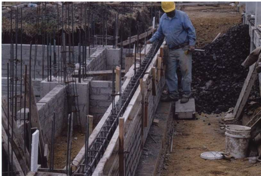
Armado de cadena de desplante
