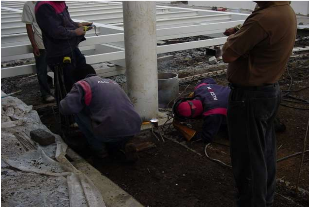
Unión con soldadura de la estructura metálica
