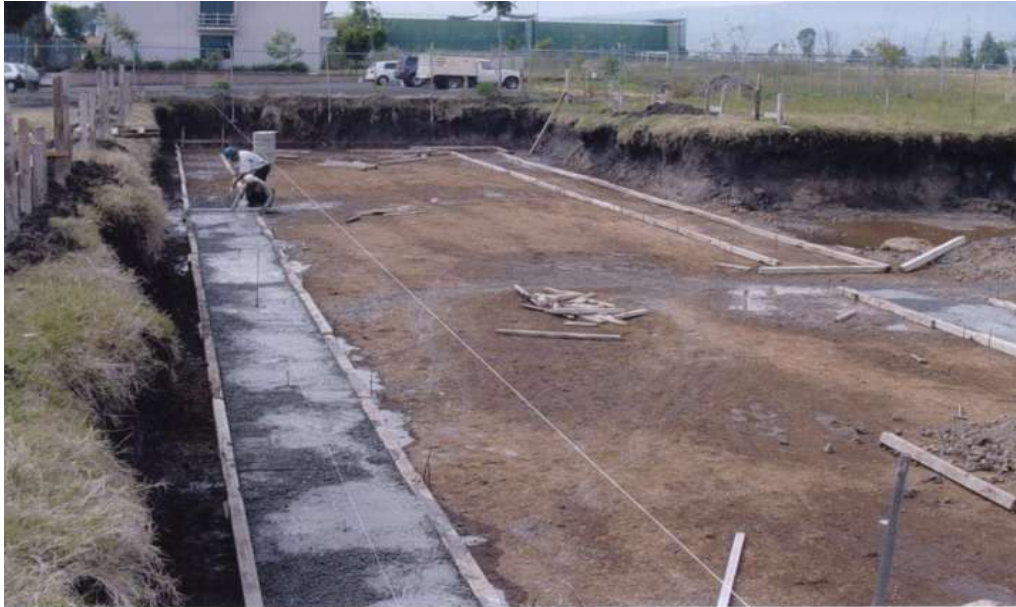
Plantilla de concreto pobre
