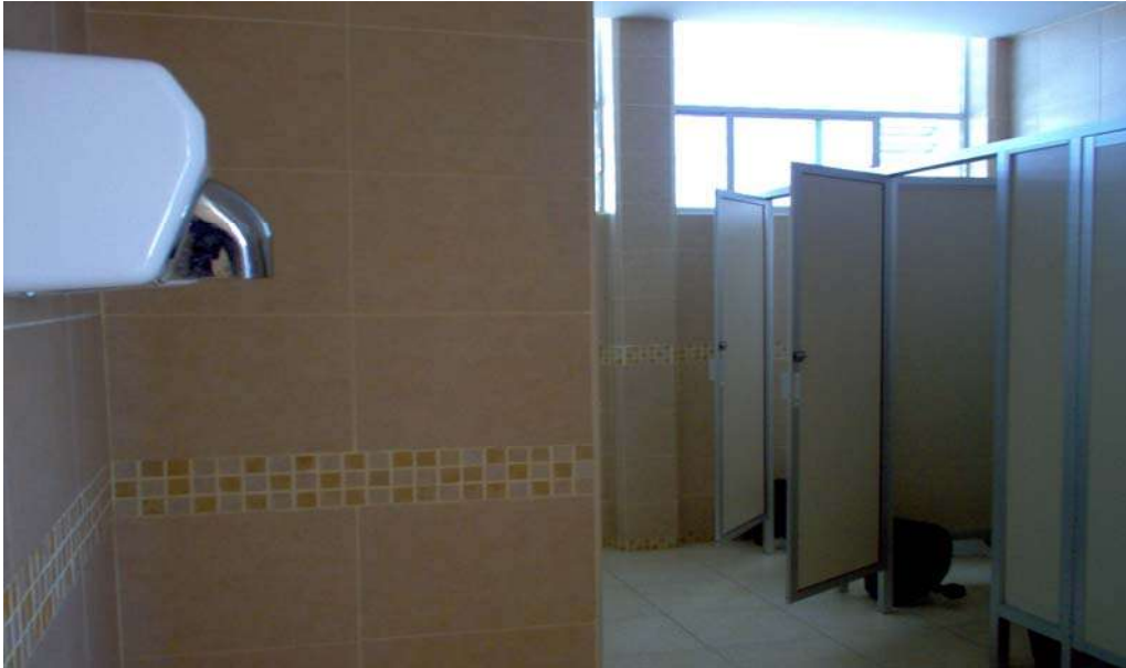
Acabados en sanitarios
