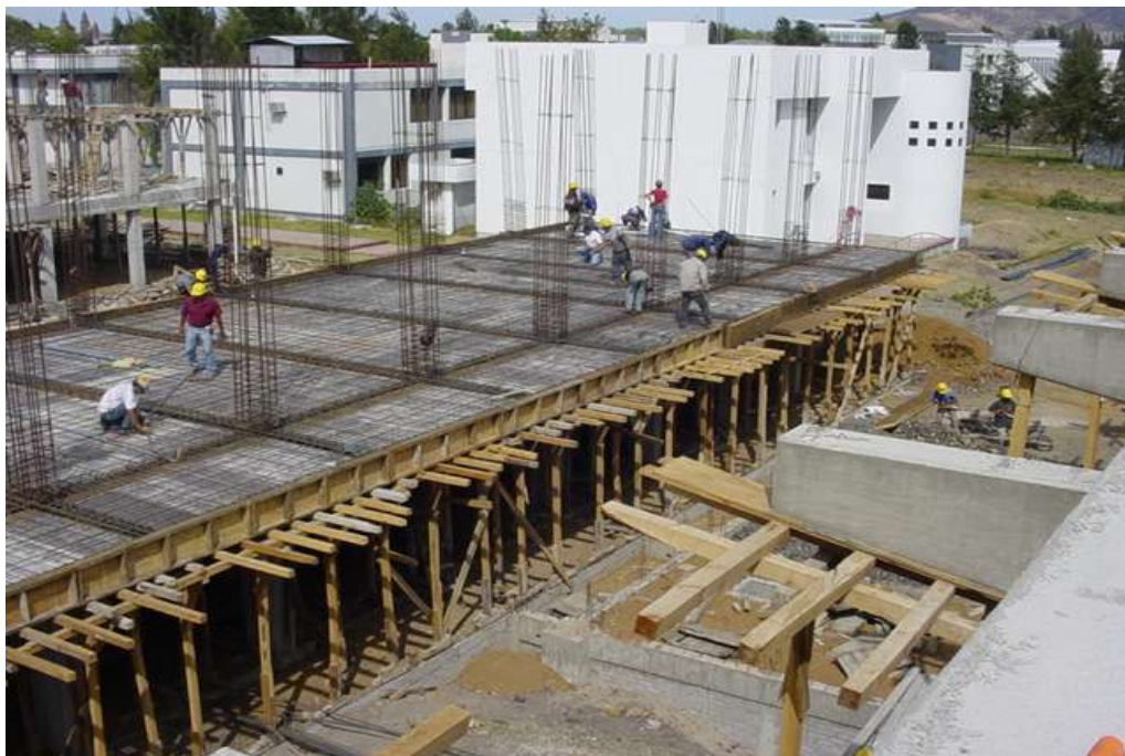
Armado de losa de entrepiso
