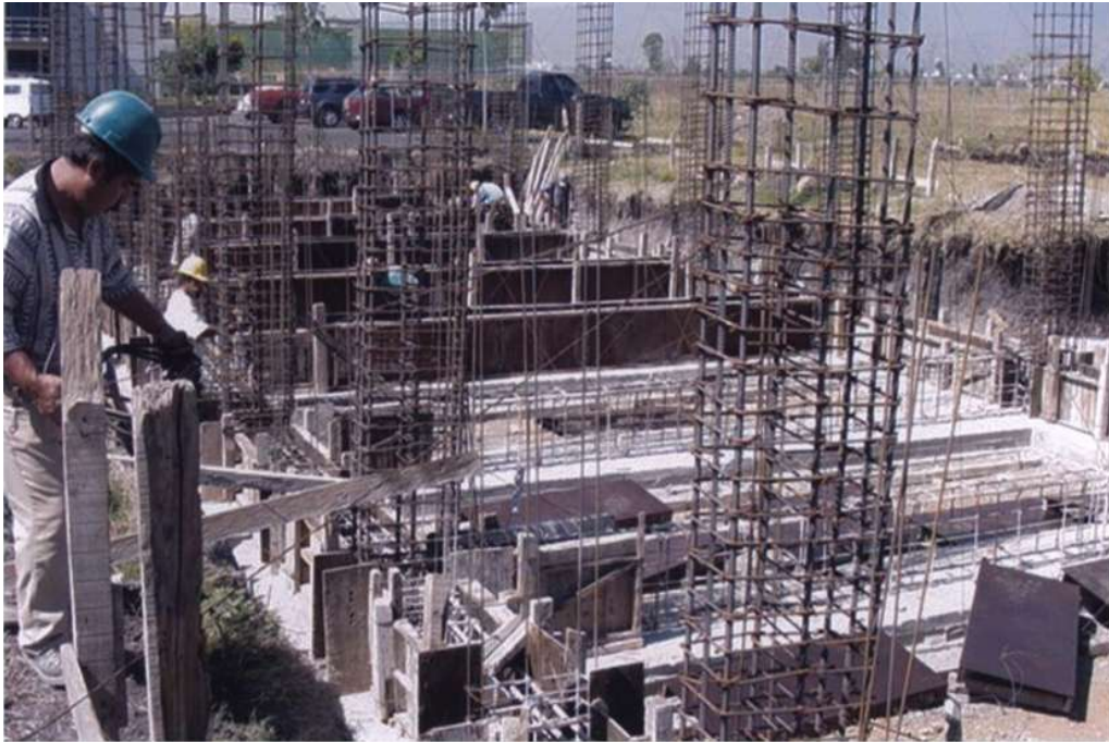
Armado de cadenas y castillos
