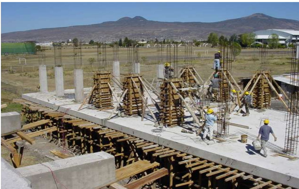
Cimbrado de columnas de segundo nivel
