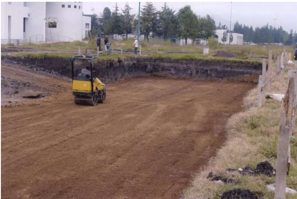
Compactación del material de relleno
