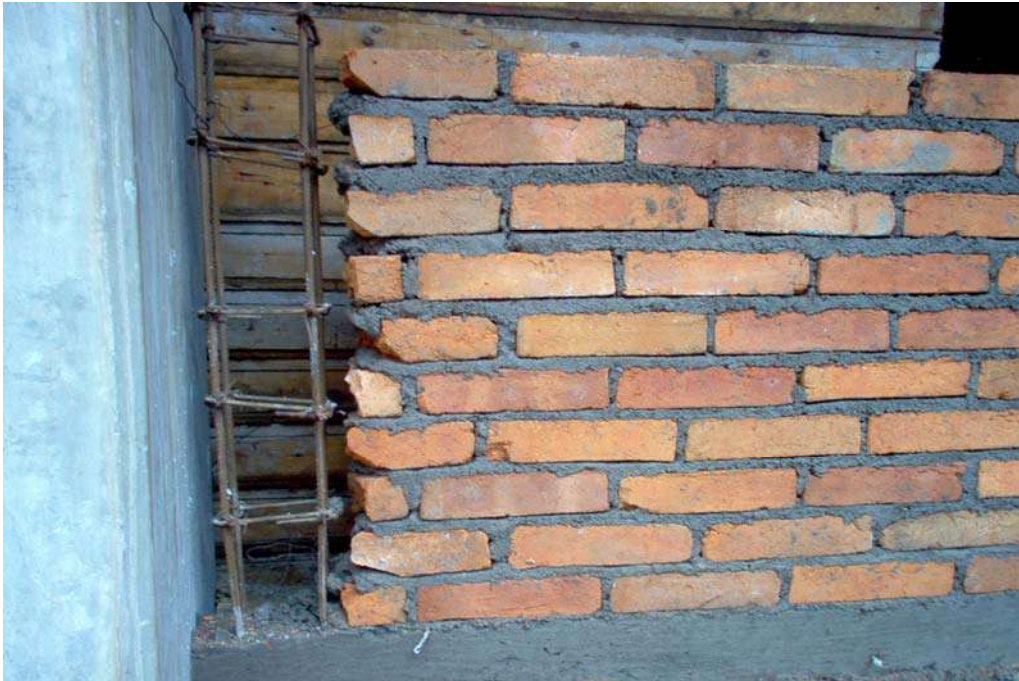
Unión de muro con castillo
