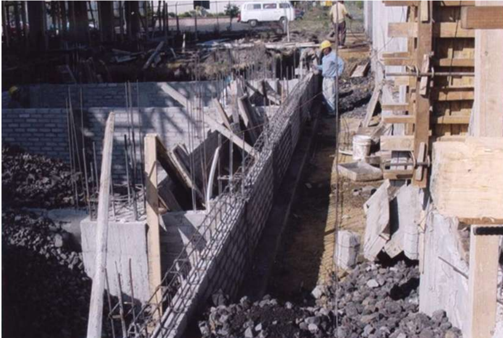
Colocación del enrase de tabicón
