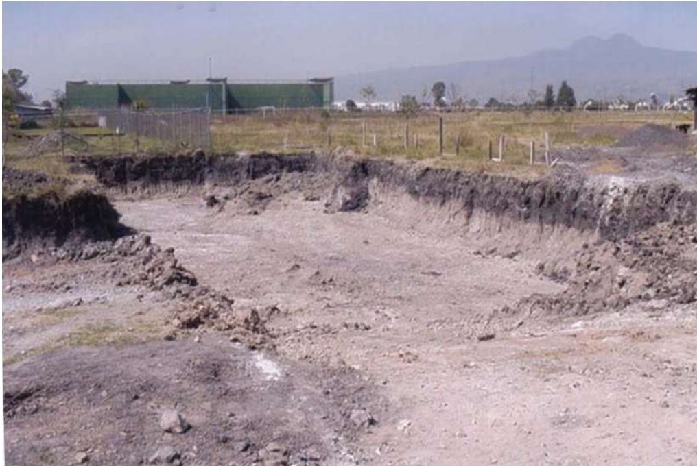
Excavación a cielo abierto
