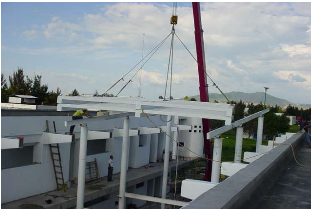
Colocación de la cubierta metálica
