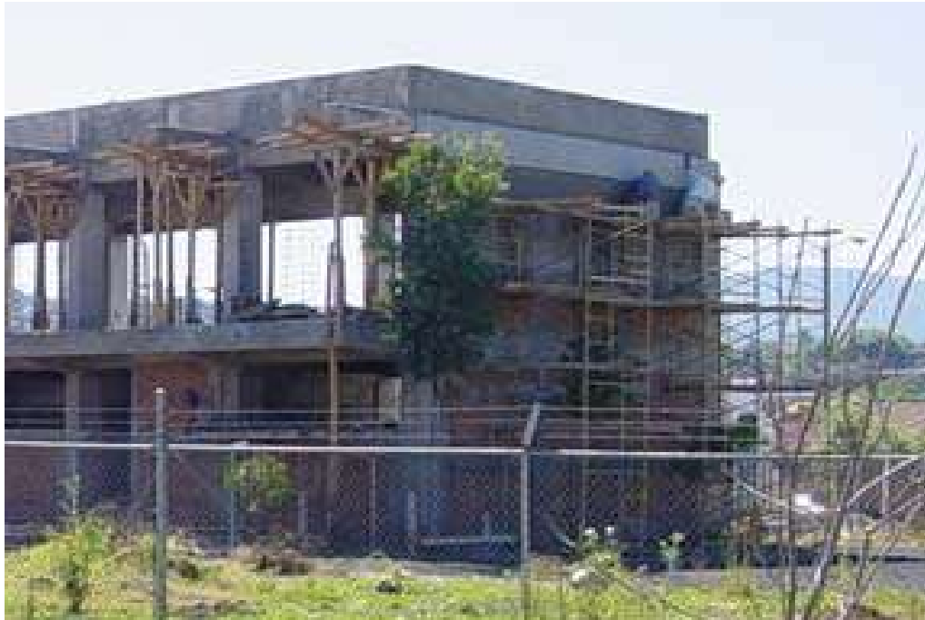
Aplanado de muros de tabique
