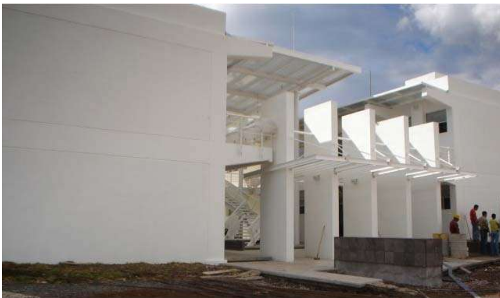
Limpieza del exterior del edificio
