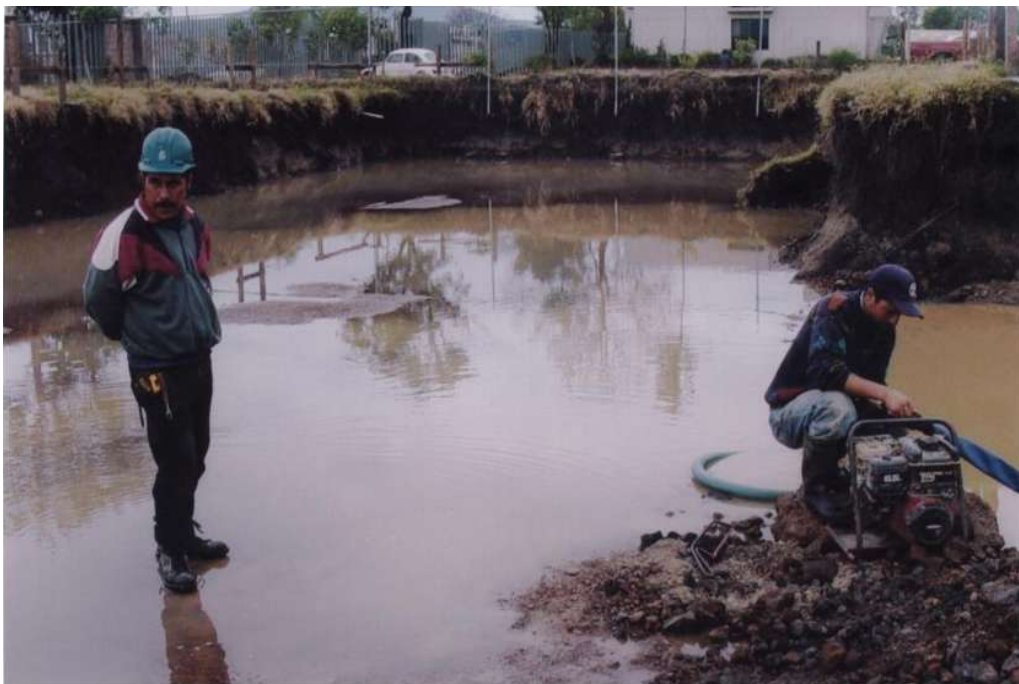
Abatimiento del agua por bombeo directo
