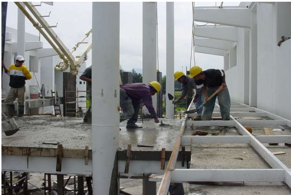
Colado del puente unión entre el Modulo I y Modulo II 7
