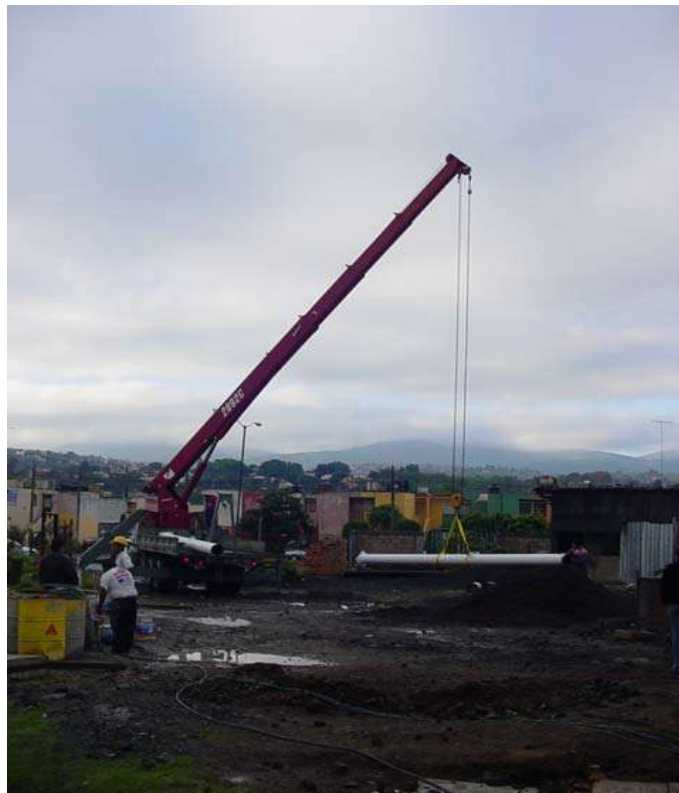
La grúa utilizada para la colocación de los elementos fue de una capacidad de 22 toneladas y 25 m. de capacidad
