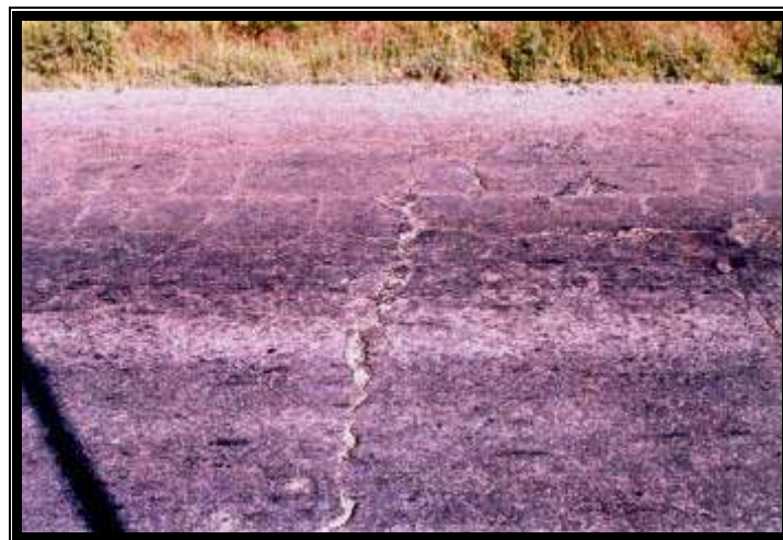
Fig 1.14 Grietas Transversales
