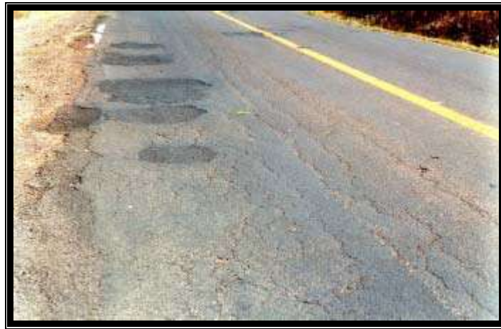
Fig 1.13 Grietas longitudinales
