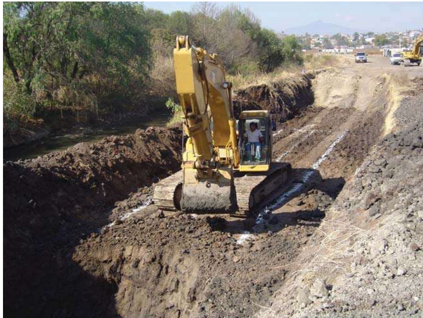
BANQUETA DE APOYO PARA LOS EQUIPOS DE EXCAVACION DE LA ZANJA (2)
