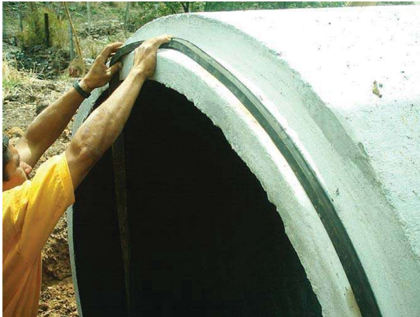
COLOCACION DE JUNTA DE HULE EN ESPIGA DEL TUBO A ENSAMBLAR
