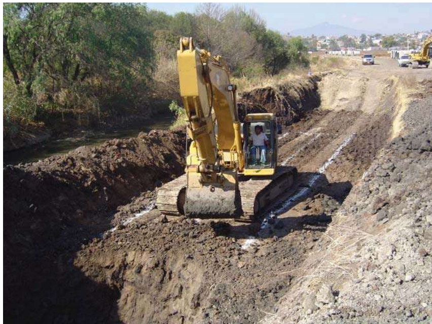
BANQUETA DE APOYO PARA LOS EQUIPOS DE EXCAVACION DE LA ZANJA
