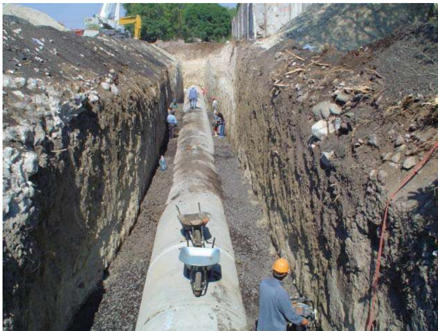
RELLENO ACOSTILLADO EN AMBOS LADOS DE LA TUBERIA PARA QUE NO VAYA A TENER DESPLASAMIENTO
