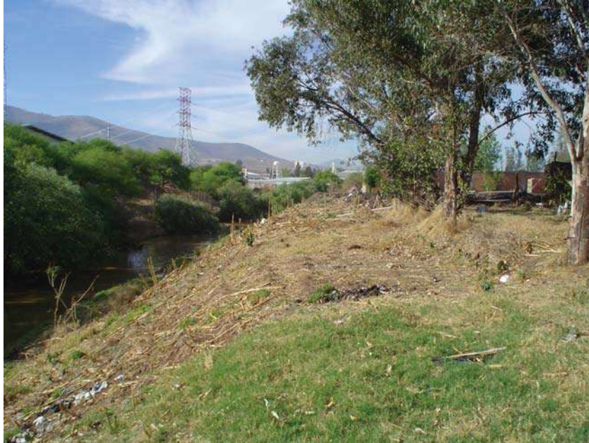
ZONA DE DESMONTE CON POCO ESPACIO PARA DEPOSITARLO LATERALMENTE
