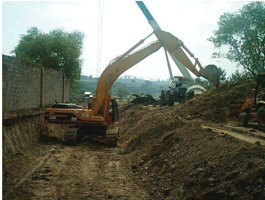
EXCAVACION DE CAJON PARA TENER BANQUETA DE APOYO DE LOS EQUIPOS DE EXCAVACION DE LA ZANJA (2)
