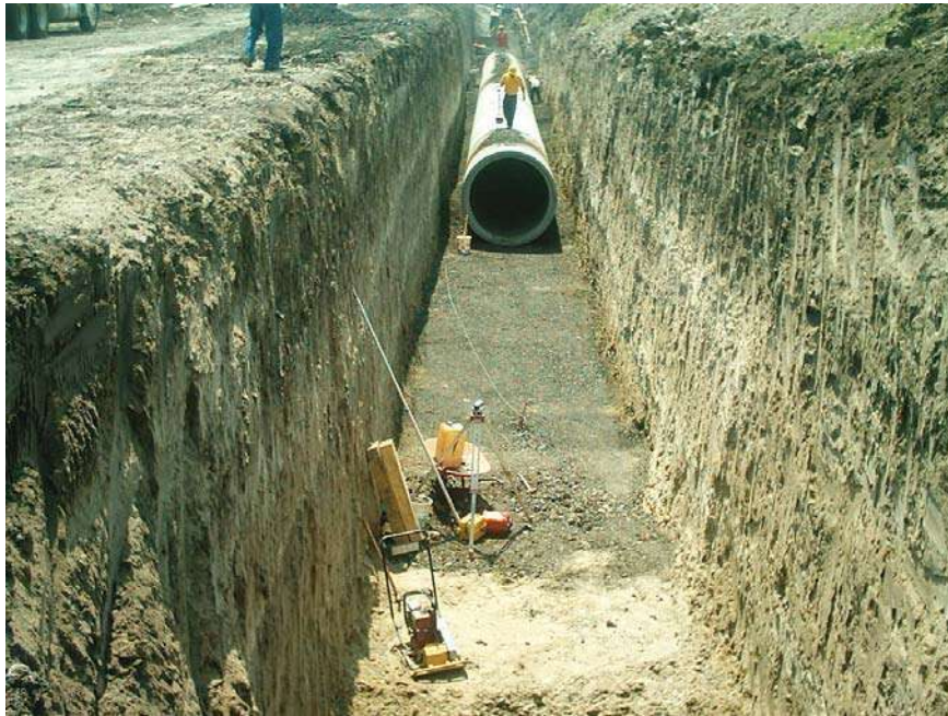
VERIFICACION DE ELEVACION Y DESNIVEL DE PLANTILLA DE FILTRO DE ACUERDO AL PROYECTO
