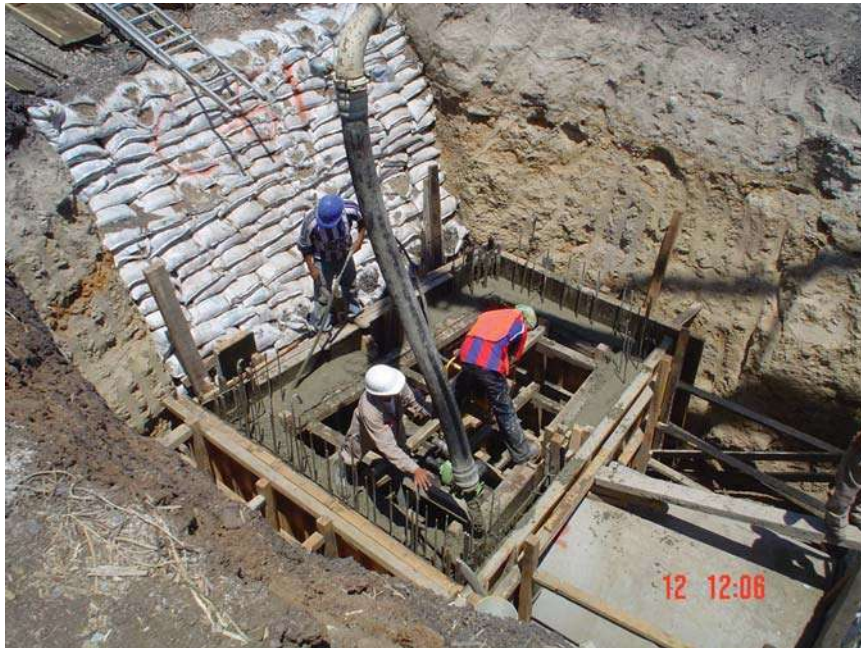
COLOCACION DE CONCRETO
