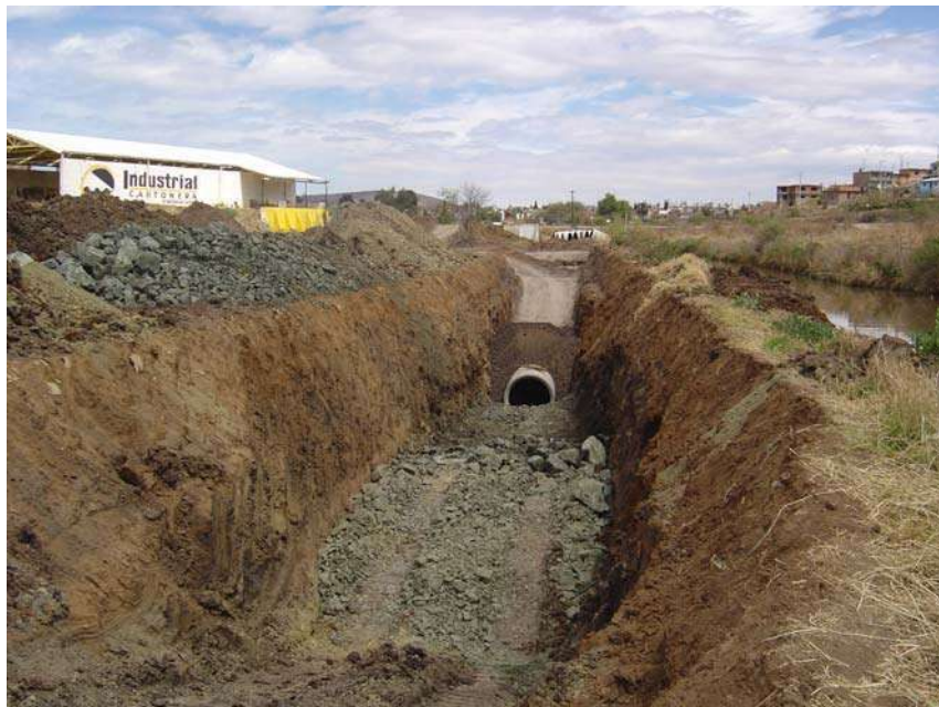
EXCAVACION EN MATERIAL TIPO B (12)
