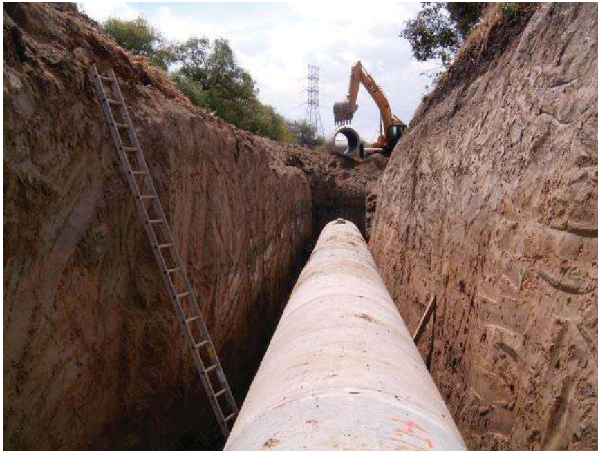
INSTALACION DE TUBERIA EN TRAMOS DIFICILES TUBO POR TUBO (3)
