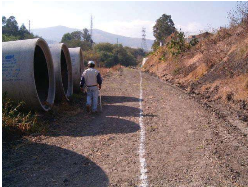
RECONSTRUCCION DE TRAZO Y NIVELACION DEL EMISOR
