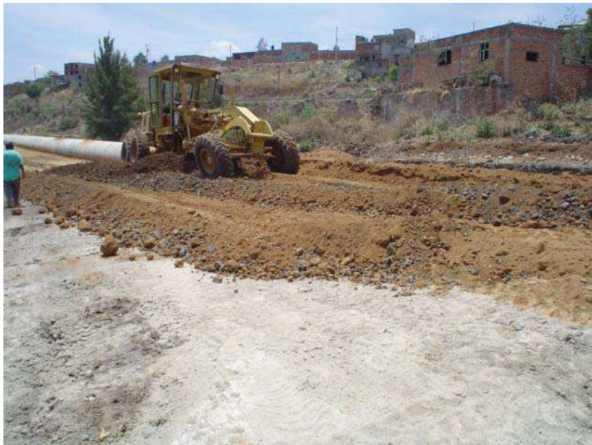
MEZCLA DE MATERIAL PARA TERRAPLEN
