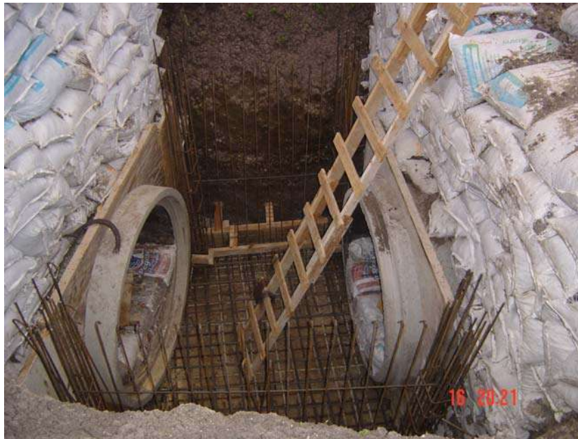
HABILITADO Y COLOCACION DE ACERO DE REFUERZO EN LOSA DE PISO DE CAJAS DE VISITA
