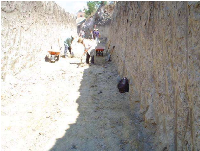
AFINE DE EXCAVACION EN LA PARTE MAS BAJA PARA DAR UN ANCHO DE 3.40 M PARA ALOJAR TUBERIA
