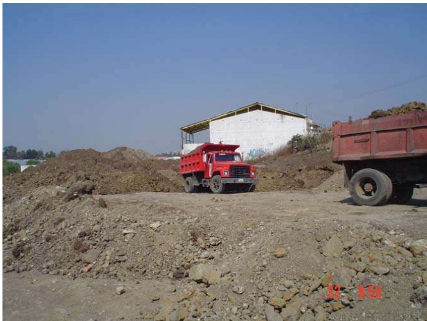
BANCO DE ALMACENAMIENTO TEMPORAL PARA DESPUES UTILIZAR EL MATERIAL PARA RELLENOS SOBRE LA TUBERIA
