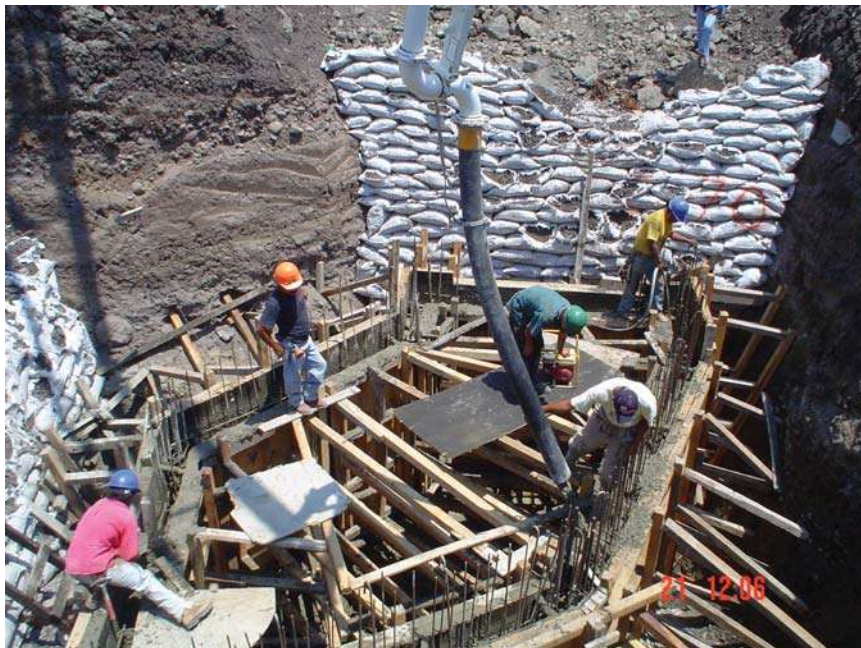
COLOCACION DE CONCRETO
