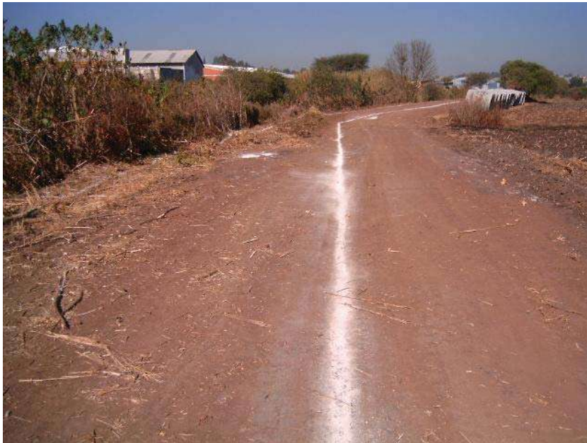
RECONSTRUCCION DE TRAZO Y NIVELACION DEL EMISOR
