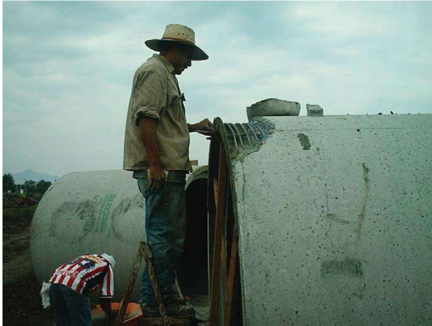
REPARACION DE TUBERIA (1)
