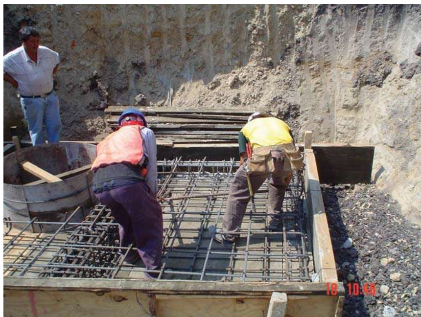
HABILITADO Y COLOCACION DE ACERO DE REFUERZO EN LOSA DE PISO DE CAJAS DE VISITA
