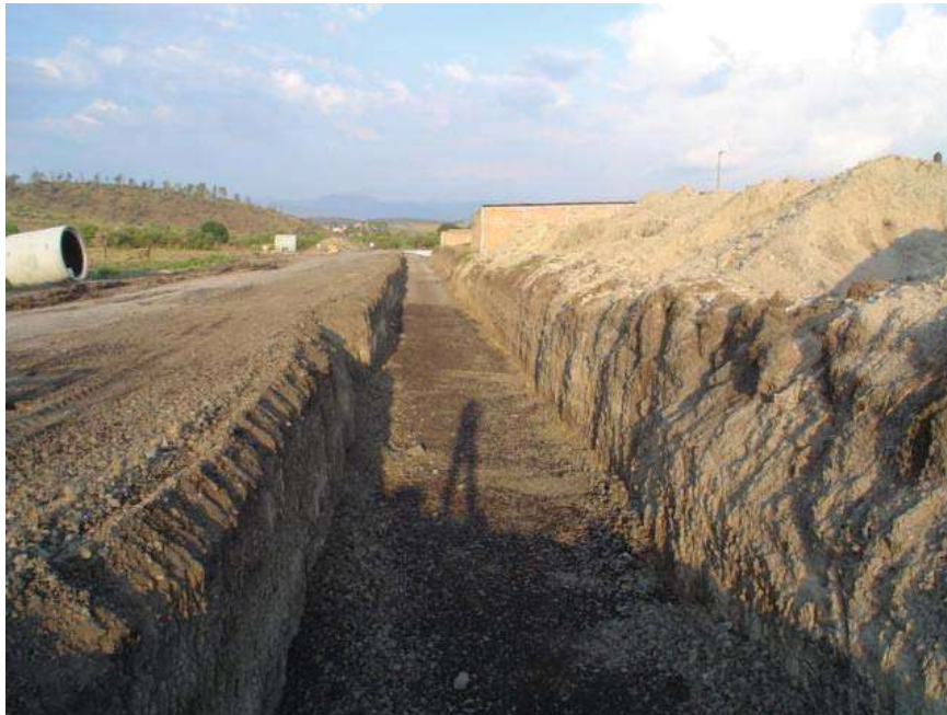
RELLENO CON MATERIAL PRODUCTO DE EXCAVACION
