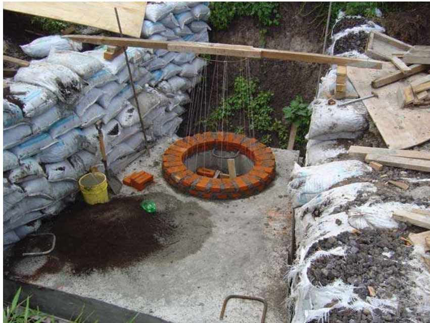
01 CONTRUCCION POZOS DE VISITA
