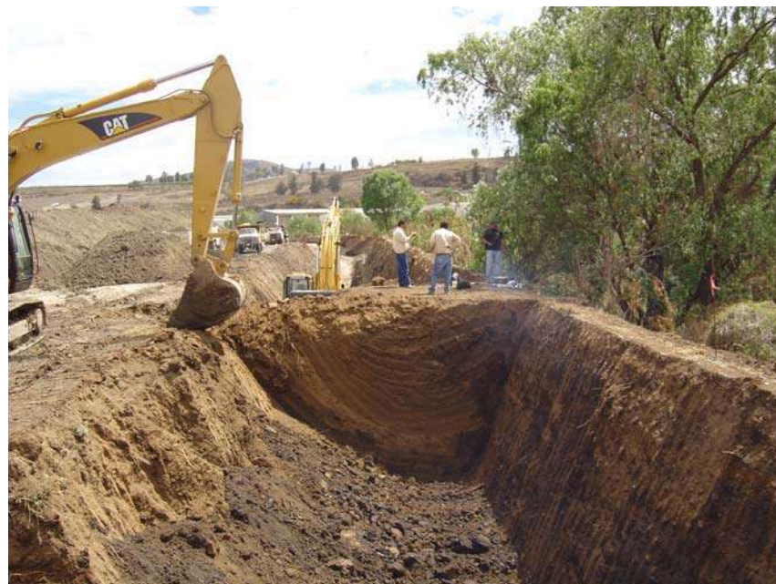
EXCAVACION DE CAJON PARA TENER BANQUETA DE APOYO DE LOS EQUIPOS DE EXCAVACION DE LA ZANJA
