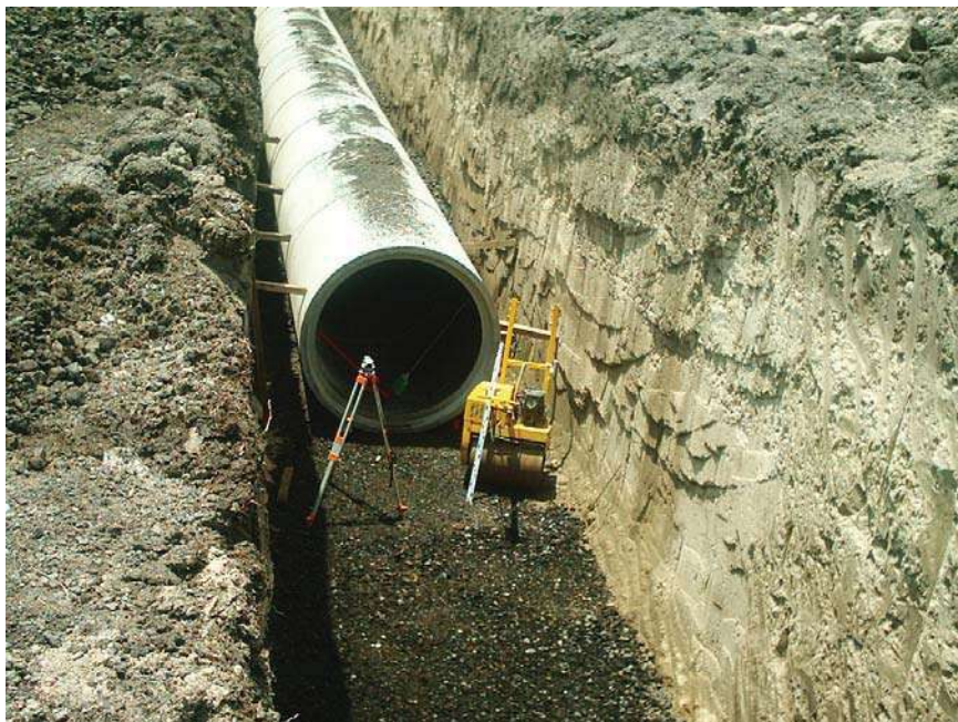
RODILLO VIBRATORIO MANUAL PARA ACOMODO DE PLANTILA DE FILTRO
