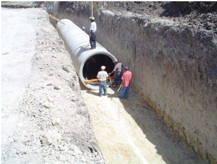
COLOCACION DE VIGA EN EL EXTERIOR DEL TUBO PARA REHALIZAR LA INSTALACION
