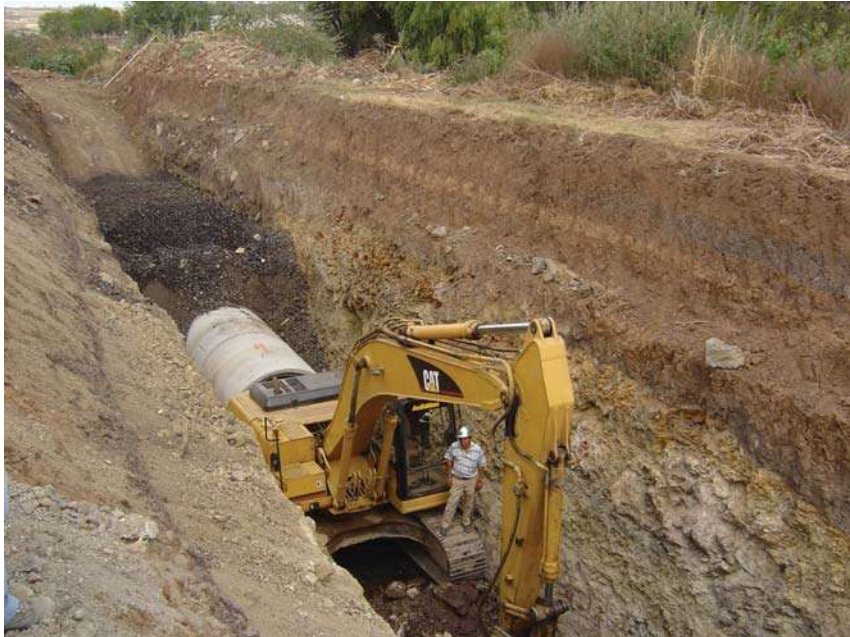
EXCAVACION EN MATERIAL TIPO B (13)
