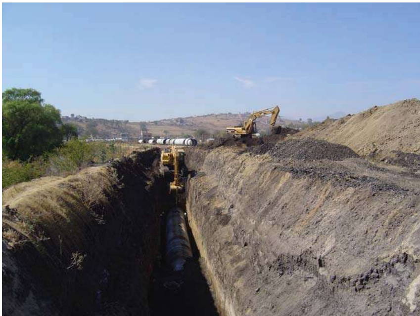
EXCAVACION EN MATERIAL TIPO B (13)
