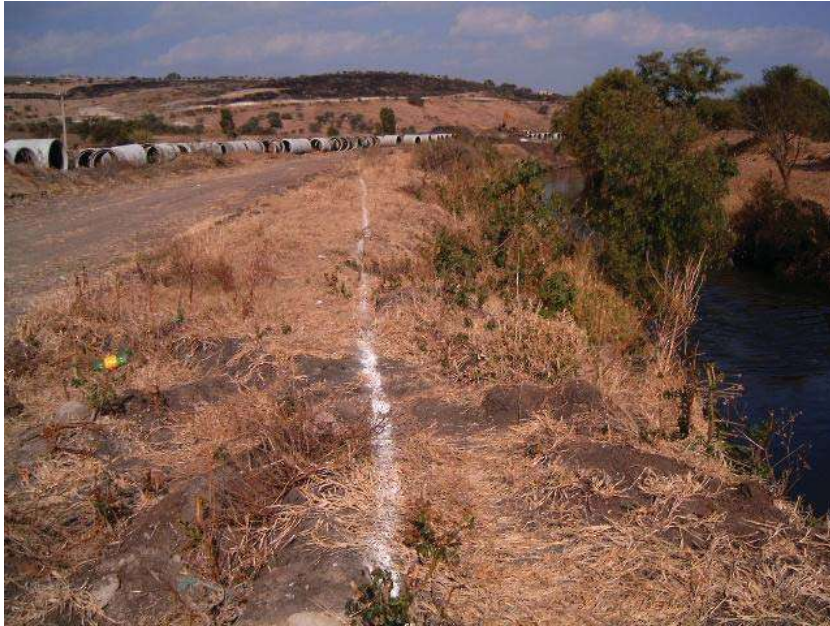
POLIGONAL ABIERTA PARA RECONSTRUCCION DE TRAZO
