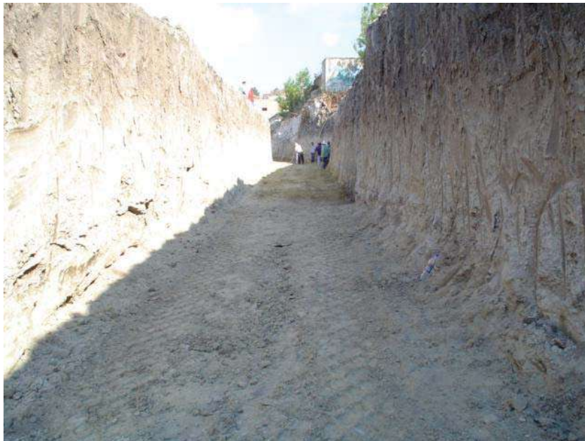
AFINE DE EXCAVACION EN LA PARTE MAS BAJA PARA DAR UN ANCHO DE 3.40 M PARA ALOJAR TUBERIA (2)
