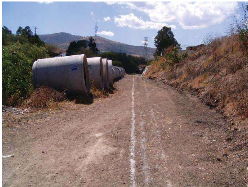
RECONSTRUCCION DE TRAZO Y NIVELACION DEL EMISOR
