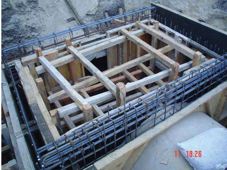
CIMBRA EN MUROS DE CAJAS DE VISITA
