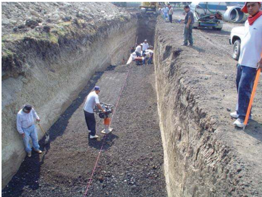
ACOMODO DE MATERIAL DE FILTRO CON APISONADOR DE IMPACTO MANUAL (BAILARINA) (2)
