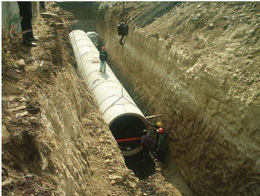
ALINEAMIENTO VERTICAL DE LA INSTALACION DE TUBERIA
