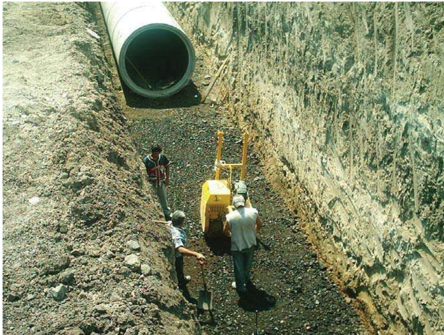
RODILLO VIBRATORIO MANUAL PARA ACOMODO DE PLANTILA DE FILTRO
