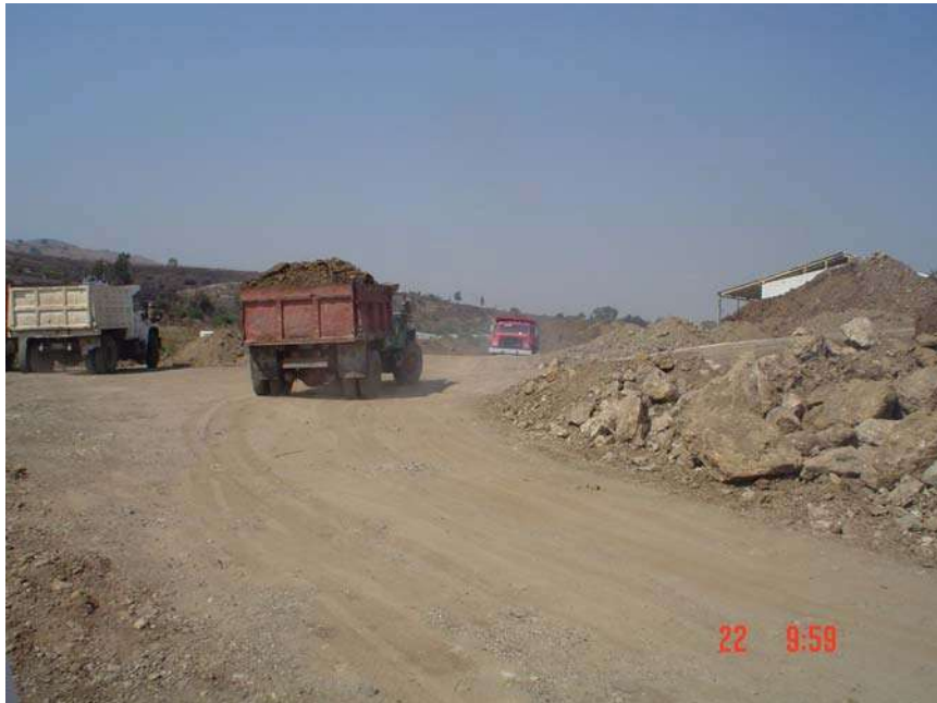
ACARREO DEL MATERIAL PRODUCTO DE LA EXCAVACION
