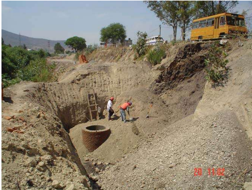
CONTRUCCION POZOS DE VISITA
