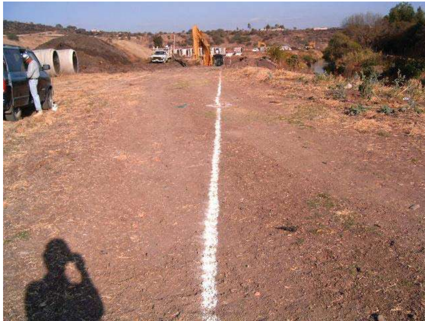
RECONSTRUCCION DE TRAZO Y NIVELACION DEL EMISOR
