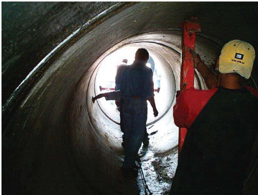
COLOCACION DE VIGA A PRESION EN EL INTERIOR DEL TUBO
