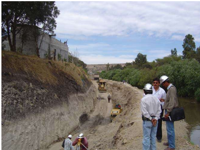
COMPACTACION DE MATERIAL PRODUCTO DE LA EXCAVACION CON COMPACTADOR DE SUELOS DE DOBLE TAMBOR LISO
