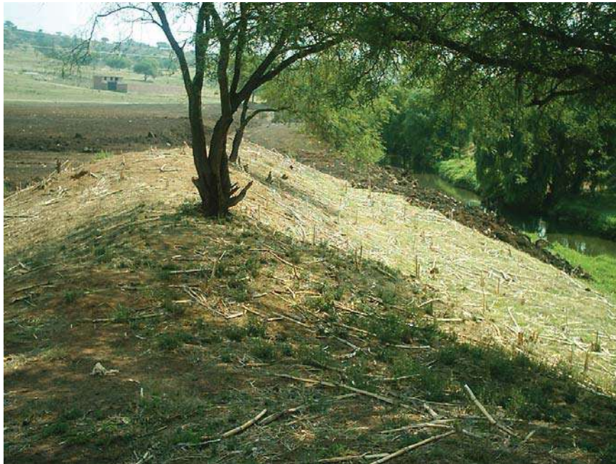
CORTE CON TRACTOR D8R CATERPILAR PARA ELIMINAR BORDOS EXISTENTES
