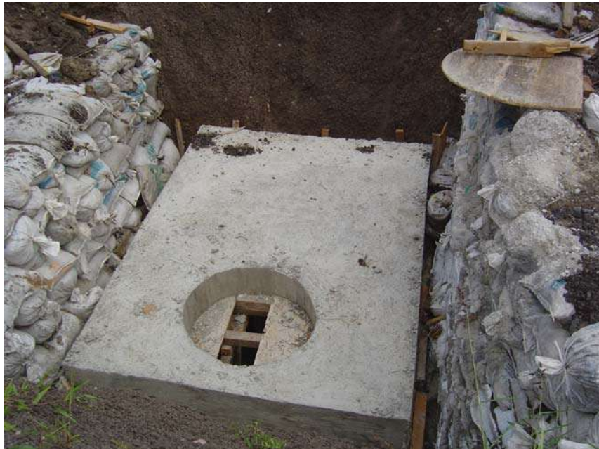
RELLENO CON MATERIAL DE BANCO EN CAJA DE VISITA
