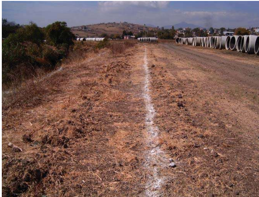
TRAZO DE FRANJA DE LA ZANJA PARA INICIAR EXCAVACION
