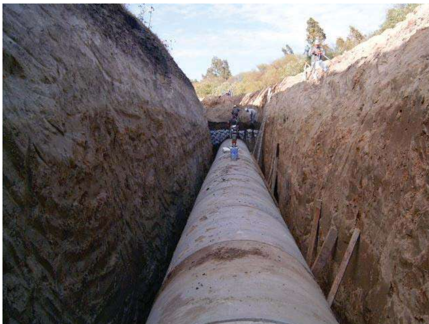
ALINEAMIENTO HORIZONTAL DE LA TUBERIA INSTALADA (2)
