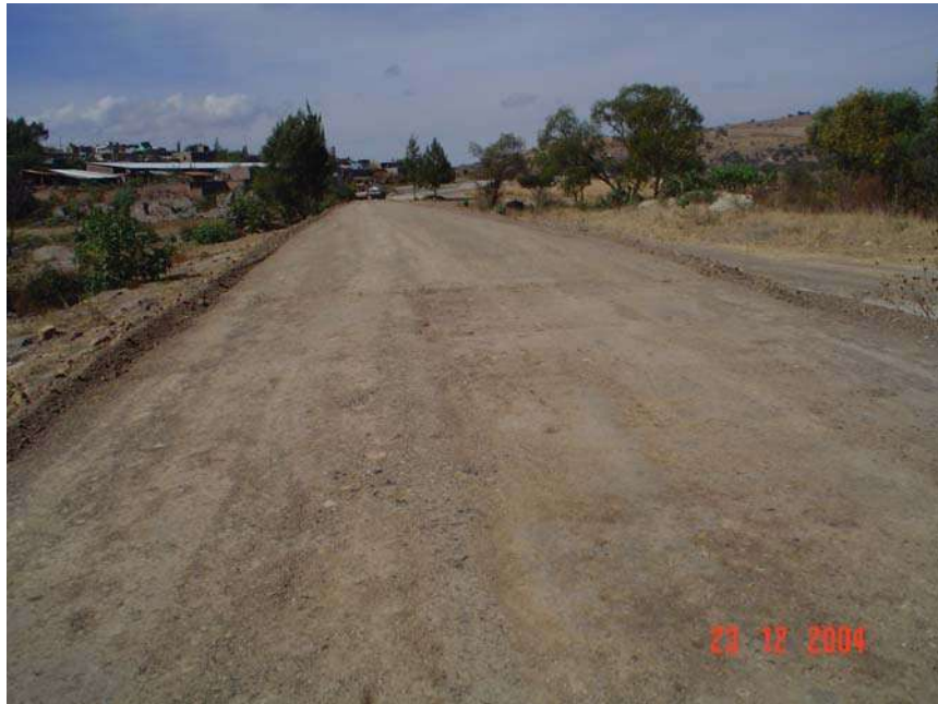
TERRAPLEN SOBRE EL TUBO (4)
