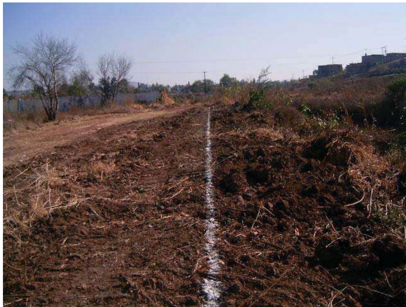
RECONSTRUCCION DE TRAZO Y NIVELACION DEL EMISOR
