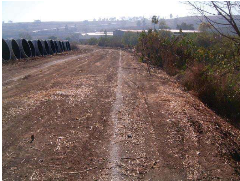
TRAZO DE FRANJA DE LA ZANJA PARA INICIAR EXCAVACION
