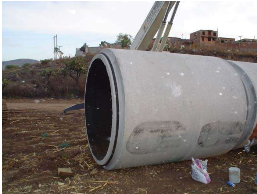
JUNTA DE HULE YA COLOCADA EN LA TUBERIA POR INSTALAR
