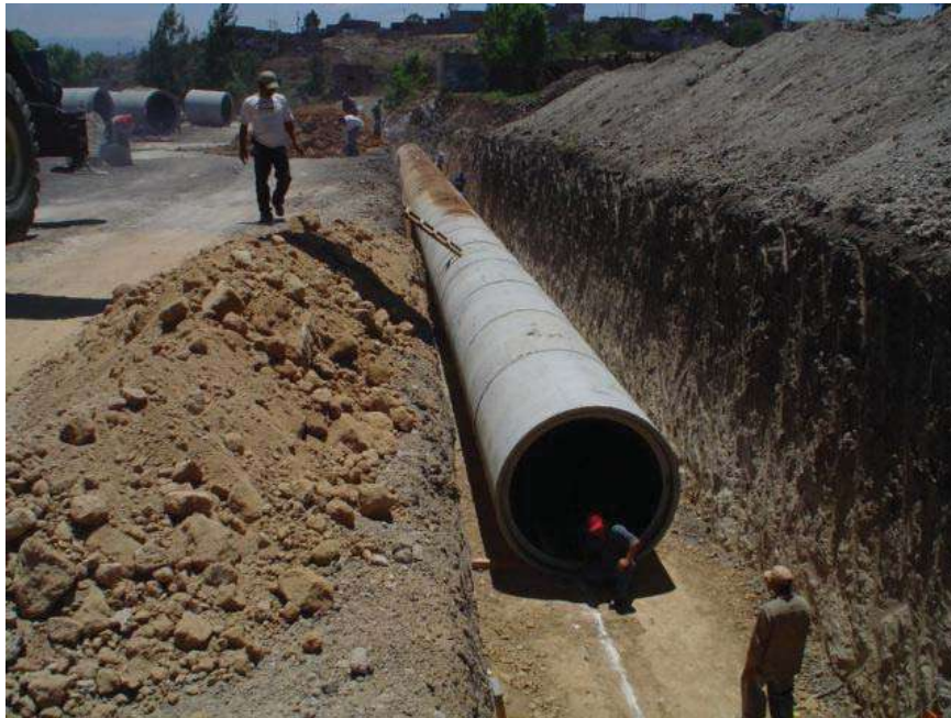
ALINEAMIENTO HORIZONTAL DE LA TUBERIA INSTALADA
