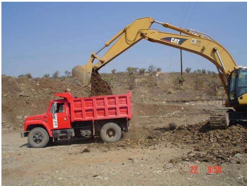
CARGA CON EXCAVADORA Y ACARREO EN CAMION VOLTEO DEL MATERIAL PRODUCTO DE LA EXCAVACION
