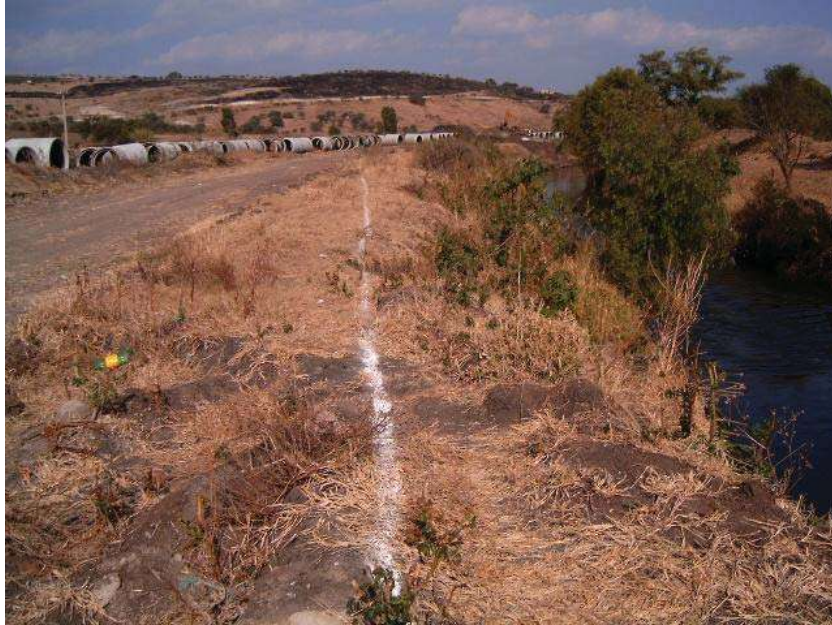
POLIGONAL ABIERTA PARA RECONSTRUCCION DE TRAZO
