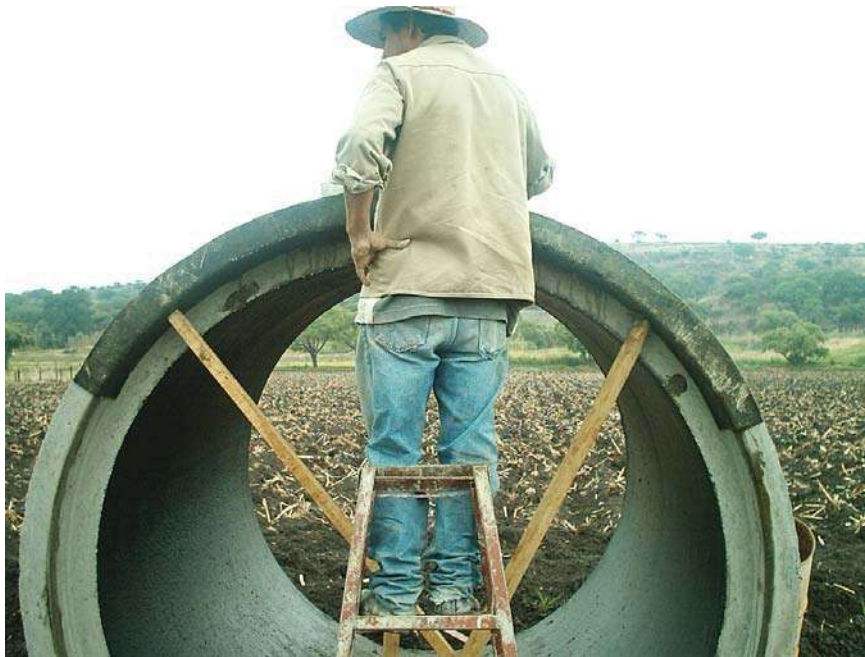
REPARACION DE TUBERIA
