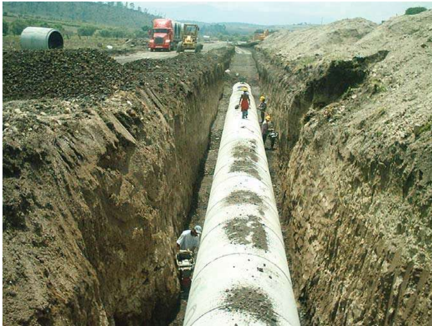
RELLENO ACOSTILLADO EN CAPAS DE 30 CM
