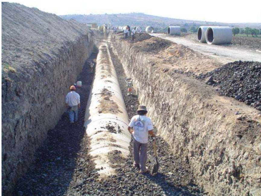
ACOSTILLADO CON MATERIAL DE BANCO EN LOS LADOS DE LA TUBERIA
