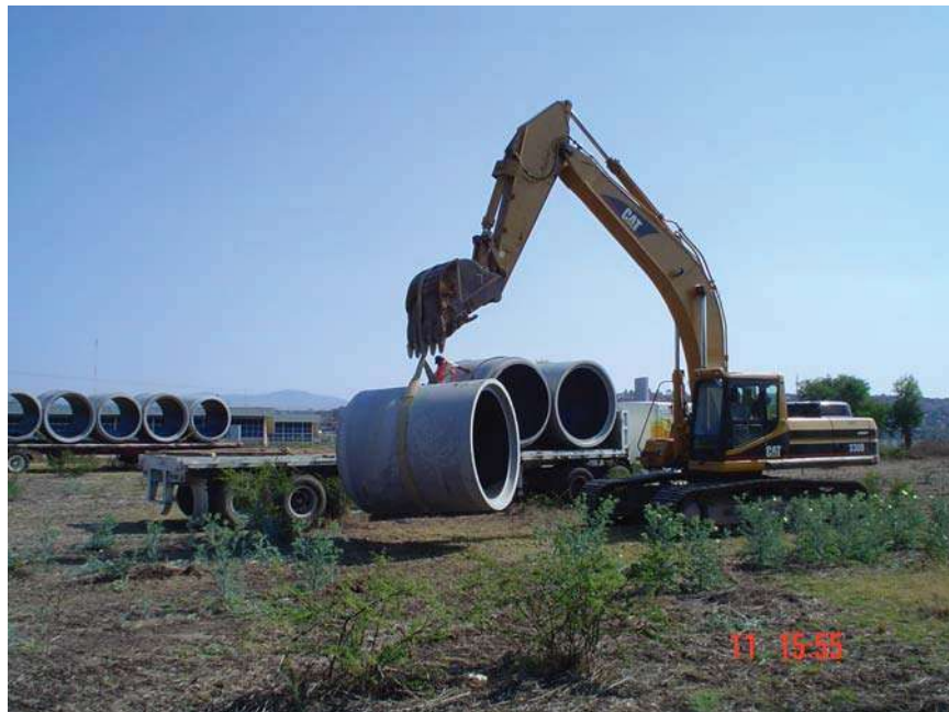
BAJADO DE TUBERIA DE PLATAFORMA DEL TRAILER (1)
