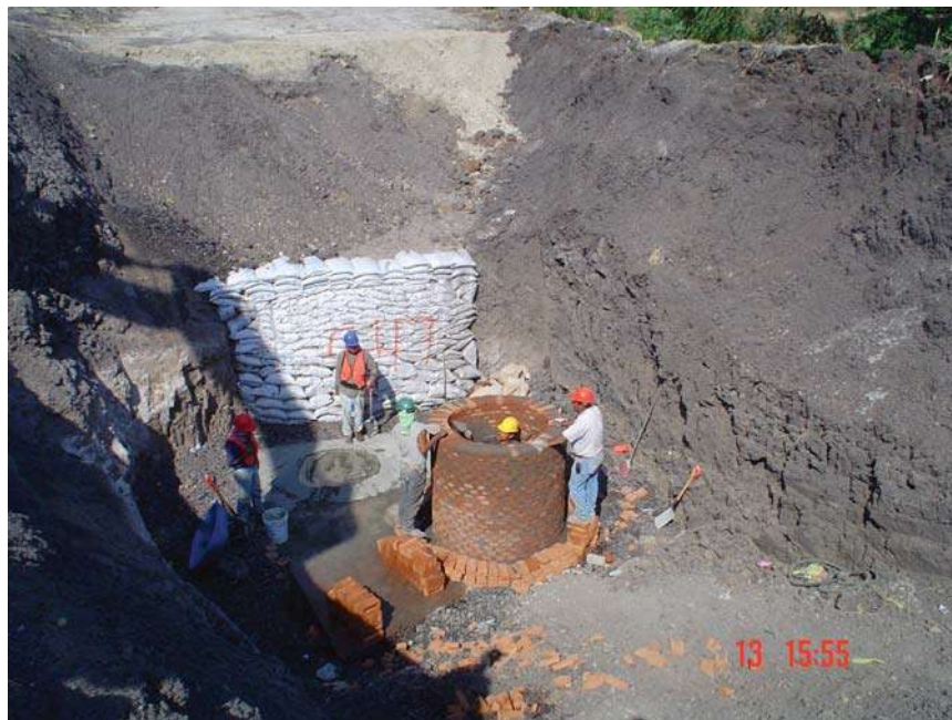
CONTRUCCION POZOS DE VISITA
