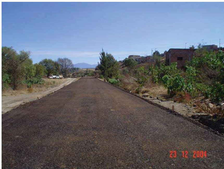
TERRAPLEN TERMINADO PARA PROTECCION DE TUBERIA
