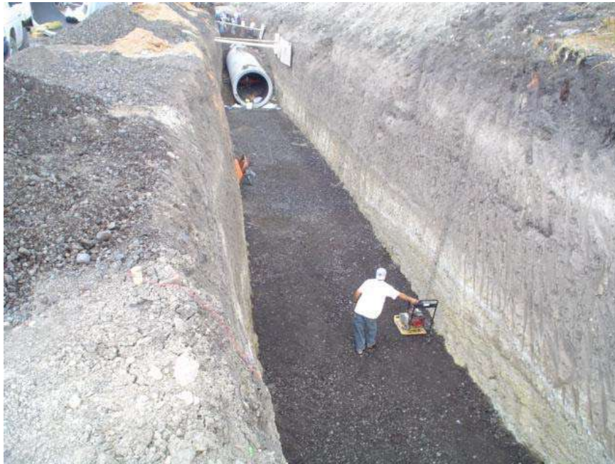
PLACA VIBRATORIA PARA ACOMODO DE MAETRIAL DE PLANTILLA FILTRO
