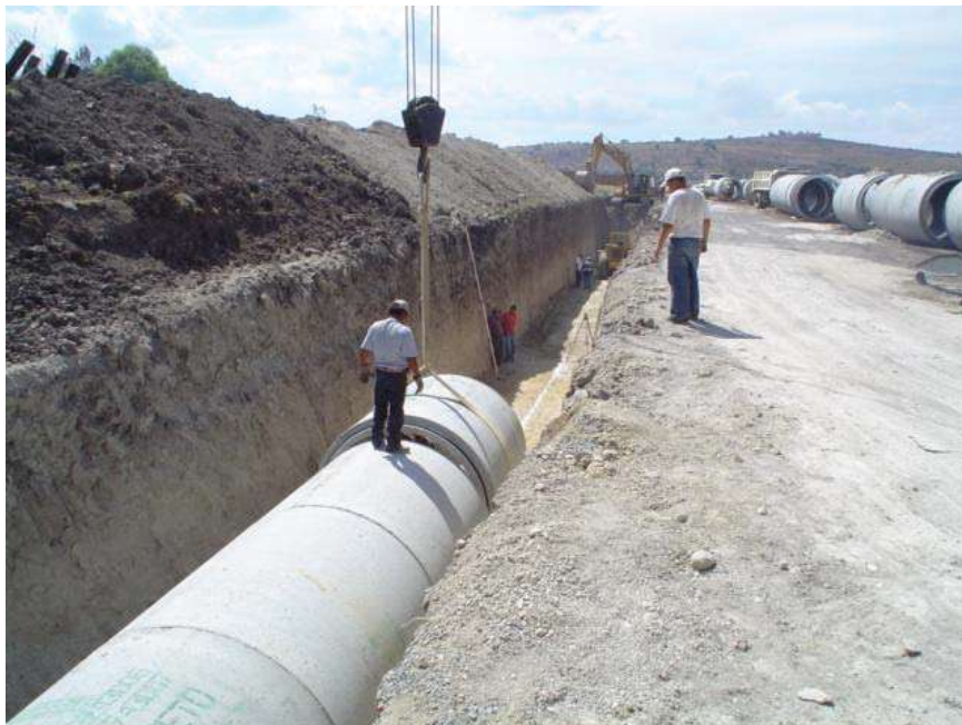
INSTALACION EN TRAMOS LARGOS POR LA ESTABILIDAD DEL MATERIAL Y LA POCA PROFUNDIDAD DE LA ZANJA
