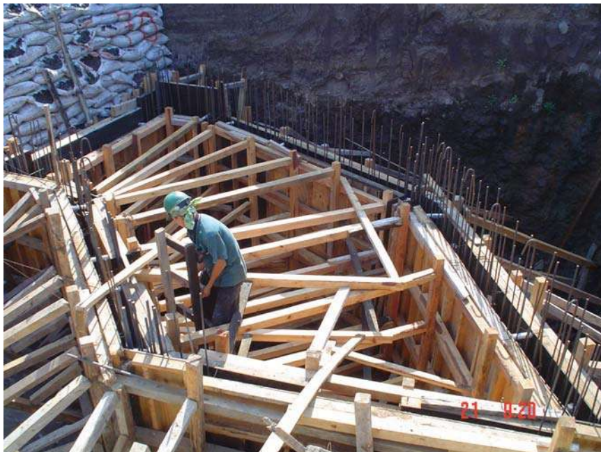
CIMBRA EN MUROS DE CAJAS DE VISITA (2)
