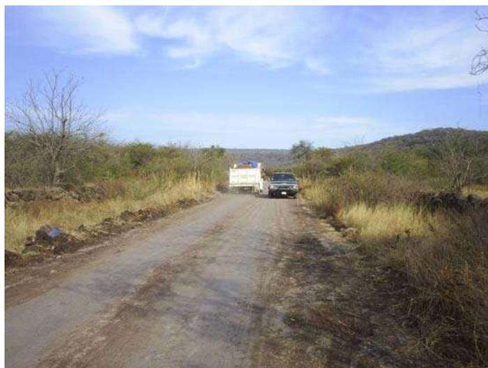
Sobre la superficie del camino se tiene un revestimiento en condiciones desfavorables, por lo que no representa un buen funcionamiento del camino.
