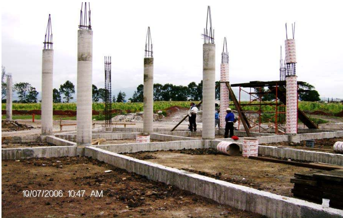
CIMBRA Y COLADO DE COLUMNAS CIRCULARES EN EL ÁREA DE GOBIERNO CON SONO-TUBO
