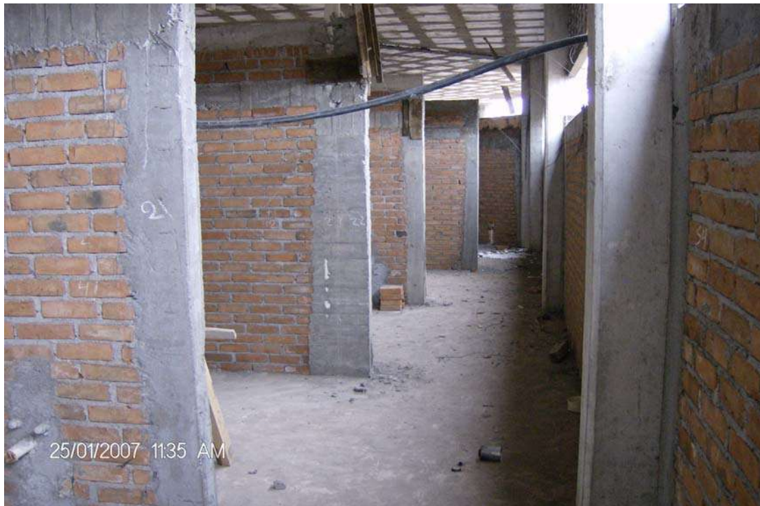
ALBAÑILERÍA OBRA INTERIOR CONSULTA EXTERNA
