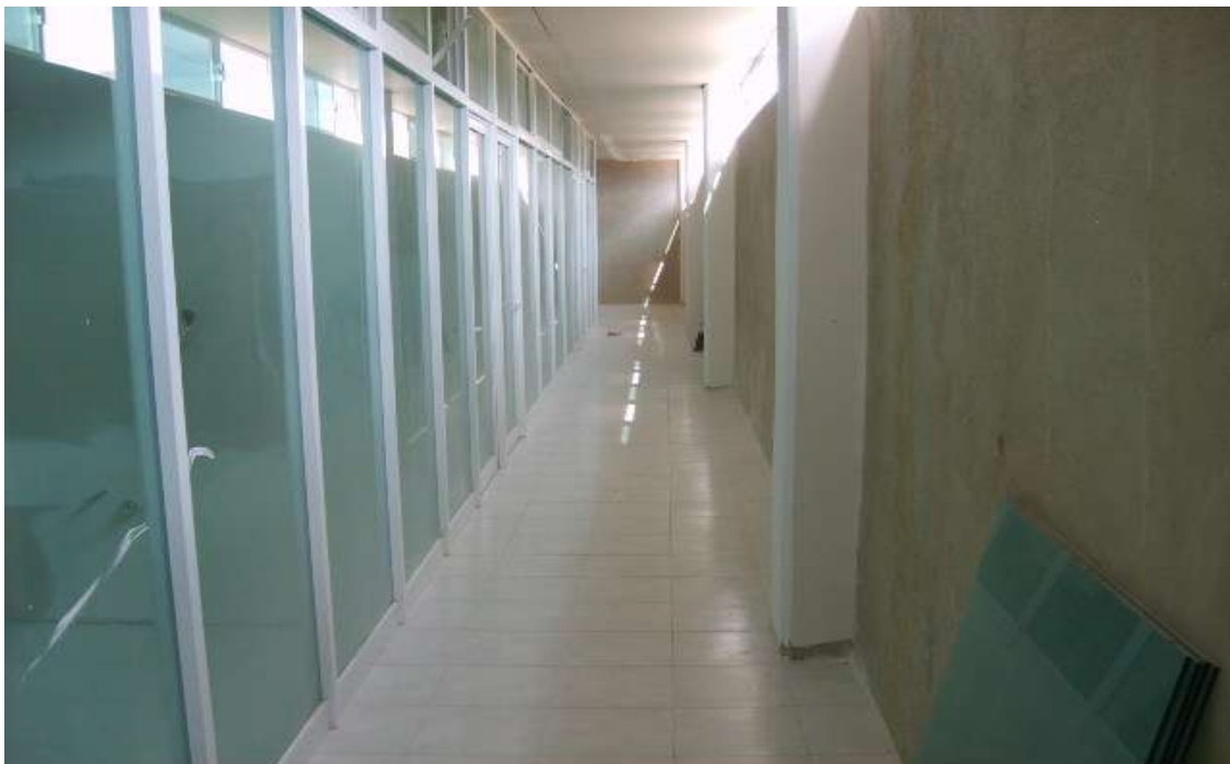
ACABADOS CANCELERÍA, PISOS Y PLAFÓN EN CONSULTA EXTENA
