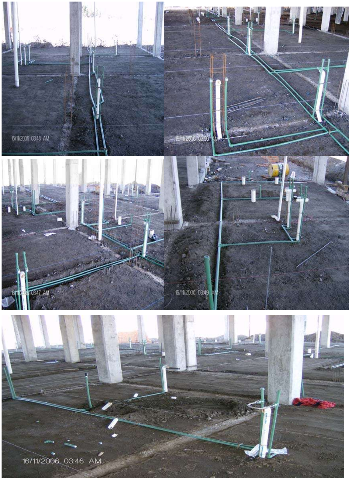
INSTALACIÓN HIDRÁULICA EN EL ÁREA DE URGENCIAS Y CONSULTA EXTERNA
