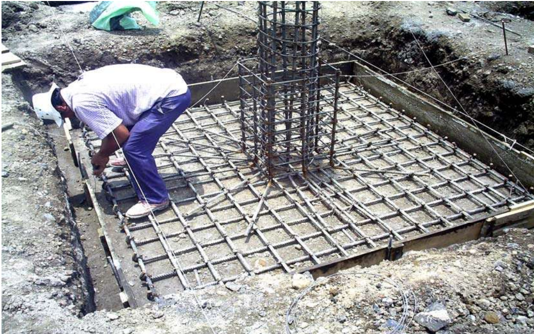
CONSTRUCCIÓN DE ZAPATAS Y DADOS EN EL ÁREA DE GOBIERNO
