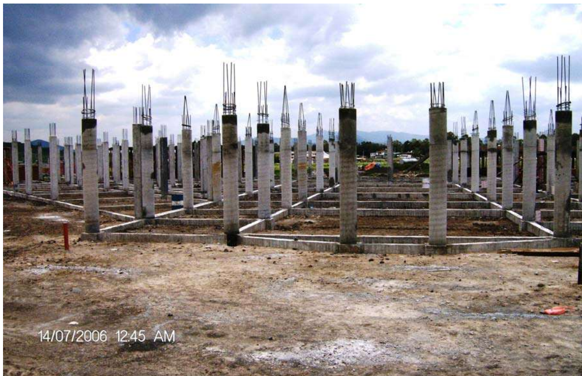
FRENTE DE GOBIERNO CON LAS COLUMNAS CIRCULARES TERMINADAS (ACCESO PRINCIPAL)
