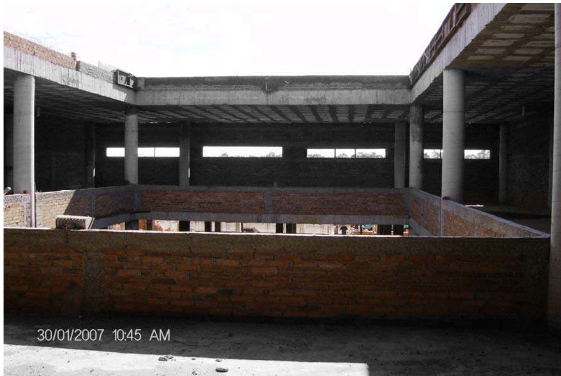
ALBAÑILERÍA EN PLANTA ALTA ÁREA DE GOBIERNO
