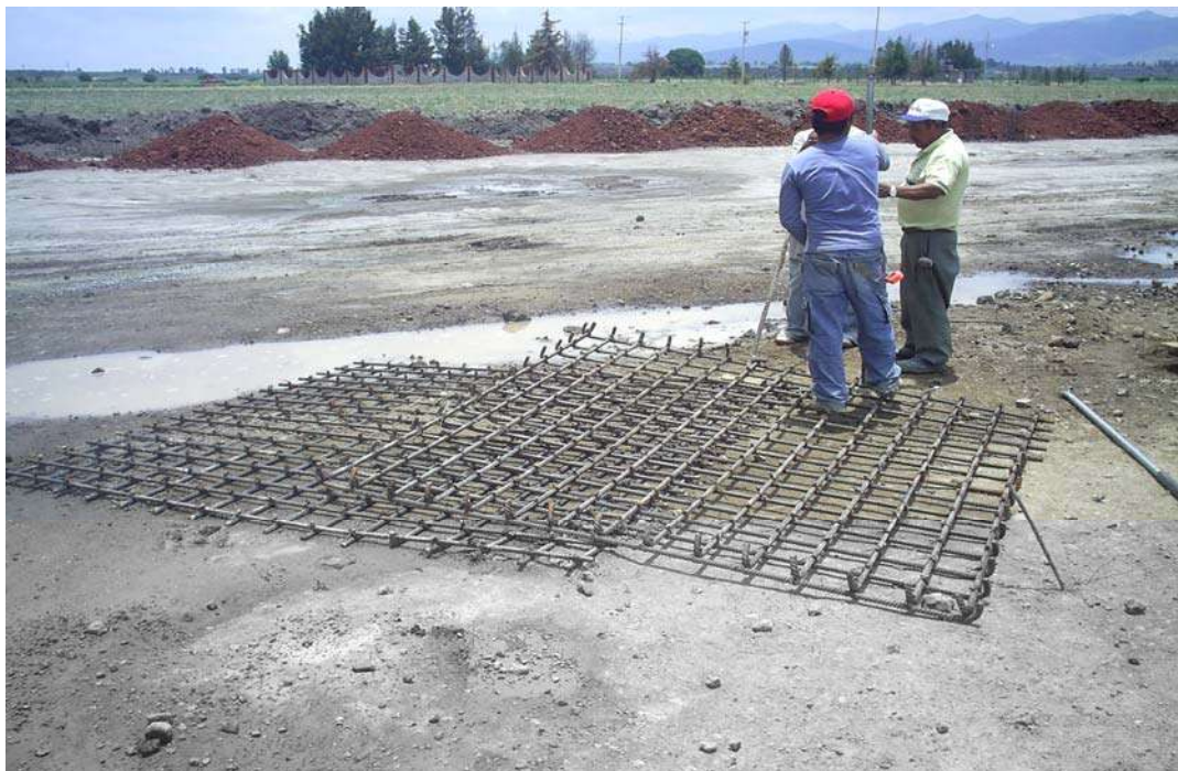
ARMADO DE ACERO PARA LAS ZAPATAS EN EL ÁREA DE GOBIERNO
