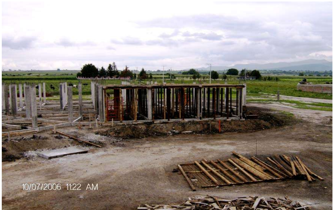
CIMBRA DE URGENCIAS
