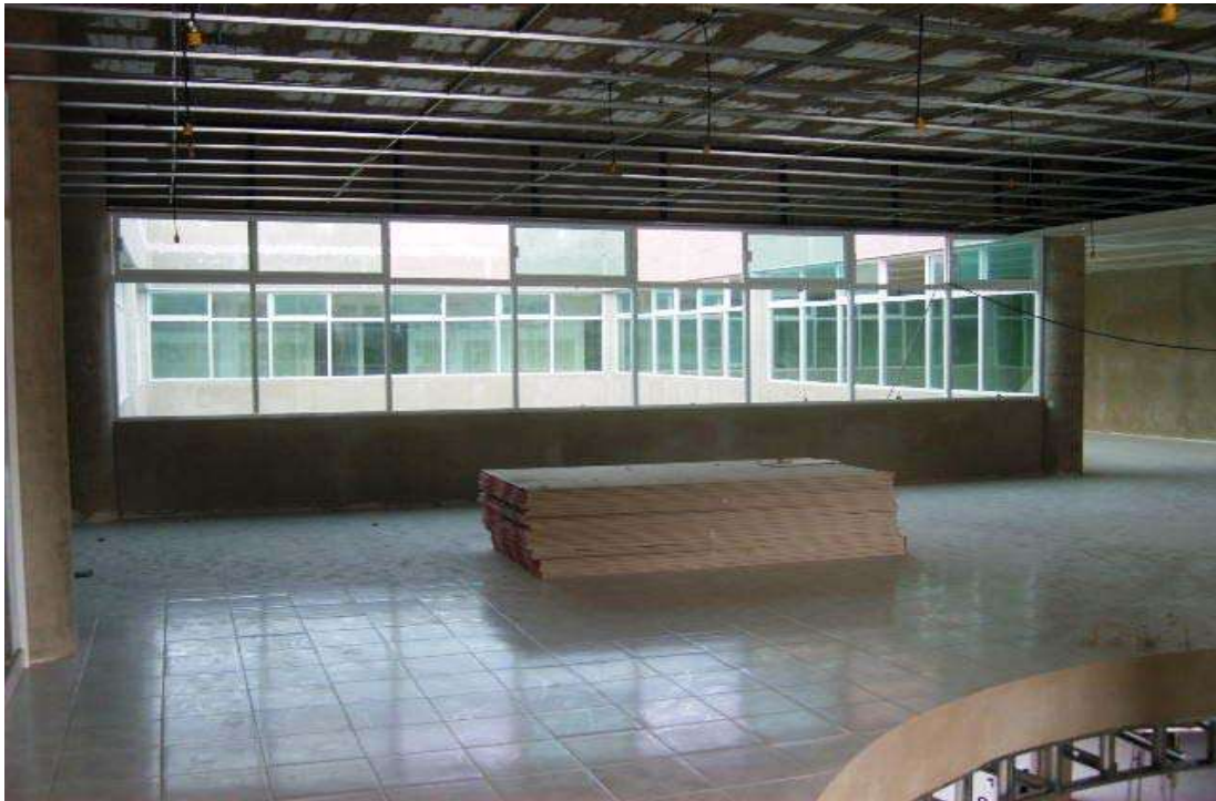
PISOS, CANCELERÍA Y SUSPENSIÓN DE FALSO PLAFÓN EN PLANTA ALTA
