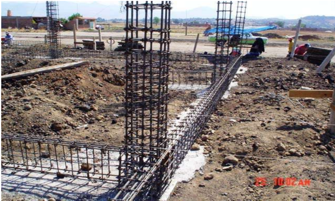
CONSTRUCCIÓN DE TRABES Y HABILITADO DE ACERO EN EL ÁREA DE URGENCIAS
