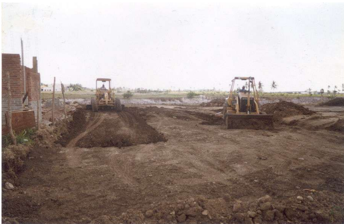
Terreno Natural (preparación plataforma)
