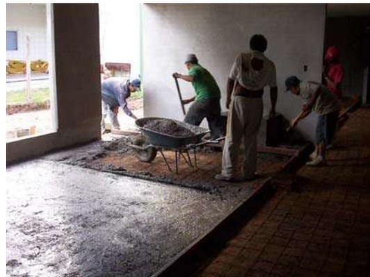
***Ilustración 11.- FIRMES DE CONCRETO REFORZADO***
