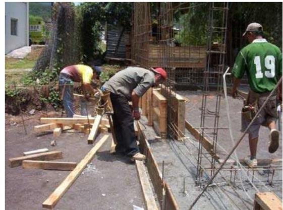
**Ilustración 6.- ELABORACIÓN DE LA PLANTILLA Y PREPARACIÓN DEL DESPLANTE**
