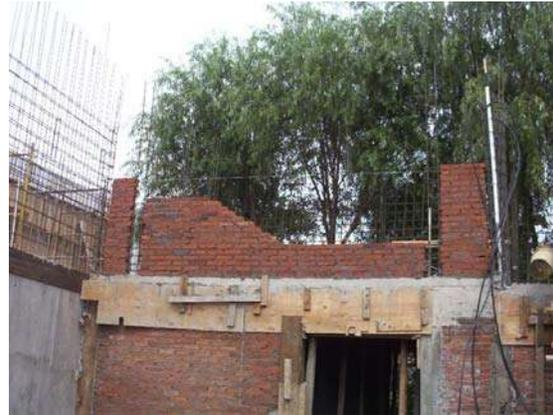
*Ilustración 8.- MUROS DE TABIQUE EN CUARTO DE MÁQUINAS Y EN VESTIBULO*
