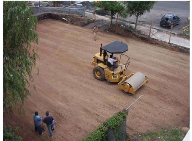
**Ilustración 2.- MEJORAMIENTO DEL TERRENO CON MATERIAL DE FILTRO Y DOS CAPAS DE MATERIAL DE BASE PARA EDIFICIO.**
