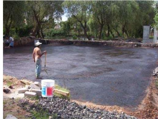
**Ilustración 5.- PROTECCIÓN CON UN RIEGO DE IMPREGNACIÓN PARA RESGUARDAR LA BASE**
