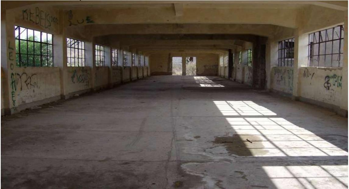
Fotografía No. 37.- Esta fotografía se obtiene para mostrar que las traveses y columnas no tienen daño estructural como las mostradas en los espacio de la fotografía No.24 a la No.27 donde se muestra claramente el daño estructural en la cruzía izquierda de la planta baja específicamente en traveses.
