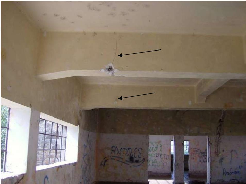
Fotografía No. 24.- se muestran visiblemente fisuras en traves sin deformación por Trabajo de carga.
