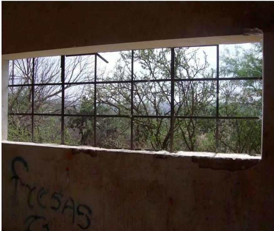
Fotografía No. 28.- Se muestra el tipo de cancelaría y su estado actual que todavía es aceptable y esta hecha con Angulo de fofó de 1 ½" x ¼" ancladas al muro en sus 4 esquinas y al centro con anclas del mismo material. Se observa además el tipo de paisaje semi desértico de la región, esta ventana se encuentra en la fachada lateral derecha del edificio y se encuentra ubicada a un lado del área de acopio.
