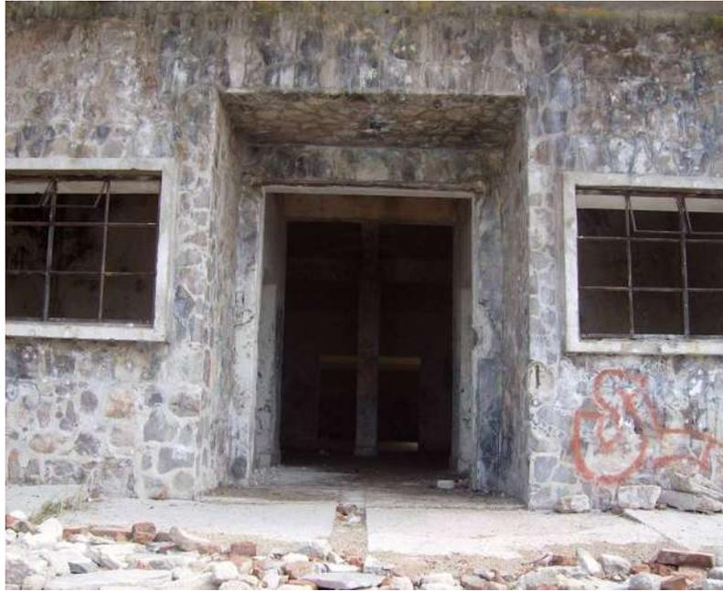
Fotografía No. 7.- muestra el acceso principal al edificio del centro de recreación y vemos que aun conserva su acabado en piedra y la cancelaría de ventanas, pero que es piso de acceso habrá que retirarlo y colocar nuevo.
