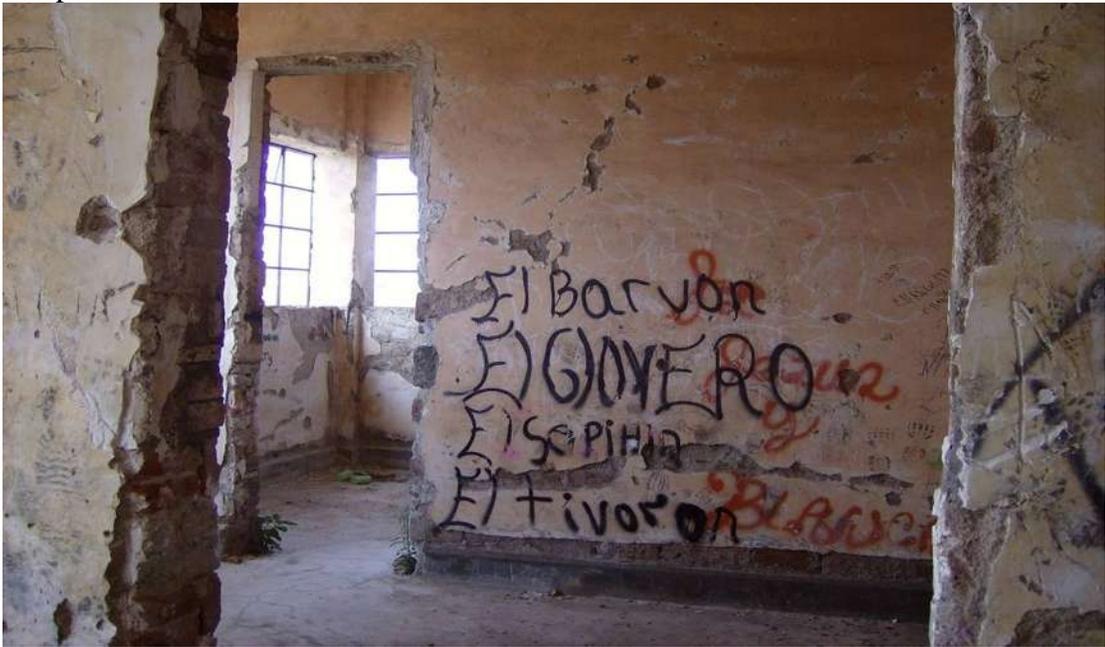
Fotografía No 36.- Espacio ubicado en la planta alta y que nos muestra las condiciones generales en cuanto acabados, traveses, columnas y estructura en ventanas, mostrando únicamente falta de puertas.
