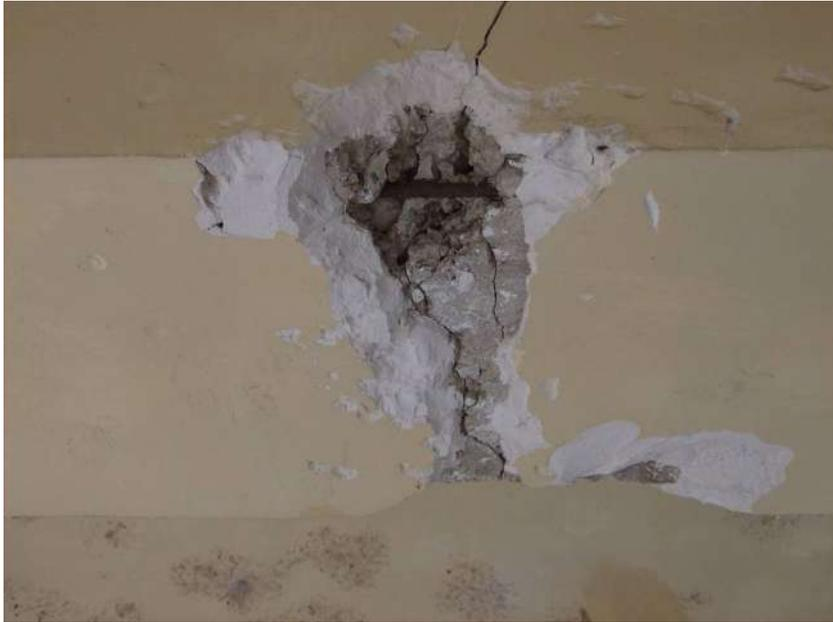
Fotografía No. 26 se observa de manera mas clara tanto la trayectoria de la fisura, como su tamaño y por lo menos una referencia del tipo de varilla que se uso en el armado, desconociéndose su conformación estructural.
