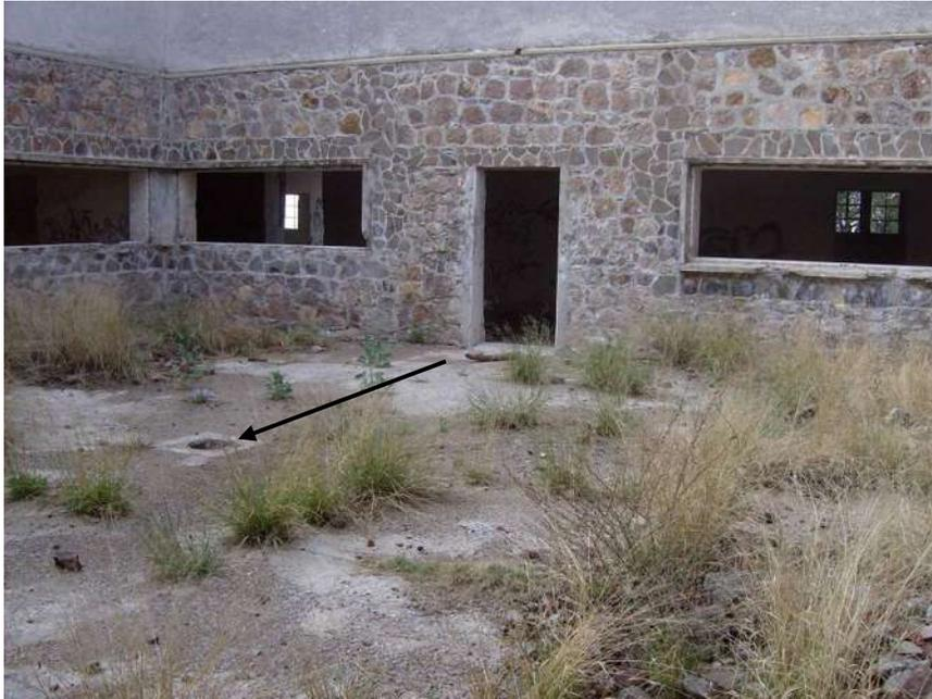
Fotografía No. 21.- cubo de luz y ventilación a un lado del cuarto frío, con aplanados semidestruídos que deberán ser sustituidos.
