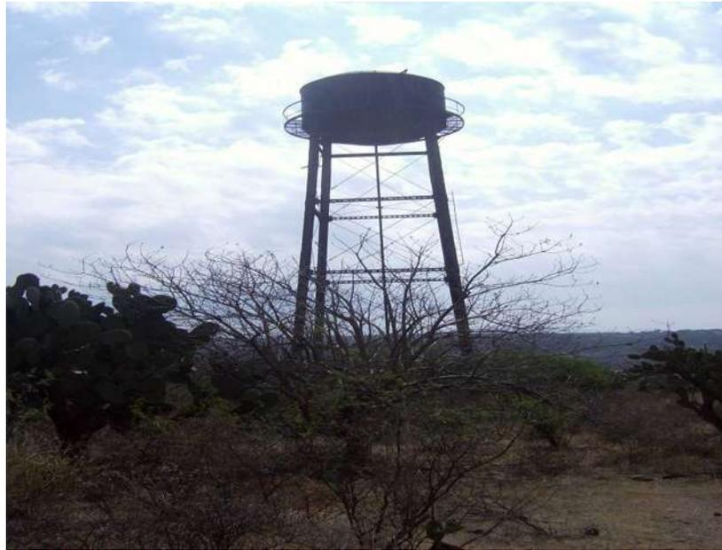
Fotografía No. 40.- muestra el tanque elevado para almacenamiento de agua potable el cual se abastece por medio de un tubo de foyo de 3" de diámetro
