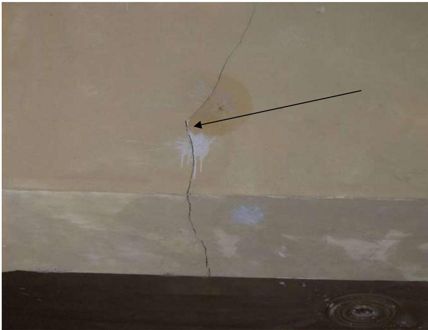
Fotografía No. 27.- acercamiento de la grieta de otra de las trabes primarias, aparece en ambas caras y como detalle importante mencionare que tan solo aparece en la planta baja y tan solo en esta crujia, en ningún otro espacio tenemos este problema, la propuesta de solución se presenta en otro espacio de la misma tesis
