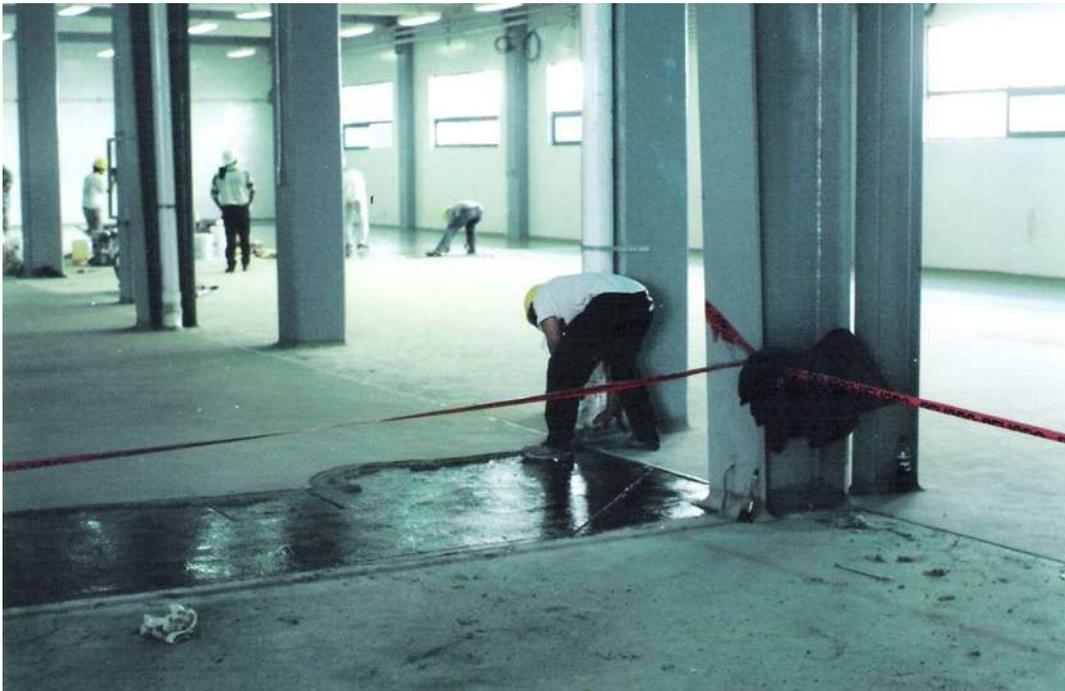
Colocación de piso epóxico y la curva sanitaria alrededor de las columnas y en las esquinas de los muros en el área de producción y galvano.
