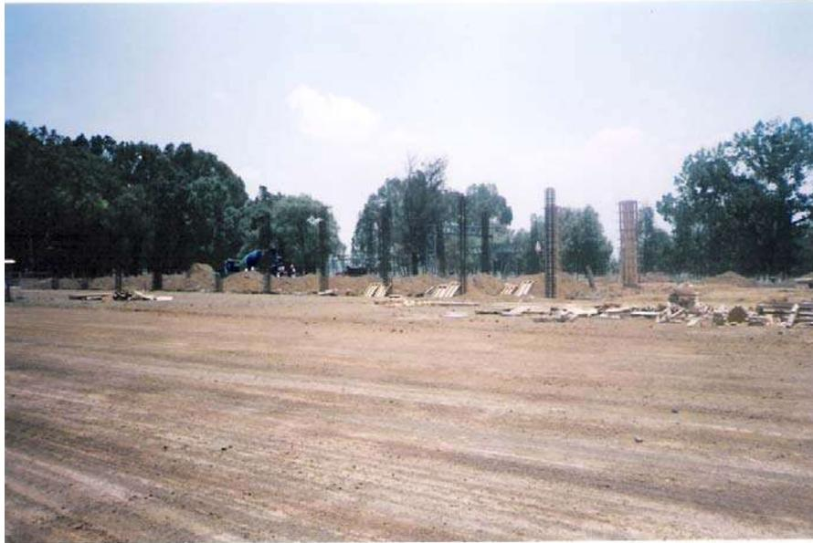
Construcción de las columnas de concreto reforzado en el edificio de servicios auxiliares.
