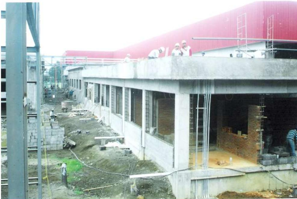
Construcción de muros de block en el edificio de servicios auxiliares.
