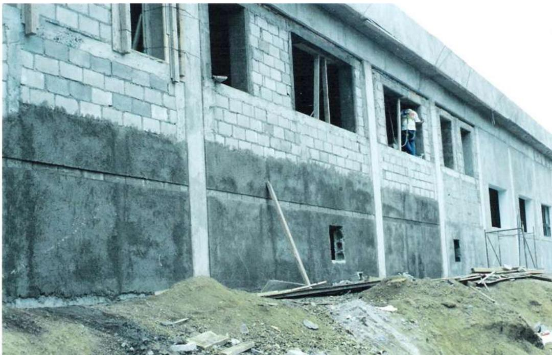
Colocación de repellado común en edificio de servicios generales.
