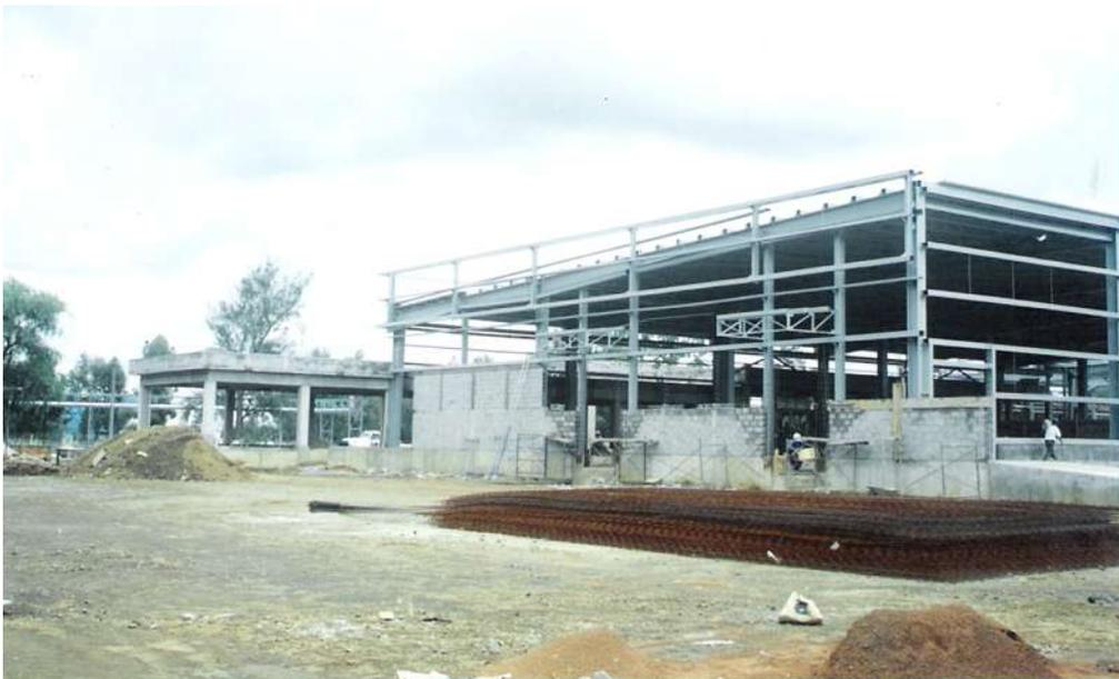
Colocación de lámina galvanizada multitecho en el área del almacén.
