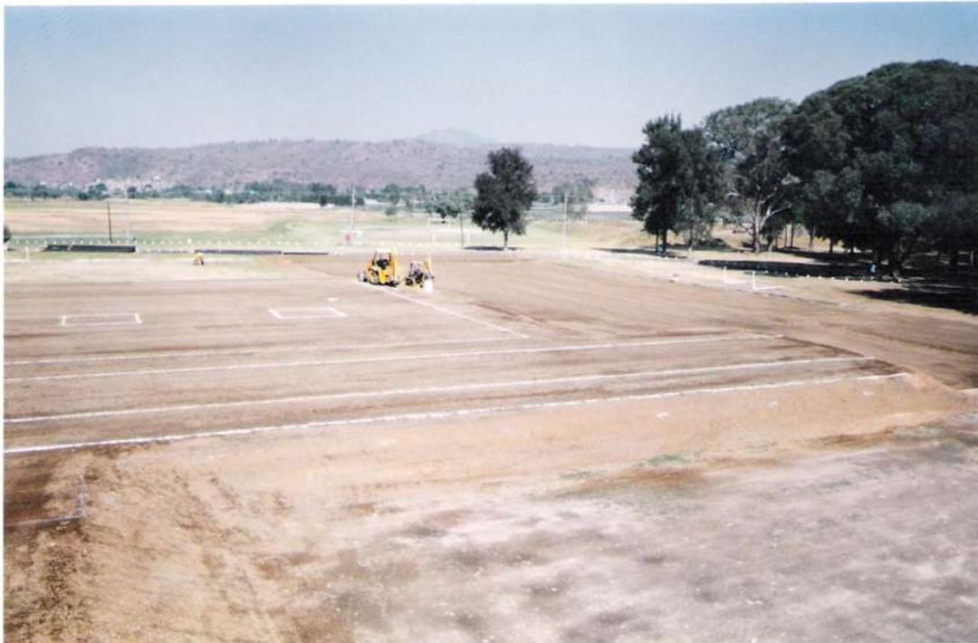
Realización del trazo para la excavación de las zapatas aisladas y corridas
