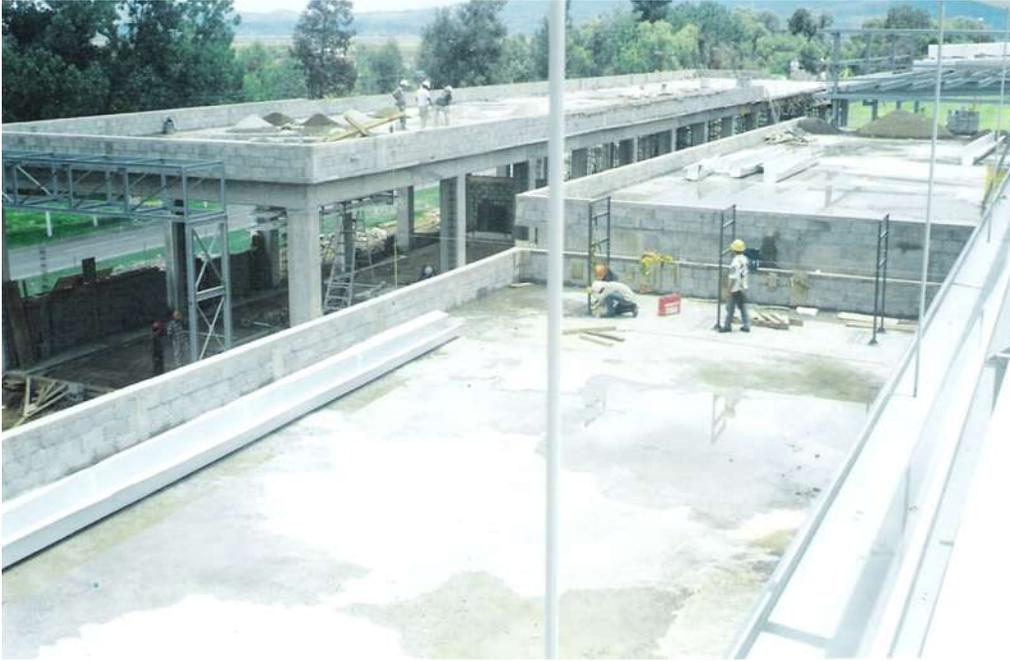
Impermeabilización de el edificio de servicios generales y servicios auxiliares.
