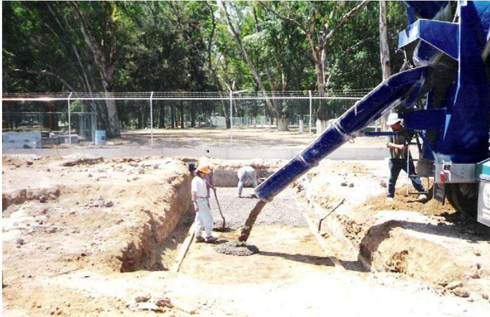
Se realiza la colocación de la plantilla, realizando la descarga del concreto directamente del camión utilizando solamente el canalón, ya que se puede acercar el camión a un costado de la excavación en donde se construirá la plantilla.
