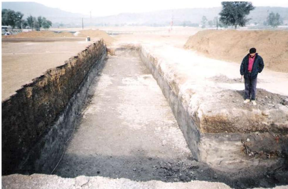
Excavación entre el edificio de almacén y el patio de maniobras en la cual se va a construir el muro de contención.
