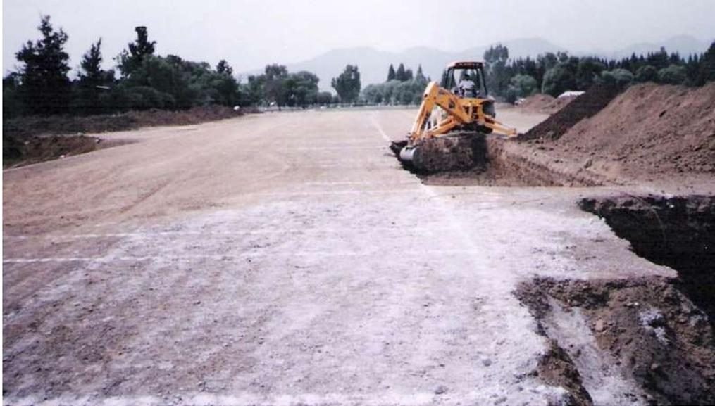
Excavación en la plataforma para la construcción de las zapatas
