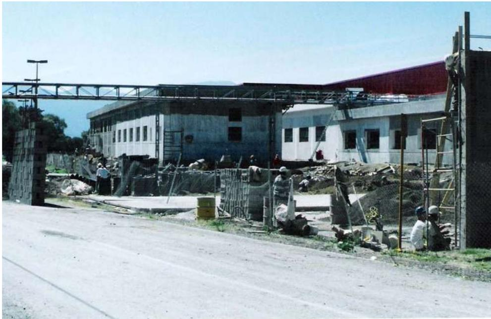
Colocación de pintura vinilica en exteriores del edificio de servicios generales y auxiliares.
