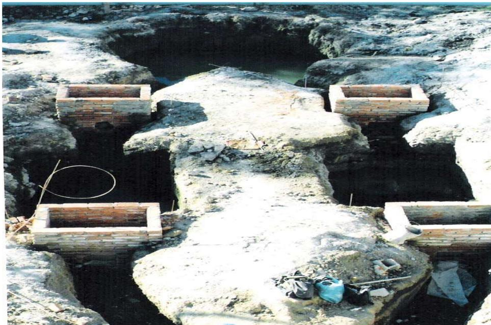
Se construyen fosas sépticas y pozos de absorción para el tratamiento del drenaje sanitario.
