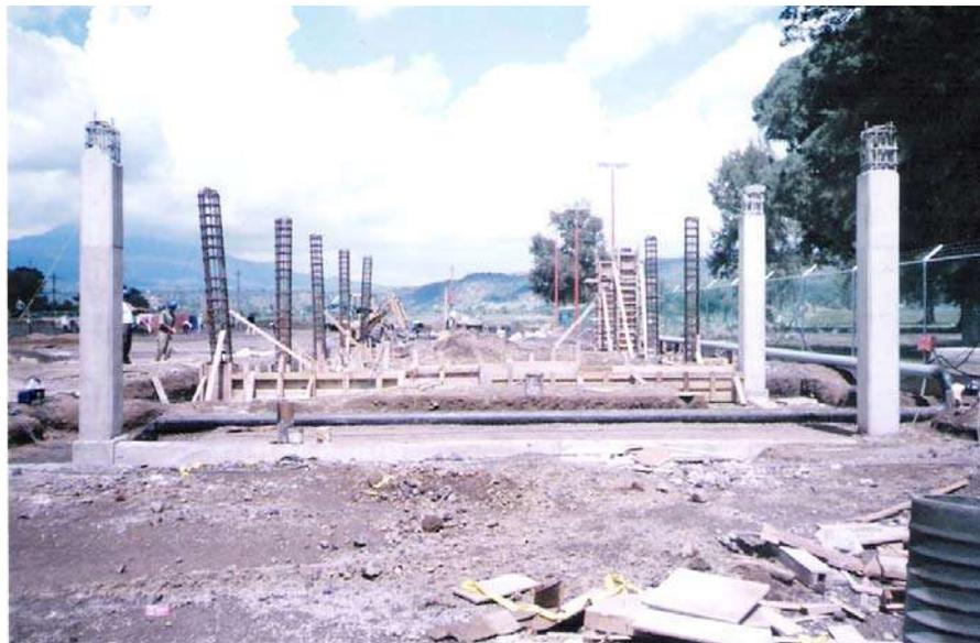
Construcción de las columnas de concreto reforzado en el edificio del comedor.
