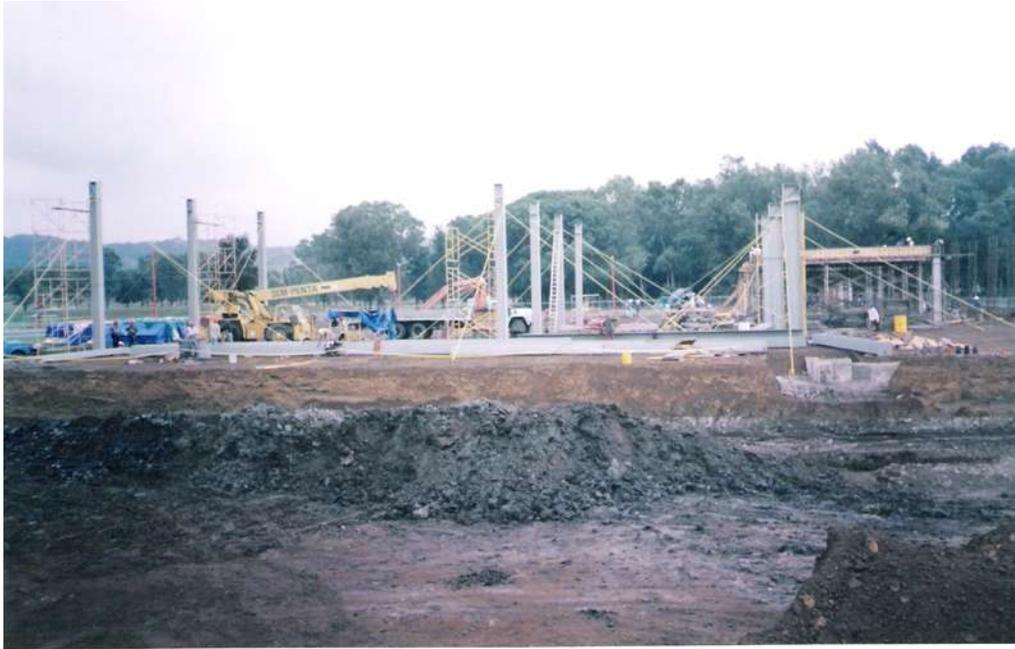
Colocación de las columnas de acero estructural en el edificio de producción y almacén.
