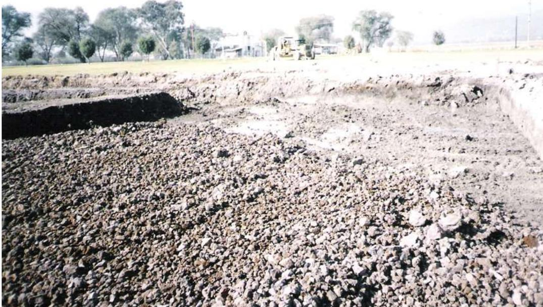
Colocación de la capa de filtro hasta el nivel de las agua freáticas.
