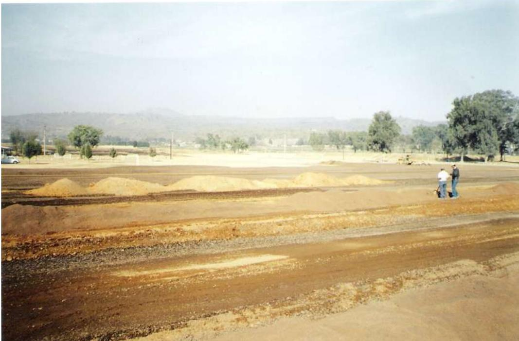
Colocación del relleno de la plataforma, el material utilizado es tezontle cribado de 2" a menores mezclado con limo amarillo en proporción volumétrica de 60 – 40%, y compactadas al 90 % proctor.
