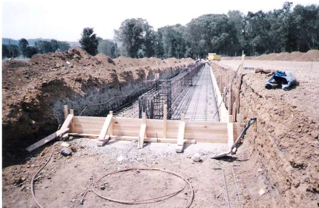
Teniendo construidas las plantillas se procede al armado de las zapatas de acuerdo al proyecto y se realiza la colocación de la cimbra.
