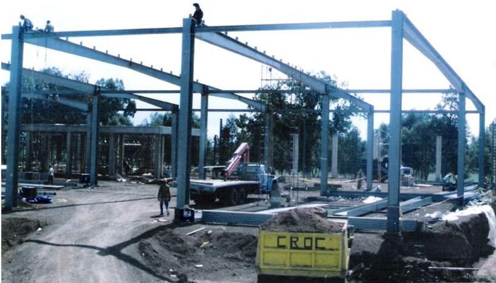
Colocación de los traveses de acero estructural en la nave principal en el área de producción.
