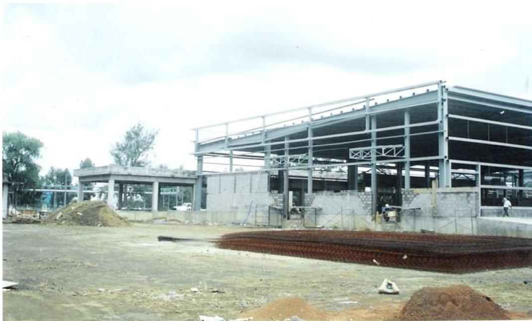
Armado del acero de refuerzo para la losa de piso del patio de maniobras.
