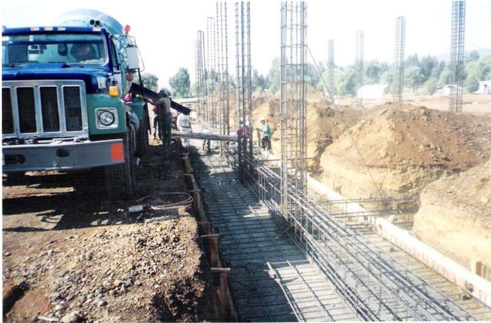
Se revisará la nota de salida del camión de concreto para que cumpla con la resistencia del proyecto, el tiempo de salida del camión, se realizarán las pruebas de revenimiento y se tomaran las muestras para los cilindros para la realización de las pruebas de resistencia por el laboratorio de la obra.
