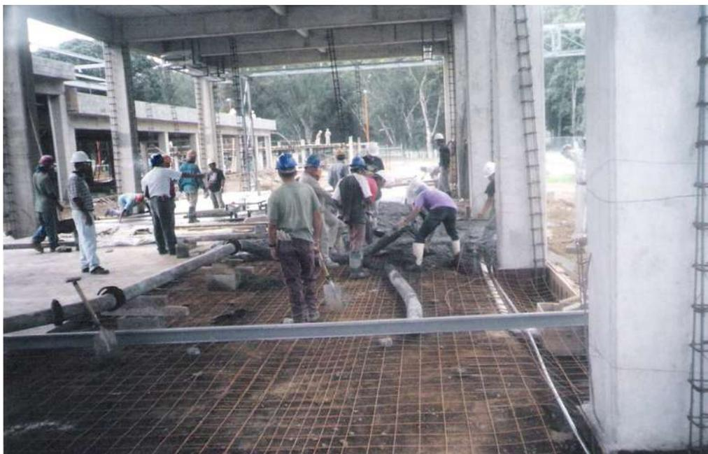
Colocación de firme de concreto en el edificio de servicios generales
