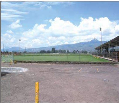
Foto IMTA 2004. Canchas deportivas que se inundan hasta 1.80 metros de altura a consecuencia
