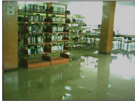
Foto obsequio de la Biblioteca Francisco J. Mújica. Muestra pérdidas totales de libros de consulta ya que en el interior del edificio el agua alcanza una altura de 50 centímetros.
