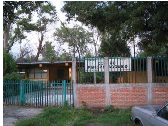
Foto IMTA 2003. Centro Psicopedagógico, que se encharca causando suspensión de labores docentes. Al igual que en el caso anterior las aguas anegadas proceden desde la Avenida Ventura Puente. Este centro de estudios se encuentra en la esquina de la Calzada Juárez y la Avenida Solidaridad y es el área final de encharcamientos que transcurren desde la Biblioteca hasta esa calzada.
