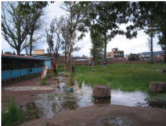
Foto IMTA 2003. Muestra encharcamientos de una escuela primaria, cuya barda al final del predio corresponde al final de la calle Ireti Ticateme, por donde ingresan las aguas pluviales que proceden desde la Avenida Ventura Puente. Las actividades de esta escuela se suspenden hasta que baja el agua encharcada.
