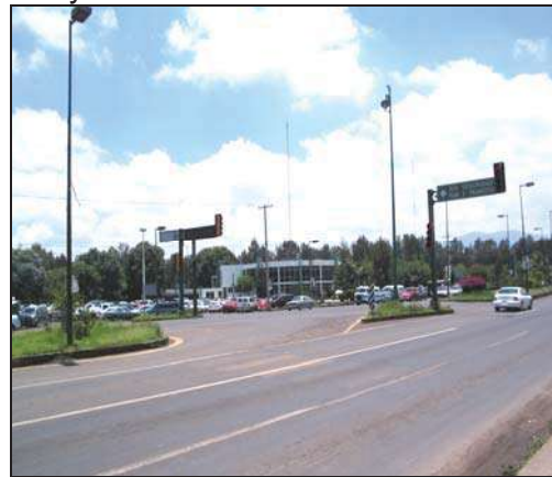
Foto IMTA 2004. Edificios de Policía y Tránsito, y PGR que se inundan a una altura de 1.60 metros por
