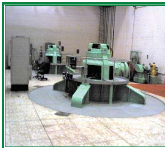
Sitio de la planta de generación eléctrica El Cóbano
