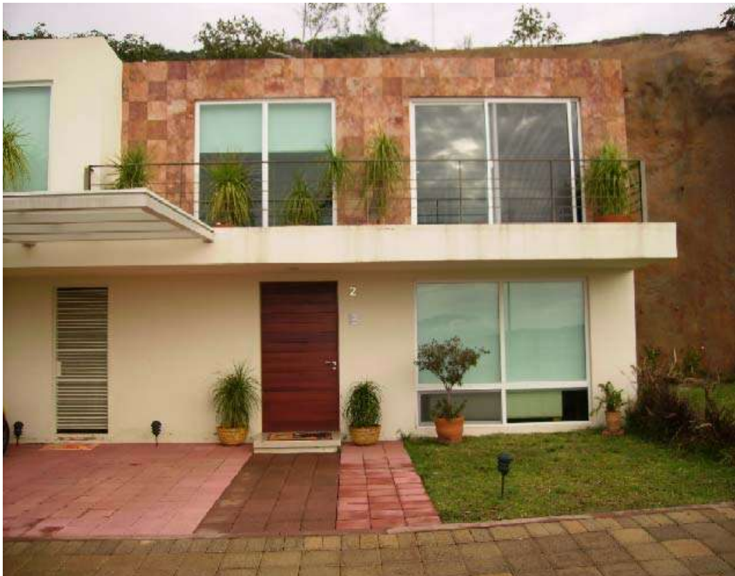
Fachada principal de una de las viviendas
