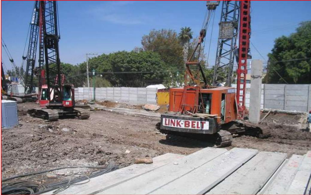
**Figura VI.8.-** Equipo de hincado de tablestaca.
