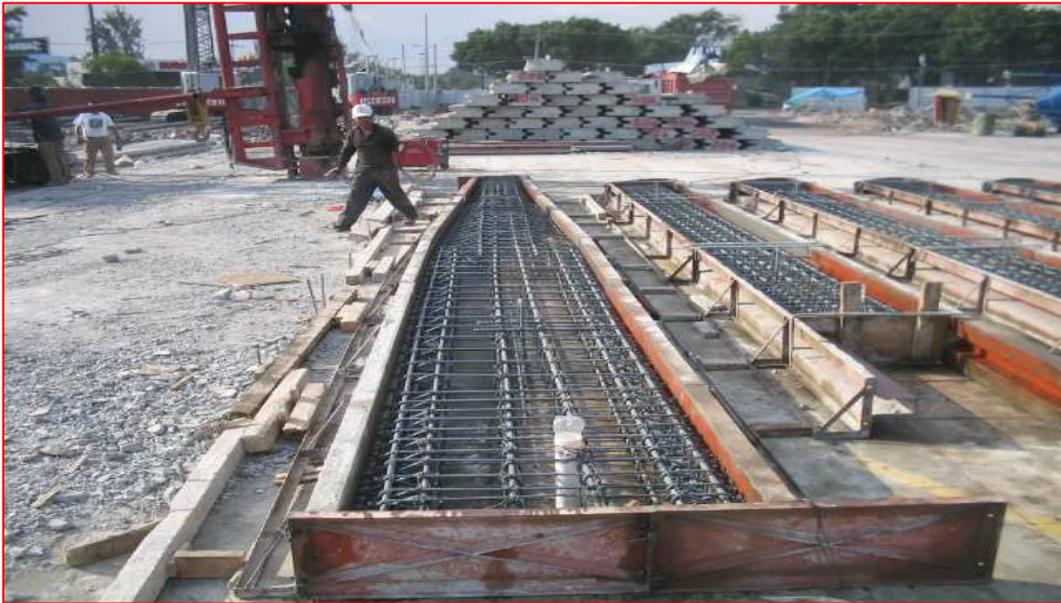
**Figura VI.4b.-** Cimbrado para colado del tablestacado
