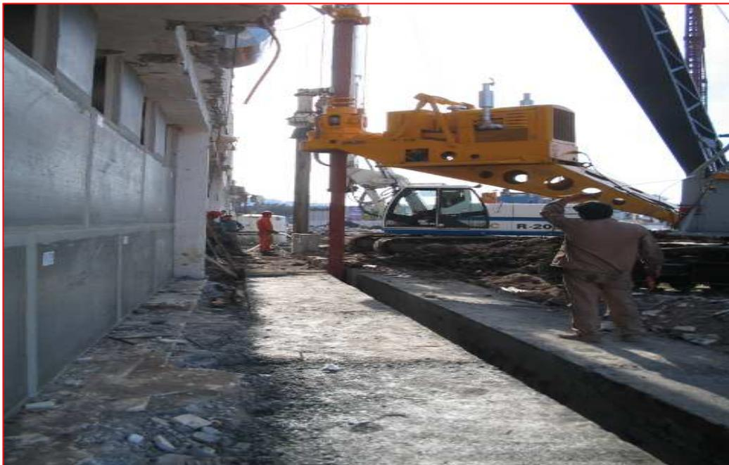
**Figura VI.7 .-** Perforación guía para hincado de tablestacas.
