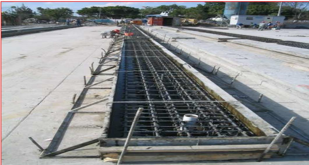
**Figura VI.4a**.- Armado del tablestacado.
