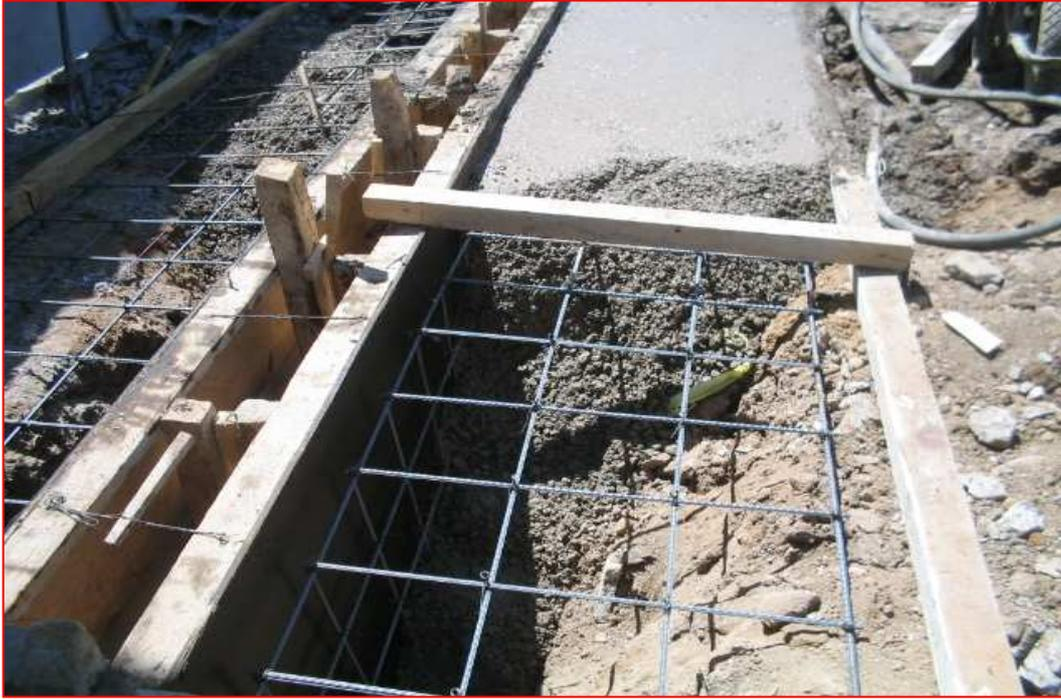
**Figura VI.6.-** Construcción de brocal para guía de tablestacas
