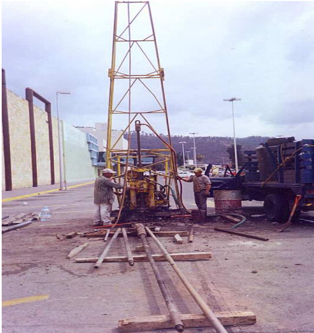
**Figura III.3.-** Equipo para estudio de Mecánica de Suelos.
