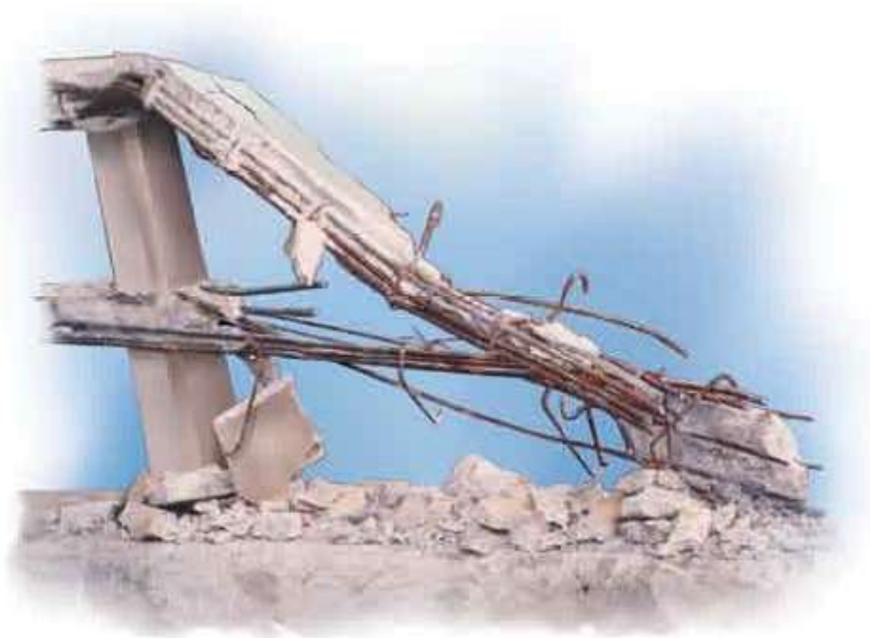
Fig. 22. Resultado de la transformación molecular de la estructura del concreto debido a los cloruros y sulfatos. 3
