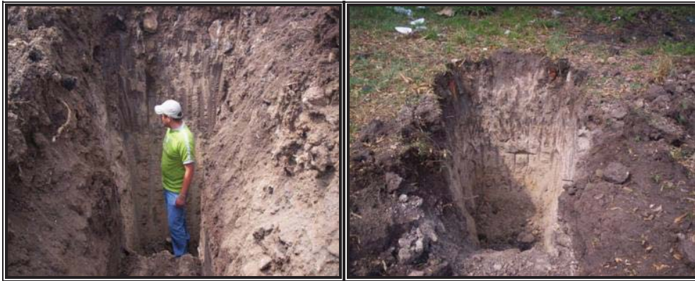
(Figura 5.4). _Pozos a cielo abierto para la exploración de suelos.
