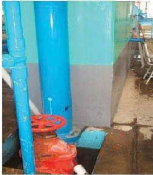
Fotografía V-3. Válvula de Seccionamiento
