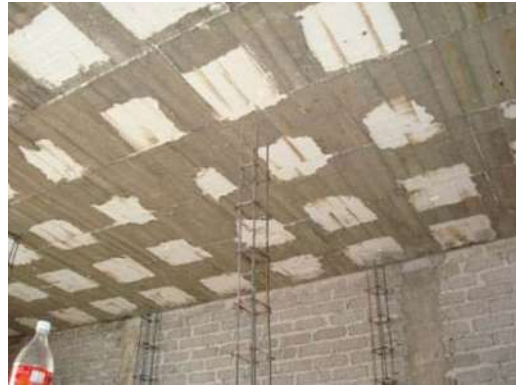
Confinamiento con castillos.
