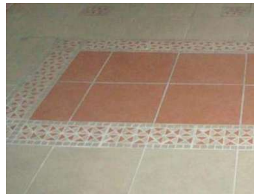
Pegado y emboquillado.
