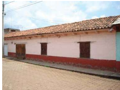
Casa en pueblo, mpio. Madero.
