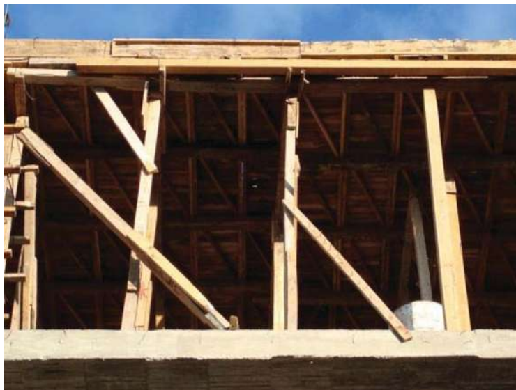
Vista del cimbrado para losas.
