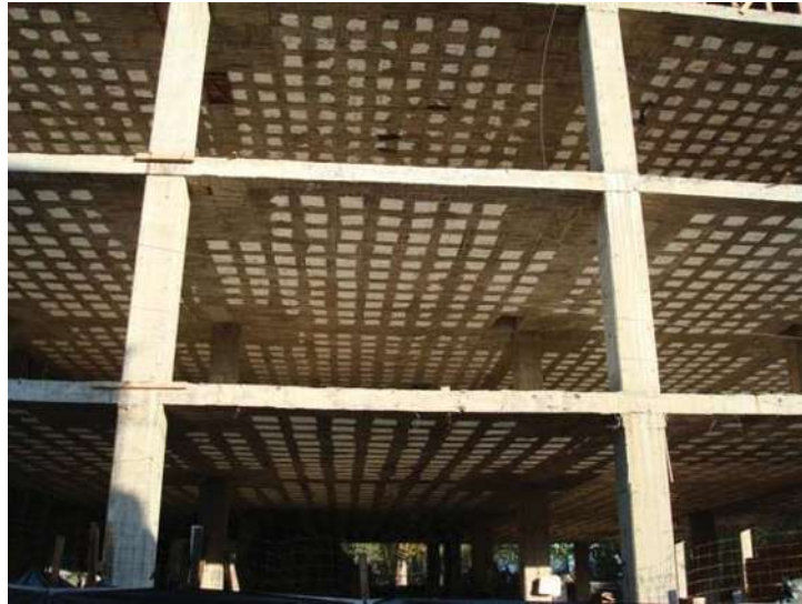
Vista general de los niveles de la ESTRUCTURA DE CONCRETO.
