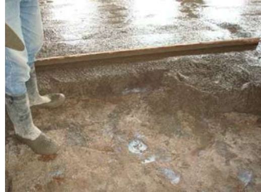
Colocación de sobre-firmes en losas.
