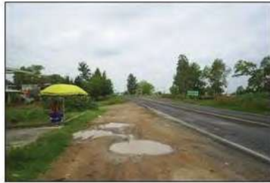
ACERCAMIENTO DONDE SE OBSERVA LA ESTACIÓN DE AFORO
