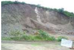
OTRA VISTA DEL FRENTE DE ATAQUE DEL BANCO DE MATERIALES
